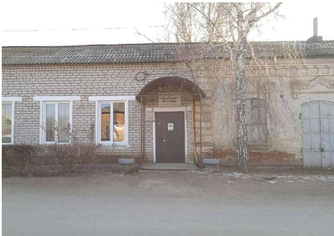
Фото 3. Вид на примыкание пристройки (в настоящее время - редакция газеты «Донской вестник») к зданию бывшей торговой лавки по ул. Буденного, 71.
