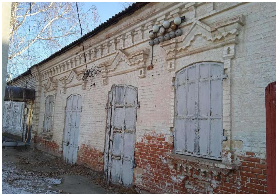
Фото 2. Кованые ставни на двери и окна северо-западного фасада здания по ул. Буденного, 71. Фрагмент.
