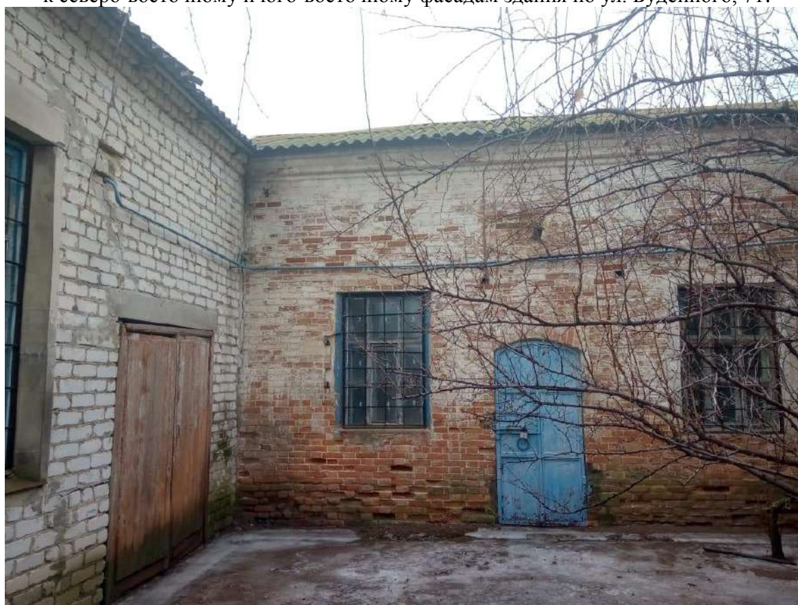
Фото 10. Вид на северо-восточный фасад дворового флигеля здания по ул. Буденного, 71 (фрагмент) и часть пристройки к его юго-восточному фасаду.
