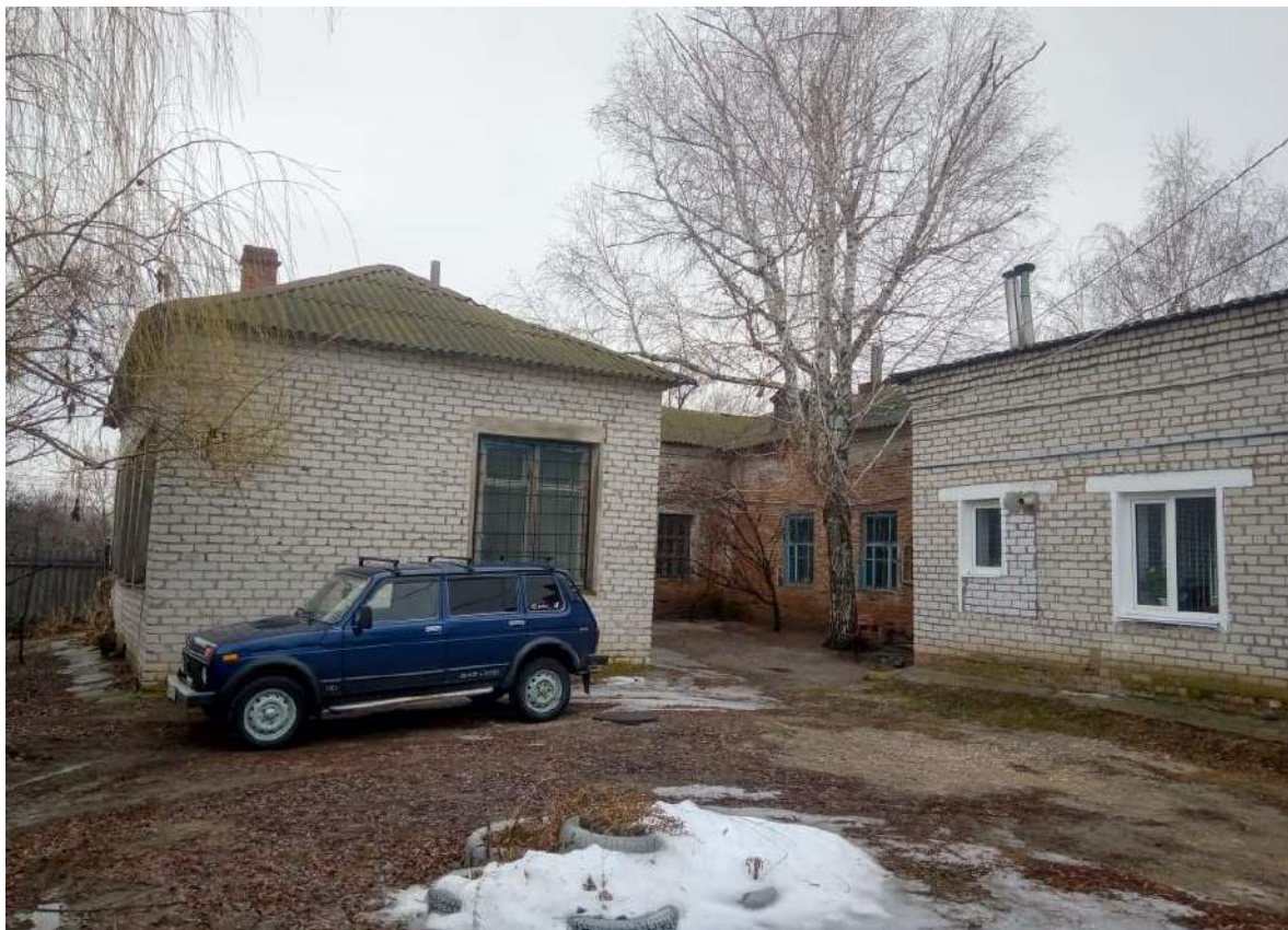
Фото 9. Вид с востока на дворовую территорию, образованную пристройками: к северо-восточному и юго-восточному фасадам здания по ул. Буденного, 71.
