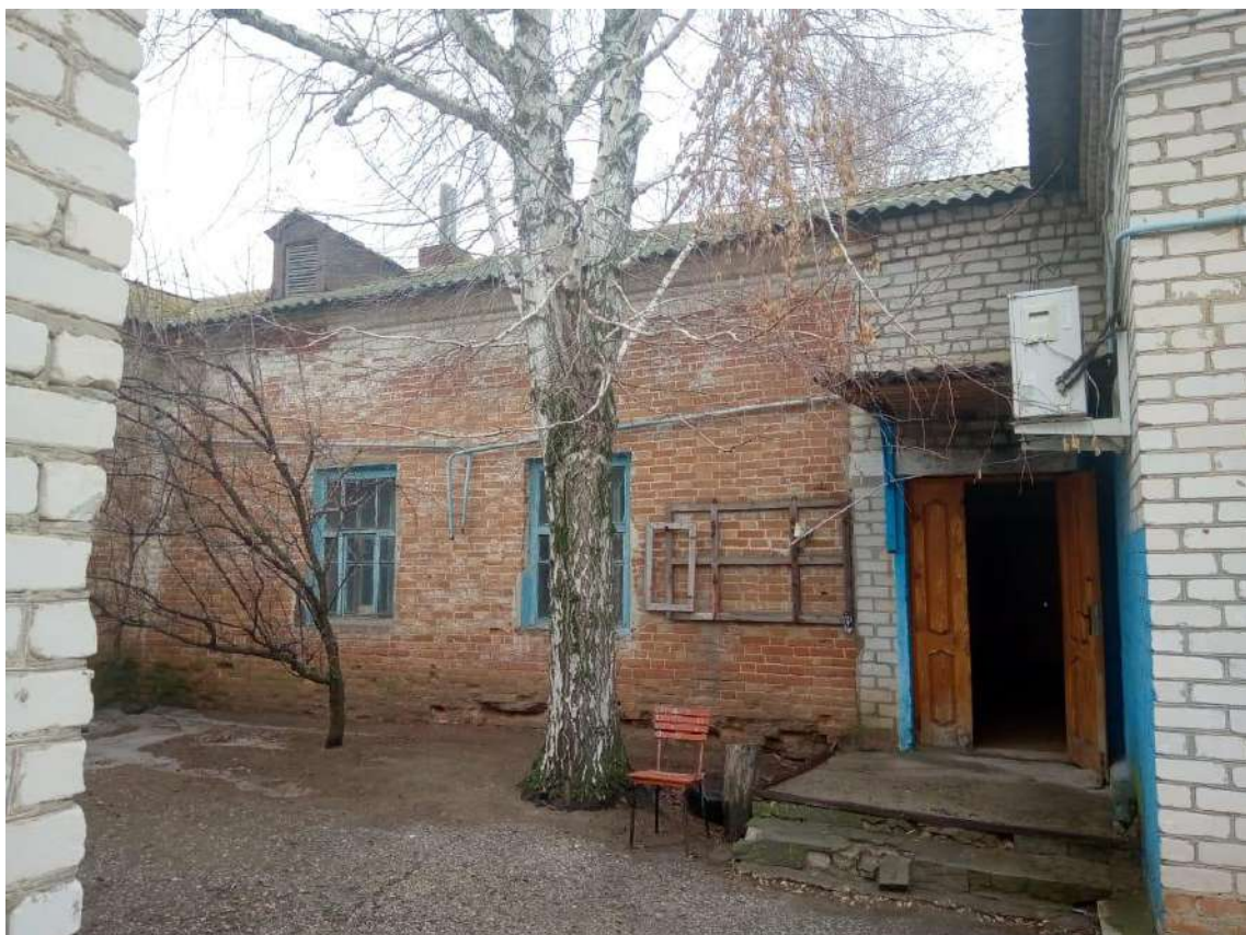
Фото 11. Дворовый фасад здания по ул. Буденного, 71 в месте примыкания к северо-восточному торцевому фасаду.
