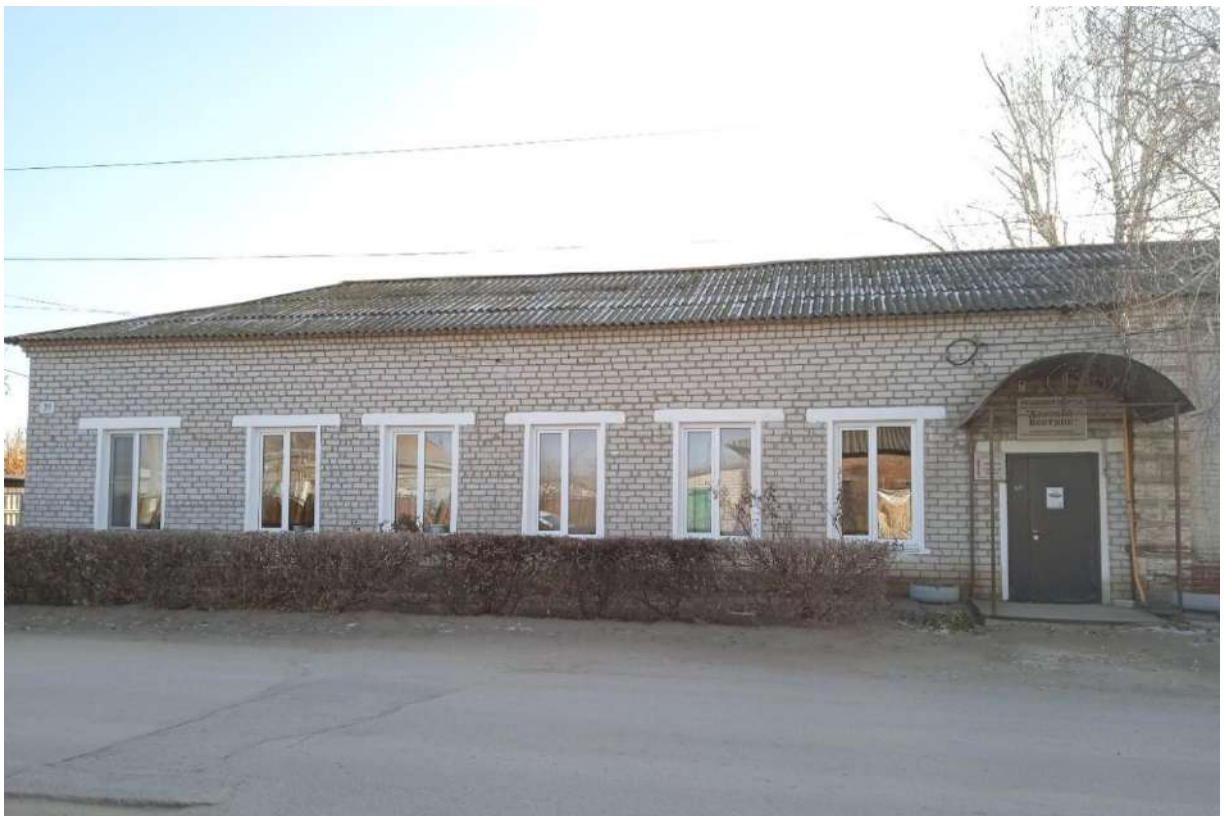
Фото 5. Вид с северо-запада на пристройку к северо-восточному фасаду здания по адресу ул. Буденного, 71.
