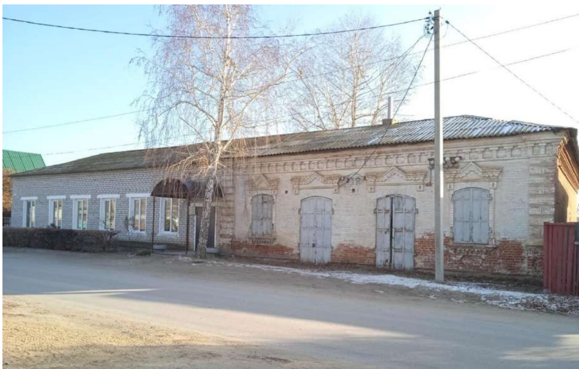
Общий вид на лицевой северо-западный фасад
