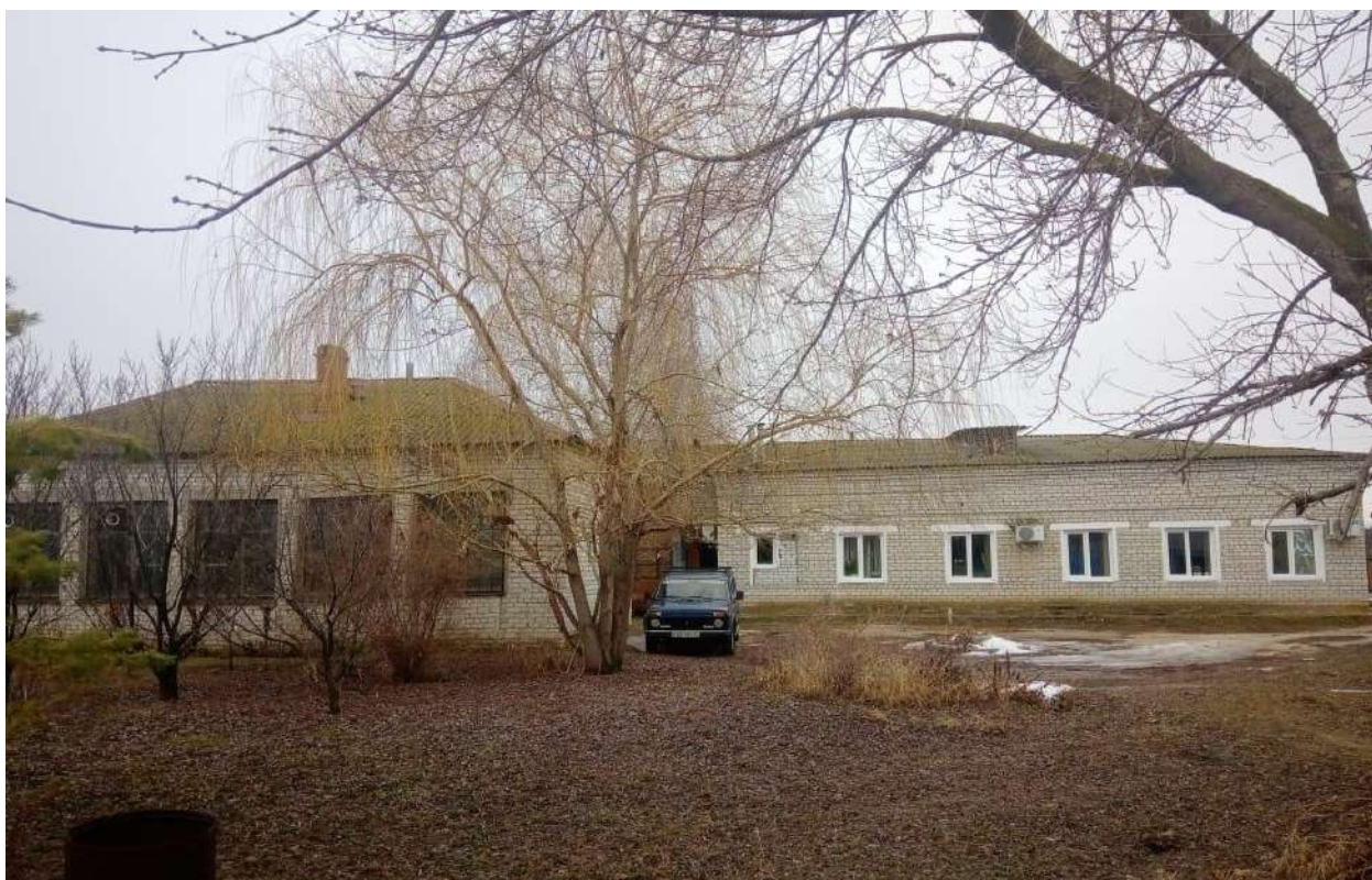
Фото 8. Вид с юго-востока на дворовую территорию, образованную пристройками: к северо-восточному и юго-восточному фасадам здания по ул. Буденного, 71.
