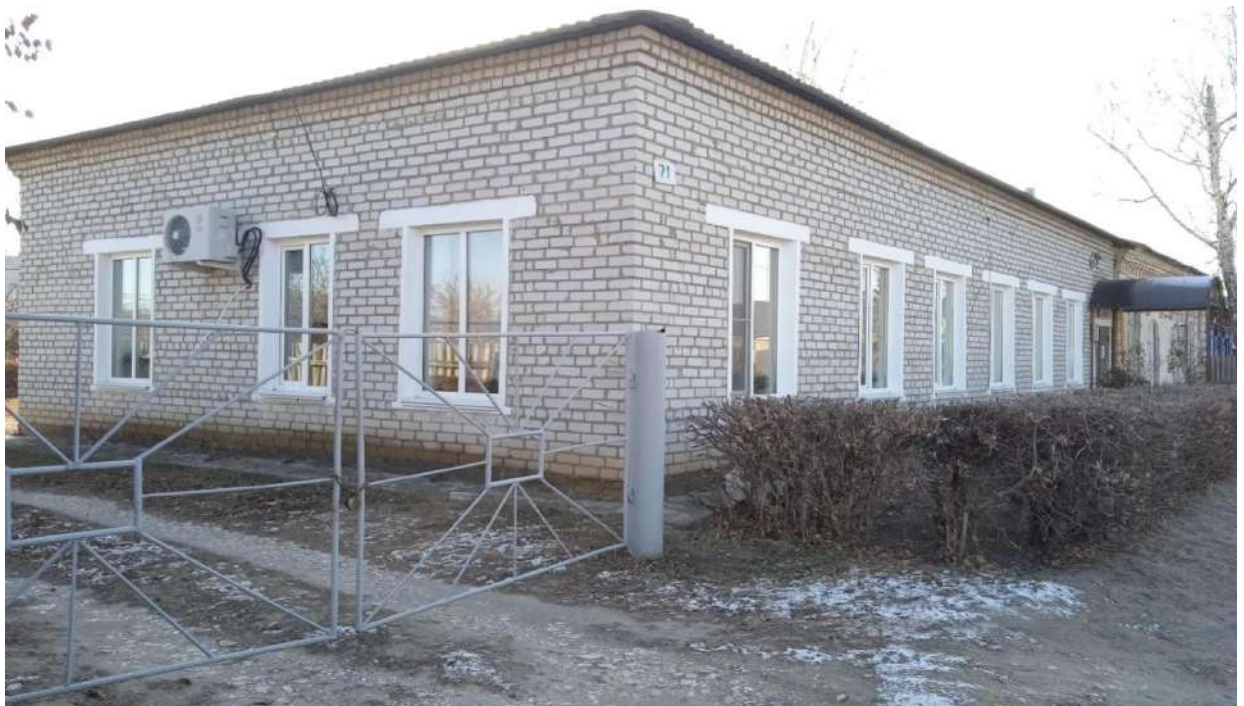
Фото 6. Вид на пристройку к зданию по адресу ул. Буденного, 71 с севера; северо-западный и северо-восточный фасады.
