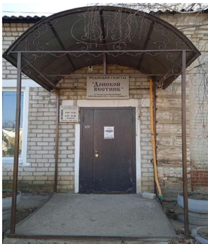
Фото 4. Ближний вид на главный вход в помещение редакции газеты «Донской вестник» на северо-западном фасаде пристройки.
