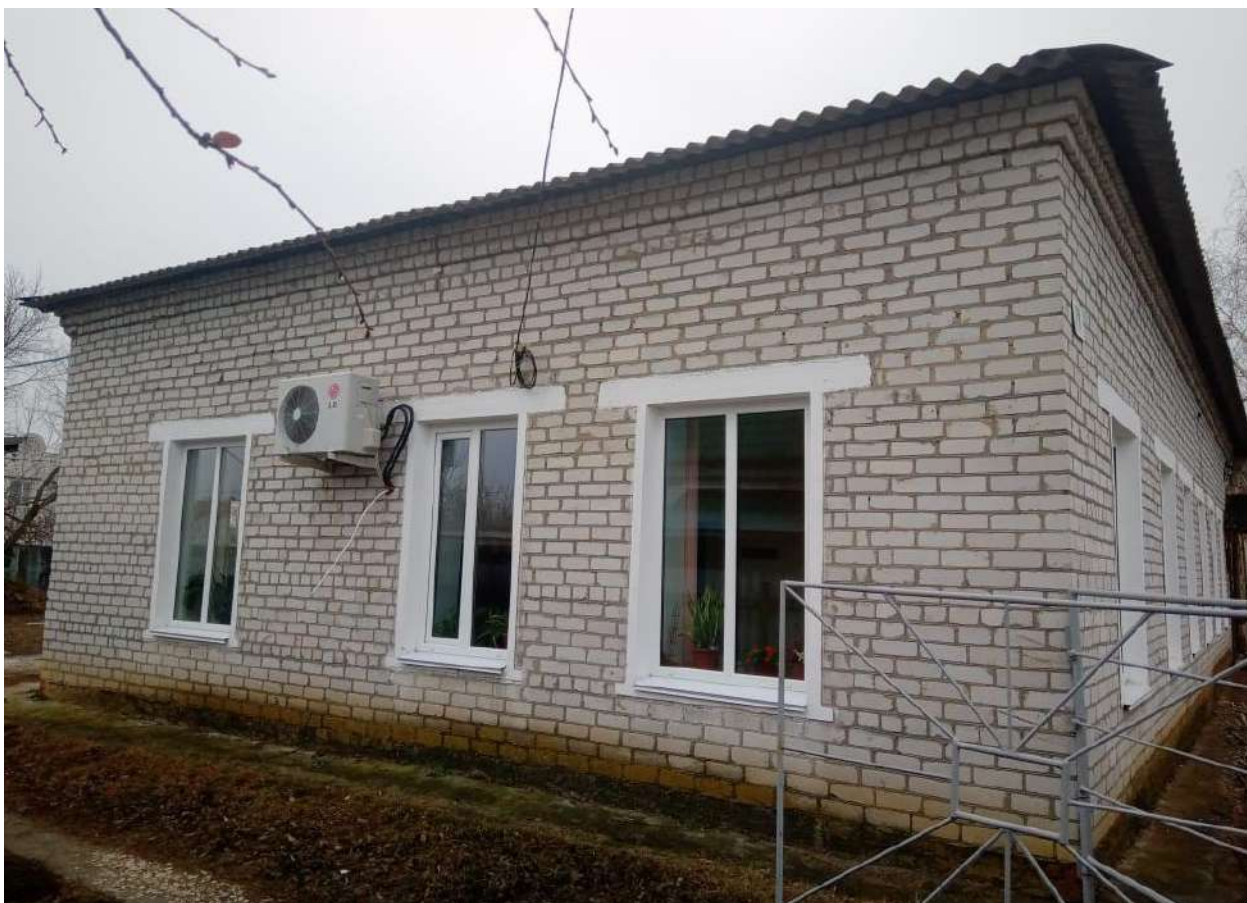
Фото 7. Вид на северо-восточный фасад пристройки.
