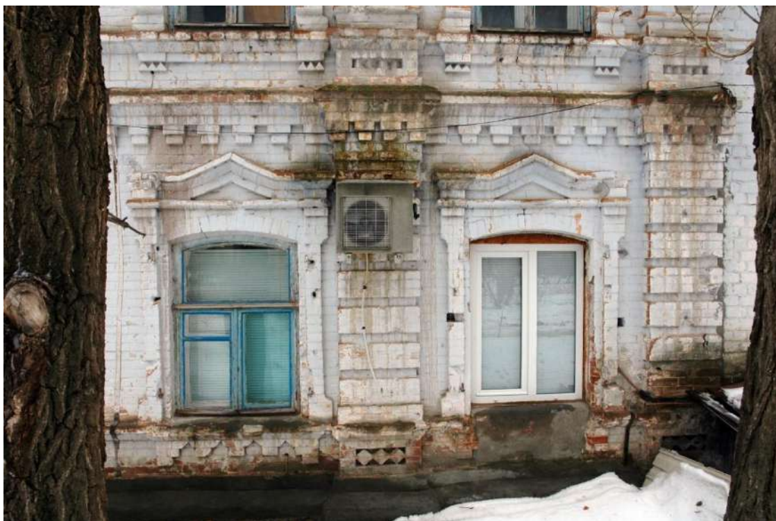
Фото 9. Северо-восточный фасад здания (фрагмент): архитектурный декор окон первого этажа
