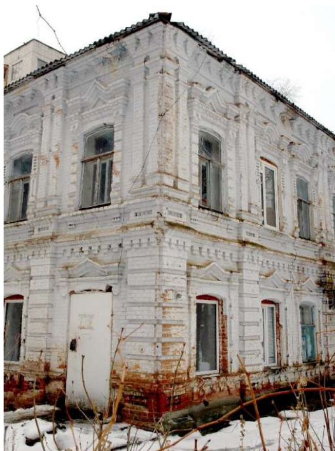
Фото 8. Вид на восточный угол здания
