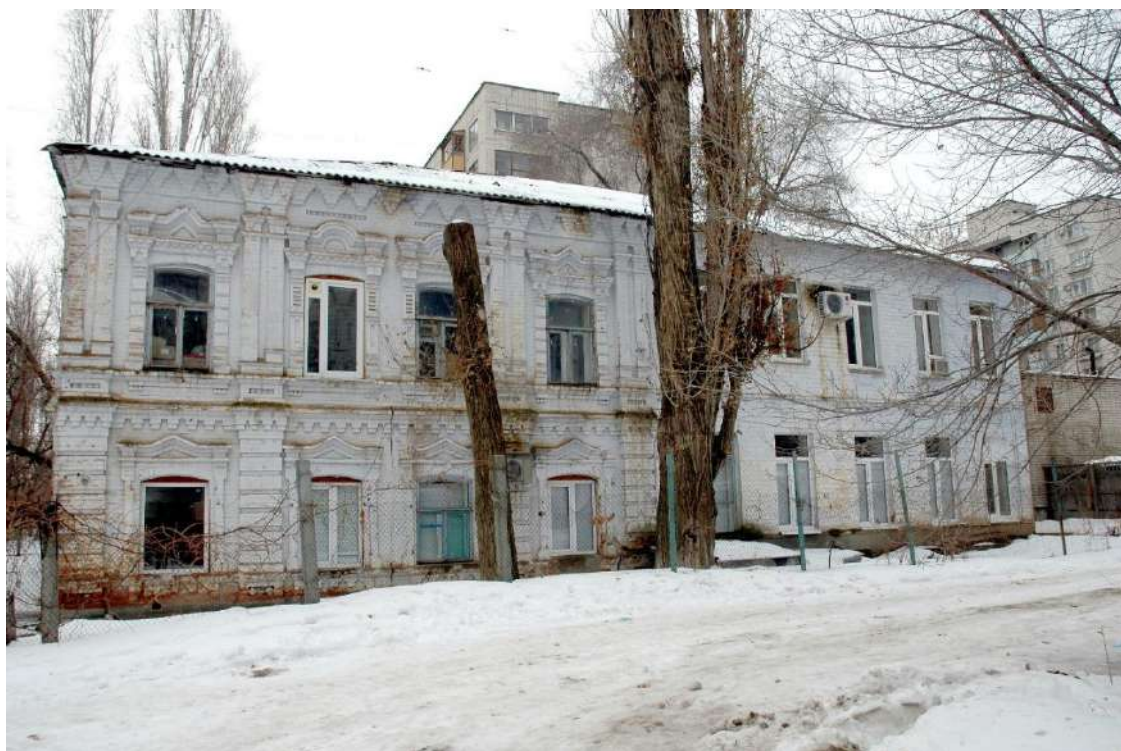
Фото 6. Вид на северо-восточный фасад здания и пристройку (объектом культурного наследия не является) к северо-западному дворовому фасаду
