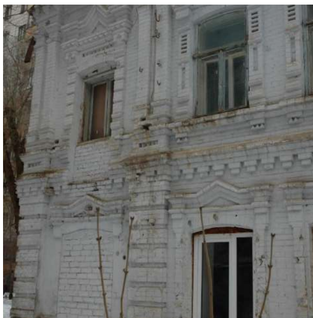
Фото 10. Юго-восточный фасад здания (фрагмент): архитектурный декор окон первого и второго этажей
