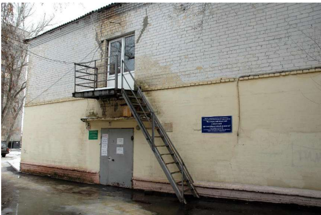
Фото 3. Вид на северо-западный фасад пристройки (объектом культурного наследия не является)
