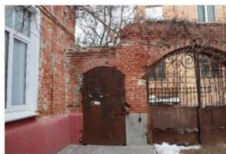
Фото 16. Волгоградская область, г. Волгоград, Ворошиловский район, ул. Пугачевская, 3. Фрагмент кирпичного забора. Калитка.
