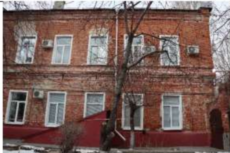
Фото 7 Волгоградская область, г. Волгоград, Ворошиловский район, ул. Пугачевская, 3. Дворовой фасад.
