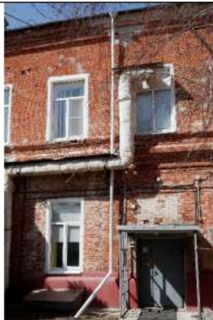
Фото 9. Волгоградская область, г. Волгоград, Ворошиловский район, ул. Пугачевская, 3. Дворовой фасад. Восстановленные участки кладки.
