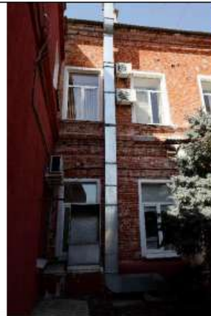
Фото 10 Волгоградская область, г. Волгоград, Ворошиловский район, ул. Пугачевская, 3. Дворовой фасад.
