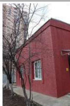
Фото 14. Волгоградская область, г. Волгоград, Ворошиловский район, ул. Пугачевская, 3. Пристройка.
