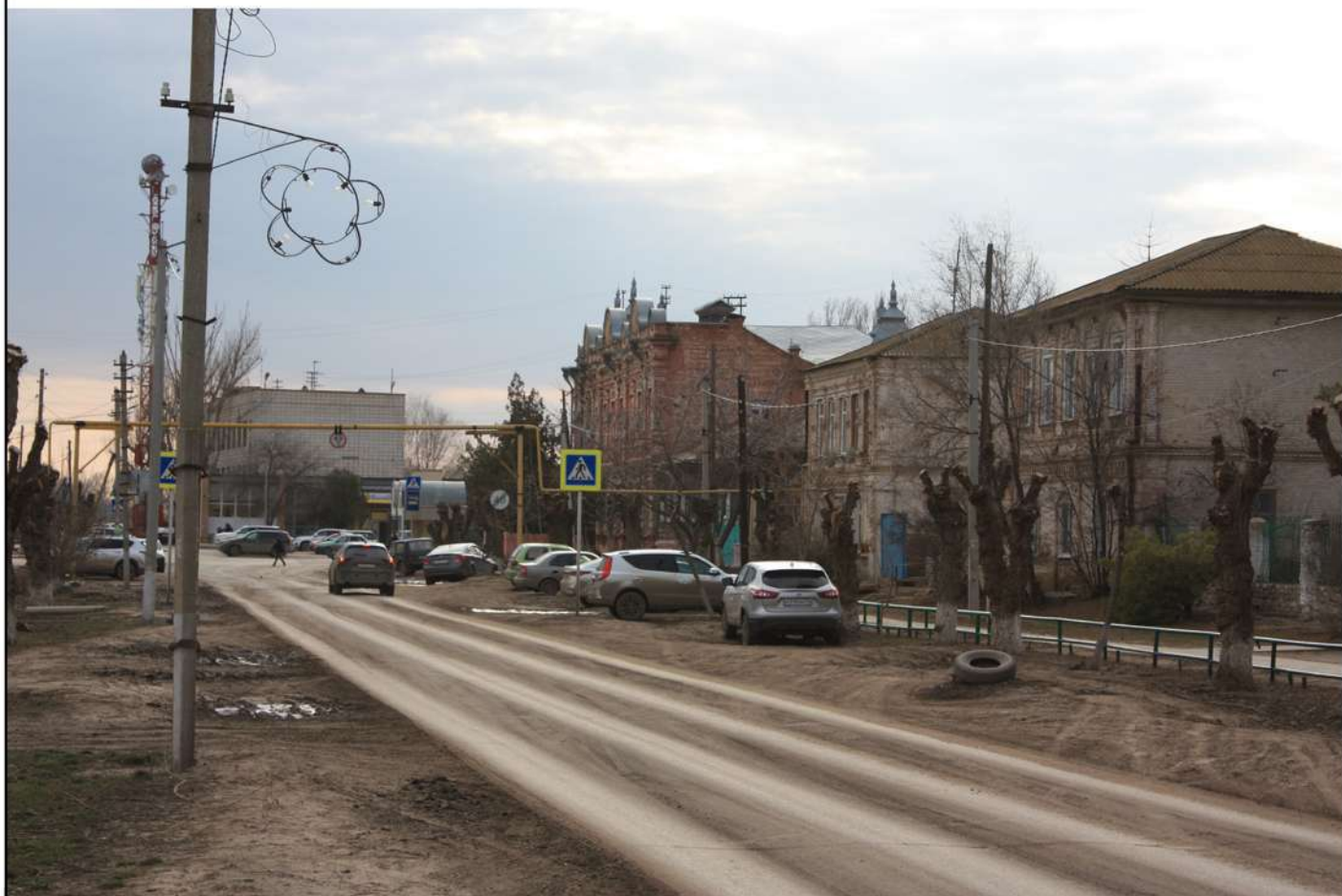
Фото 36. Частичное визуальное раскрытие здания по ул. Ленина, 233 (дом купца Конякина), входящего в состав "Ансамбля застройки центра города Пришиб (Ленинска)" XIX-XX вв. с северо-восточного направления улицы Ленина
