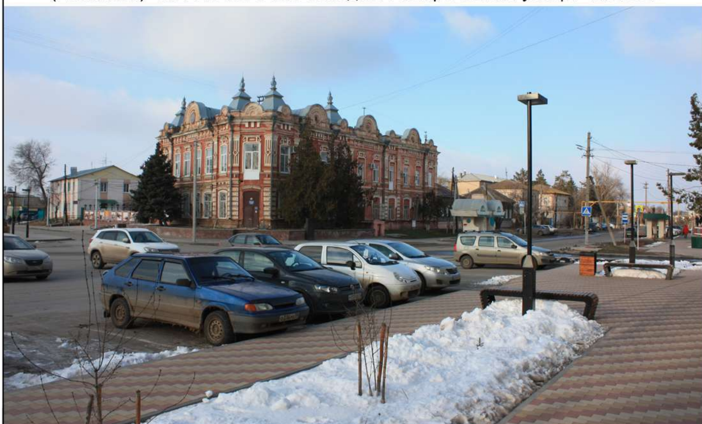
Фото 30. Наилучшее визуальное раскрытие здания по ул. Ленина, 233 (дом купца Конякина), входящего в состав "Ансамбля застройки центра города Пришиб (Ленинска)" XIX-XX вв. с юго-западного направления улицы Чапаева
