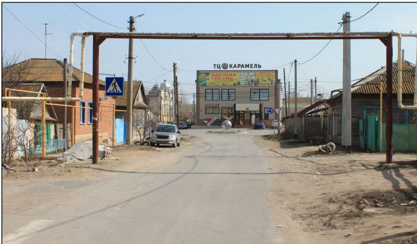
Фото 11. Начало визуального раскрытия здания по ул. Комсомольская, 3 (здание банка), входящего в состав "Ансамбля застройки центра города Пришиб (Ленинска)" XIX-XX вв. с северо-западного направления улицы Карла Маркса
