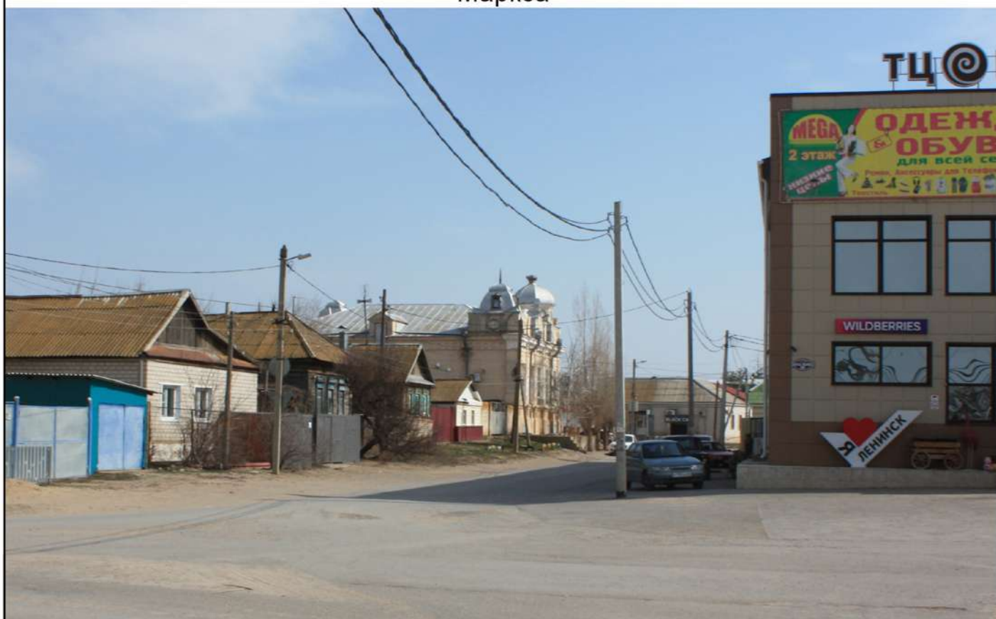
Фото 12. Частичное визуальное раскрытие здания по ул. Комсомольская, 3 (здание банка), входящего в состав "Ансамбля застройки центра города Пришиб (Ленинска)" XIX-XX вв. с северо-западного направления улицы Карла Маркса
