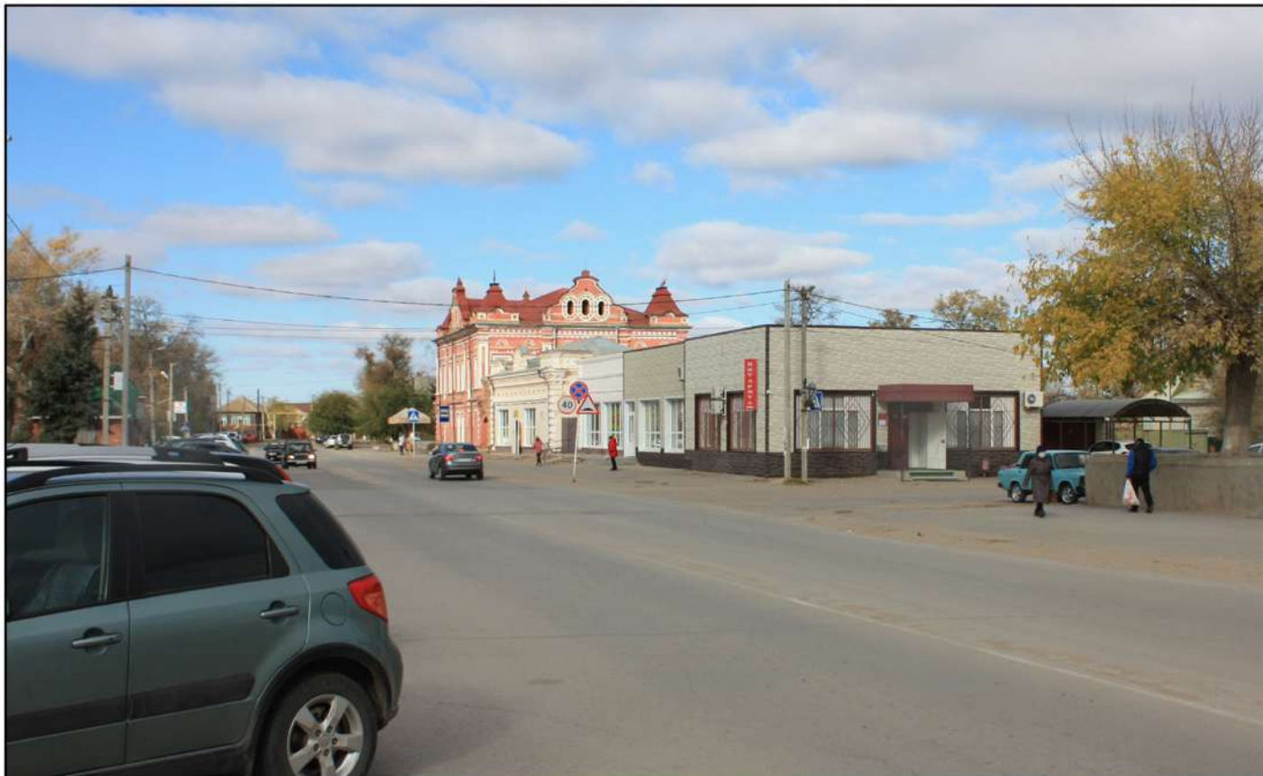
Фото 7. Полное визуальное раскрытие здания по ул. Ленина, 211а (дом купца Коновалова), входящего в состав "Ансамбля застройки центра города Пришиб (Ленинска)" XIX-XX вв. с юго-восточного направления улицы Ленина
