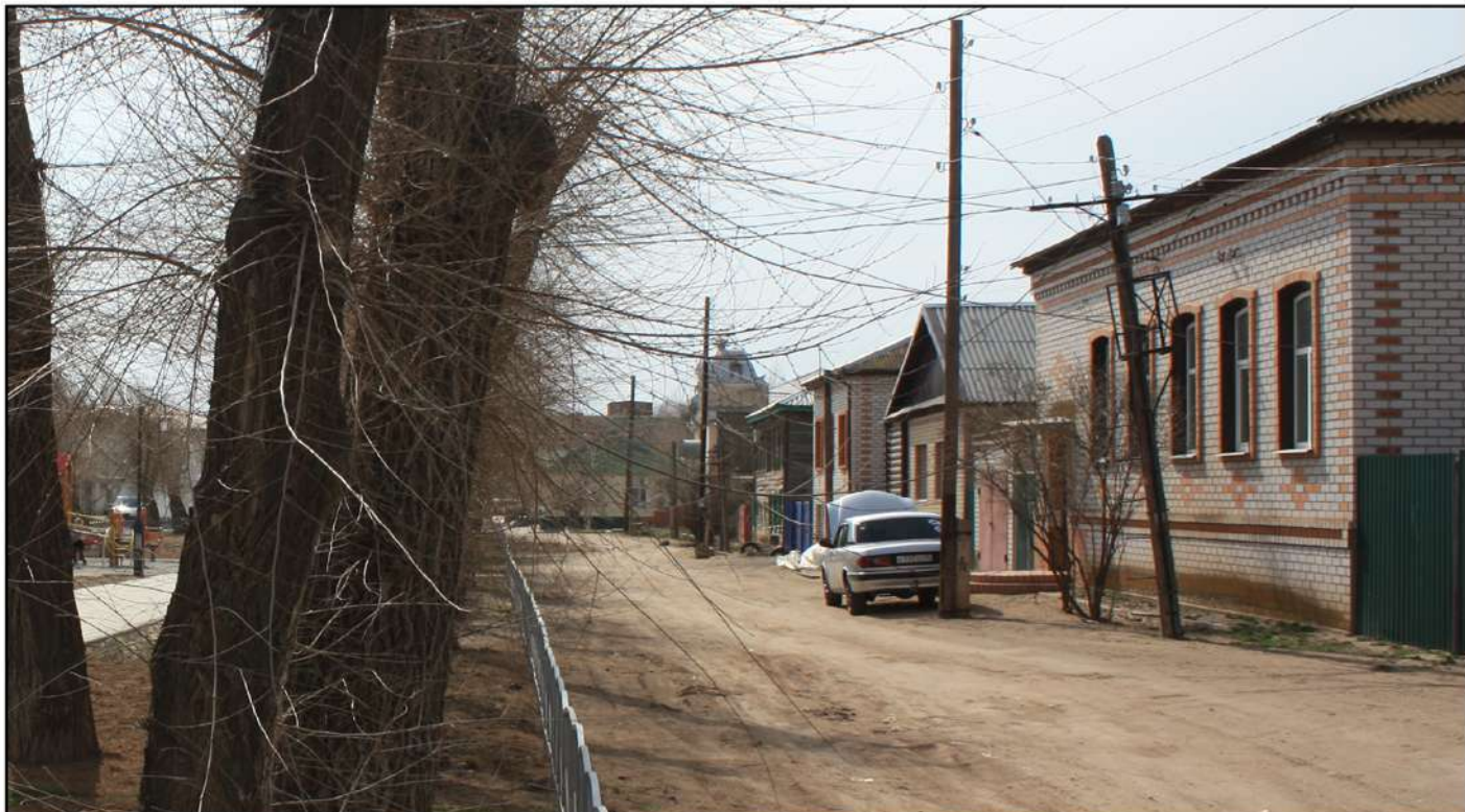
Фото 17. Начало визуального раскрытия здания по ул. Комсомольская, 3 (здание банка), входящего в состав "Ансамбля застройки центра города Пришиб (Ленинска)" XIX-XX вв. с северо-восточного направления улицы Комсомольской
