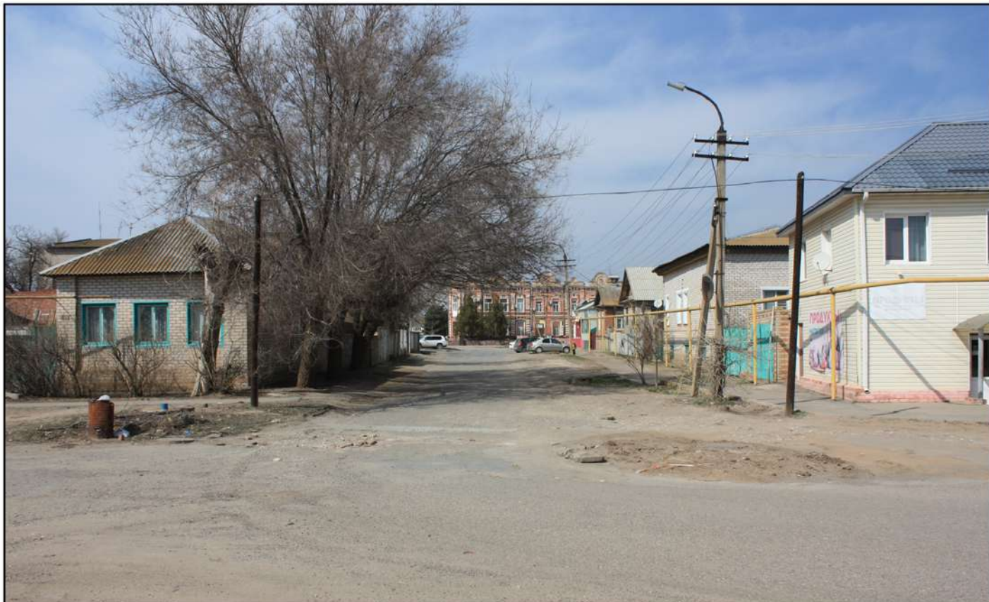
Фото 31. Начало визуального раскрытия здания по ул. Ленина, 233 (дом купца Конякина), входящего в состав "Ансамбля застройки центра города Пришиб (Ленинска)" XIX-XX вв. с юго-восточного направления переулка Куйбышева
