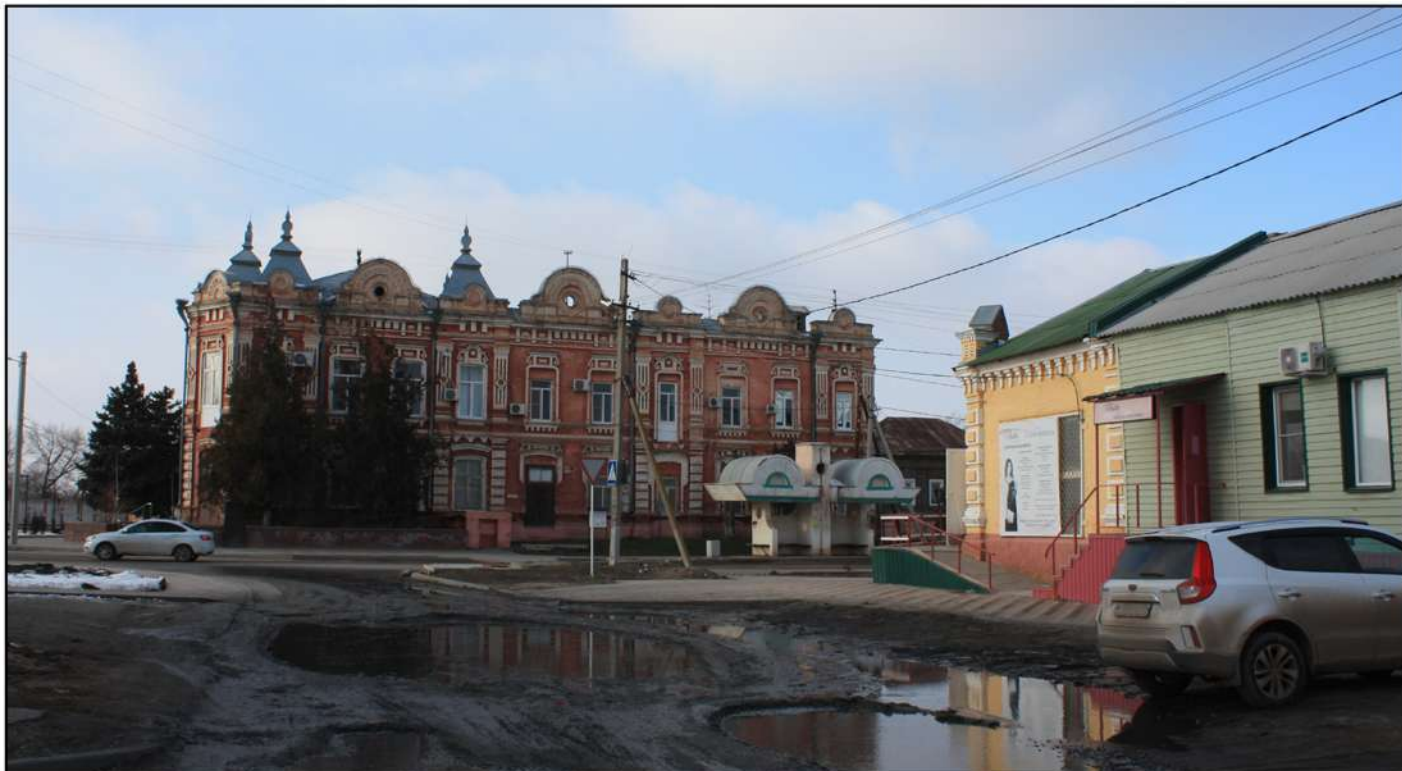
Фото 33. Полное визуальное раскрытие здания по ул. Ленина, 233 (дом купца Конякина), входящего в состав "Ансамбля застройки центра города Пришиб (Ленинска)" XIX-XX вв. с юго-восточного направления переуллка Куйбышева
