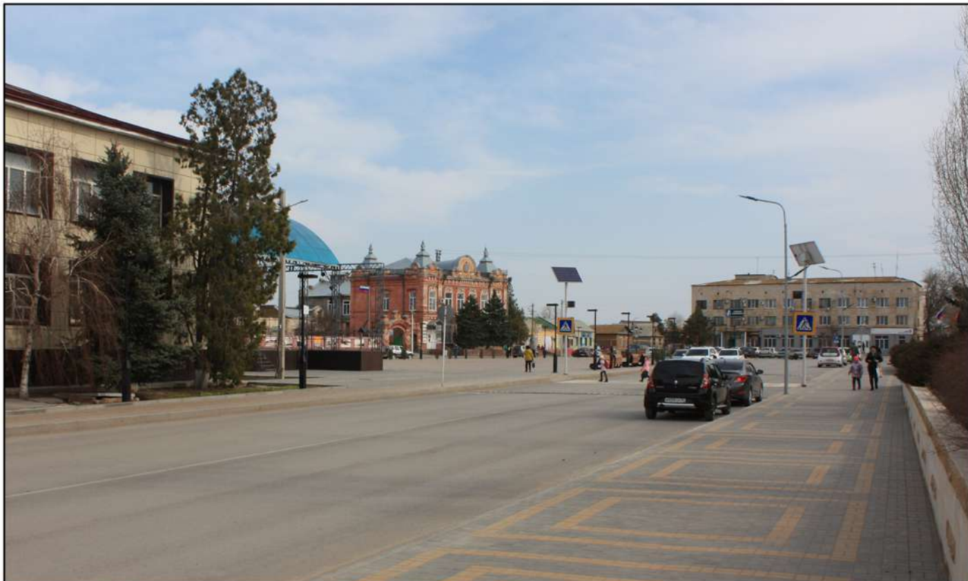
Фото 23. Начало визуального раскрытия здания по ул. Ленина, 233 (дом купца Конякина), входящего в состав "Ансамбля застройки центра города Пришиб (Ленинска)" XIX-XX вв. с северо-западного направления улицы Ленина
