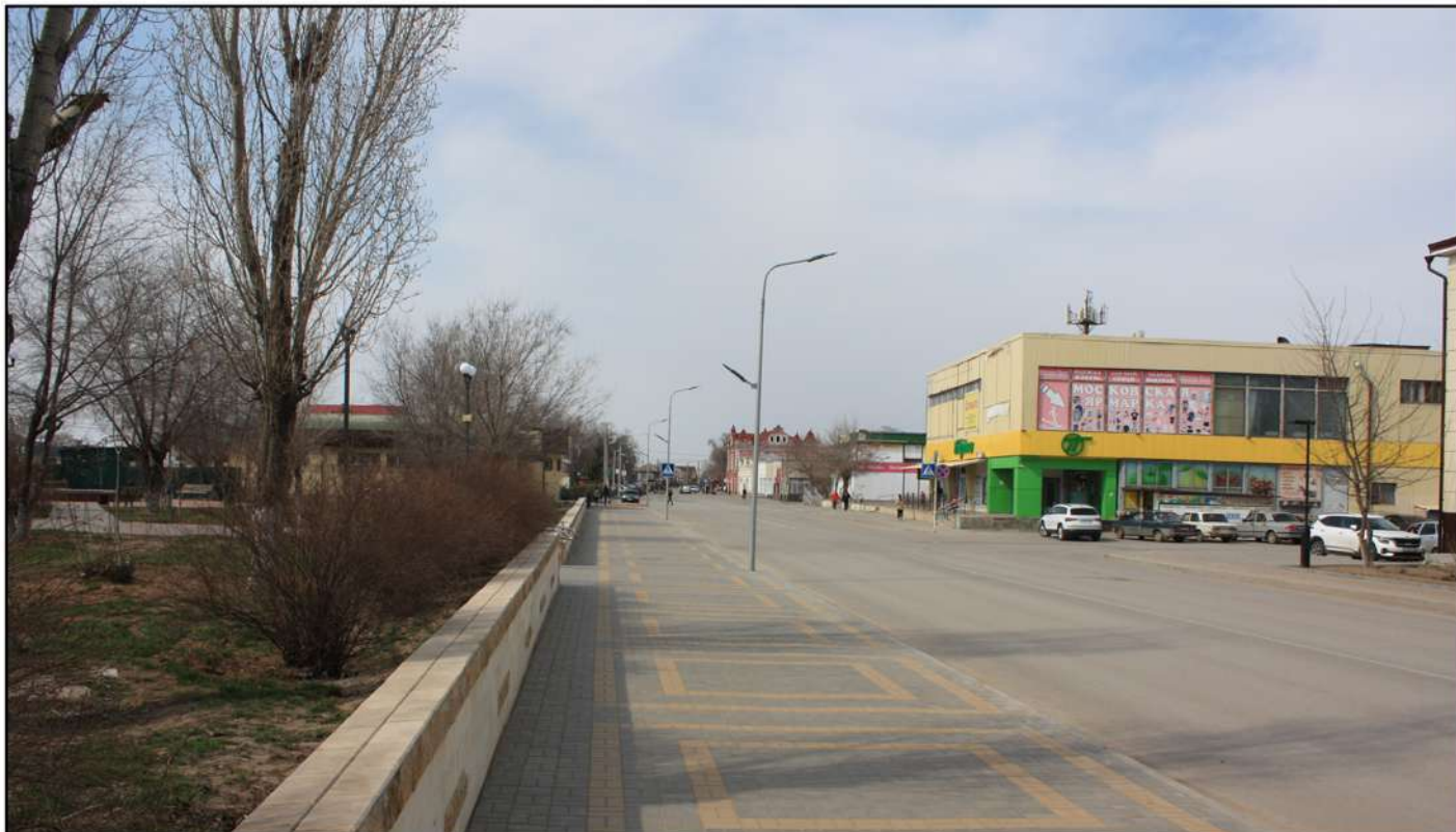
Фото 5. Начало визуального раскрытия здания по ул. Ленина, 211а (дом купца Коновалова), входящего в состав "Ансамбля застройки центра города Пришиб (Ленинска)" XIX-XX вв. с юго-восточного направления улицы Ленина
