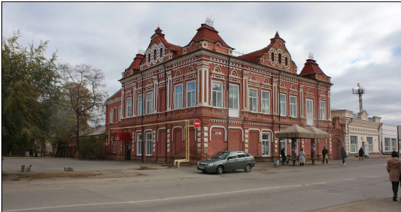
Фото 3. Наилучшее визуальное раскрытие здания по ул. Ленина, 211а (дом купца Коновалова), входящего в состав "Ансамбля застройки центра города Пришиб (Ленинска)" XIX-XX вв. с пересечения Красноармейского Переулка и улицы Ленина
