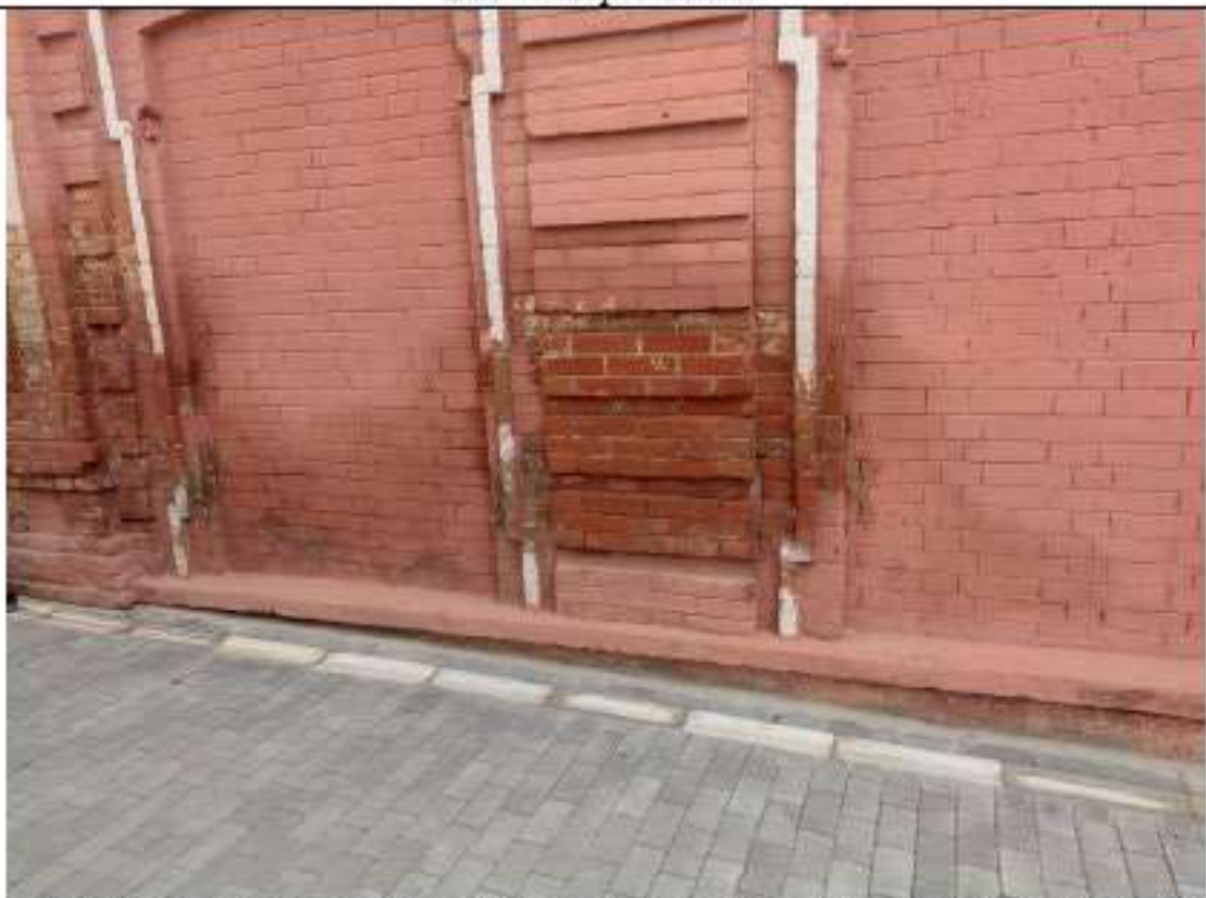
Фото 23. Волгоградская область, г. Волгоград, Ворошиловский район, ул. Академическая, 4 Вид с северо-запада.
