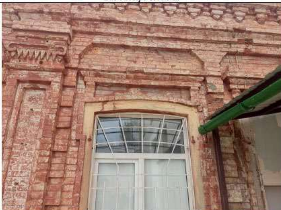
Фото 9. Волгоградская область, г. Волгоград, Ворошиловский район, ул. Академическая, 4 Вид с северо-запада.
