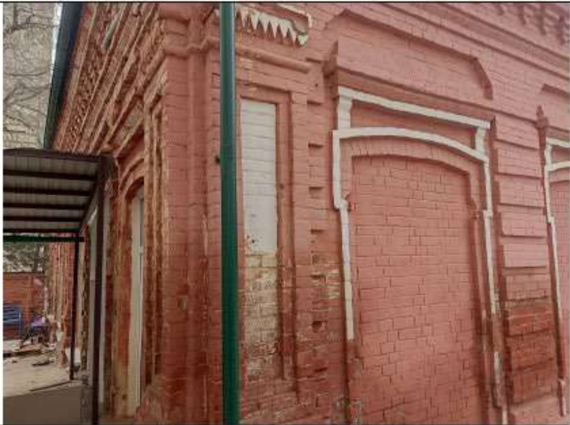
Фото 22. Волгоградская область, г. Волгоград, Ворошиловский район, ул. Академическая, 4 Вид с северо-запада.
