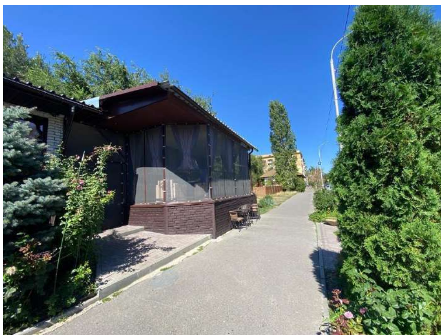
Фото №6. Вид на существующую террасу №2 ресторана «Сапери» в направлении с юга на север.
