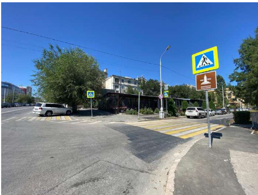
Фото №1. Общий вид объекта с перекрестка в направлении с юга на север.
