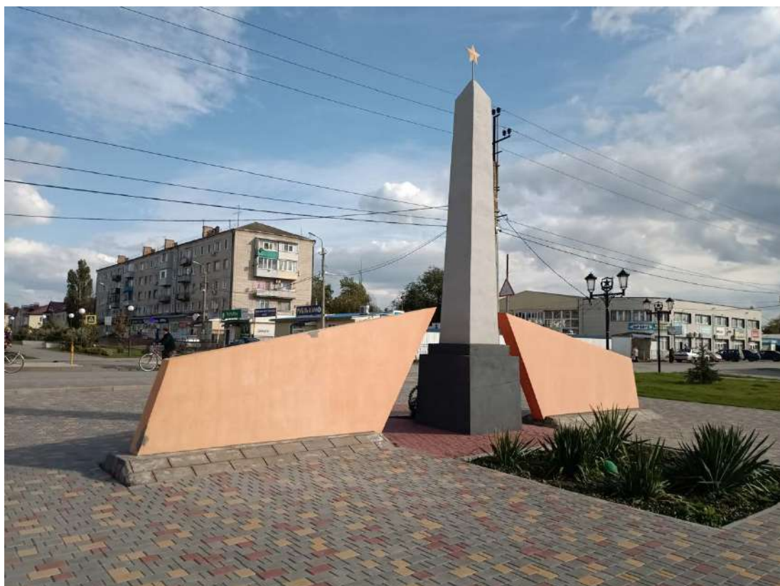
Фото 2. Вид мемориала с северо-западной стороны.
