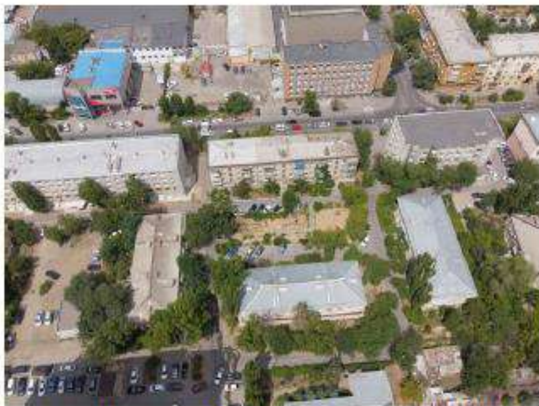
Фото 48. Воздушная фотофиксация территории объекта культурного наследия. Дата съемки: июль 2022 г.
