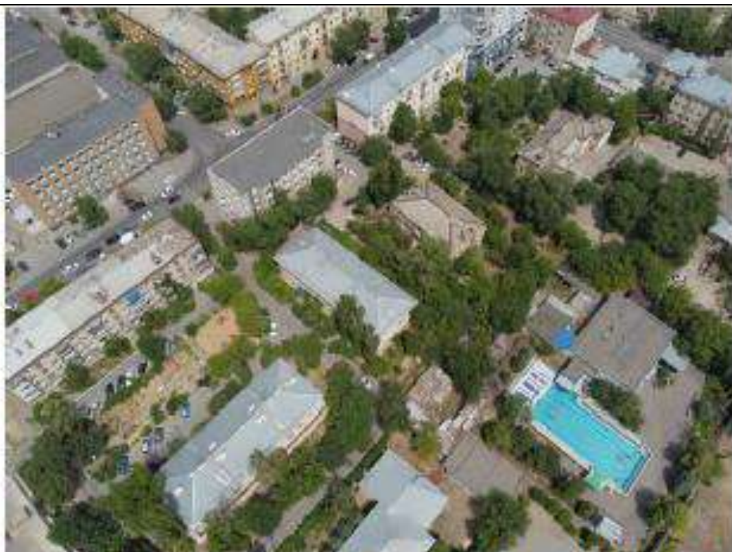
Фото 47. Воздушная фотофиксация территории объекта культурного наследия. Дата съемки: июль 2022 г.
