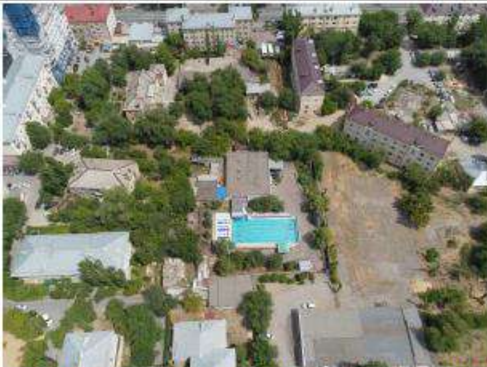
Фото 45. Воздушная фотофиксация территории объекта культурного наследия. Дата съемки: июль 2022 г.
