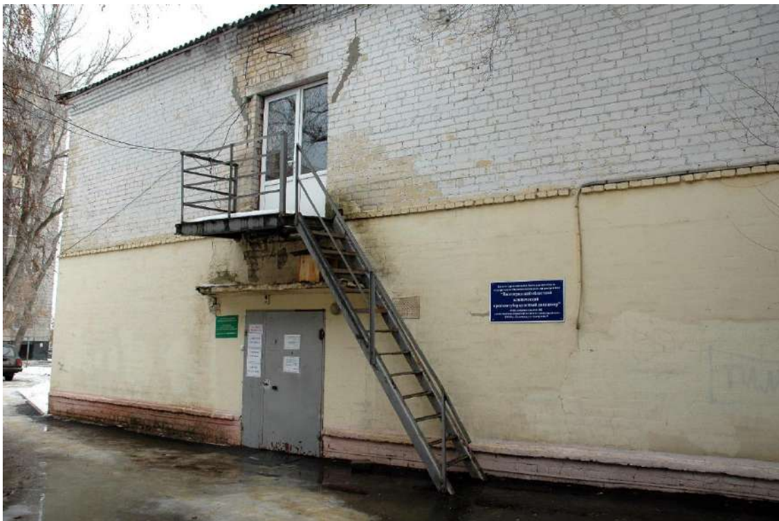
Фото 5. Вид на северо-западный фасад пристройки (объектом культурного наследия не является)
