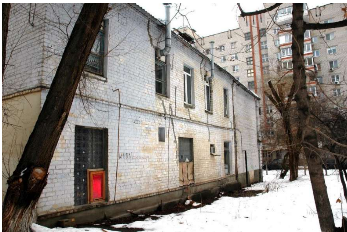
Фото 4. Вид на юго-западный фасад от западного угла здания
