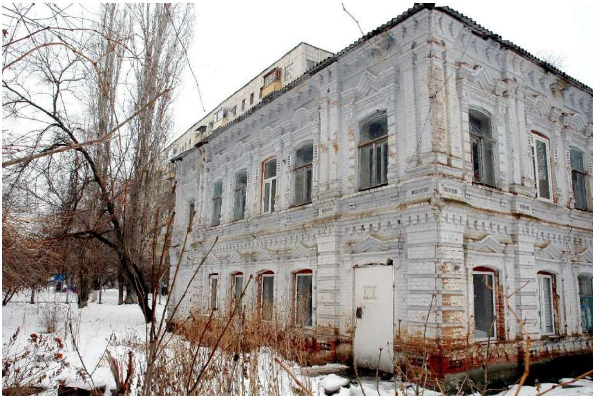
Фото 1. Вид на два декорированных фасада здания - выявленного объекта культурного наследия «Дом жилой» кон. XIX -нач. XX вв.: юго-восточный и северо-восточный
