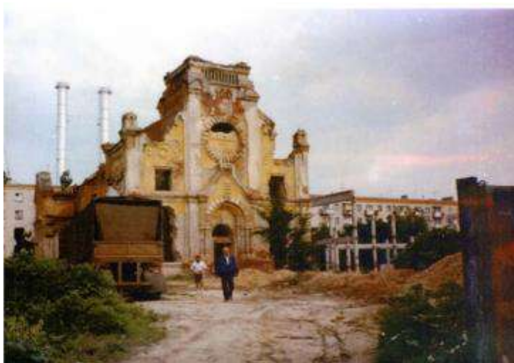
Илл.8. Архивное фото, 1990-е годы, начало реставрационных работ.
