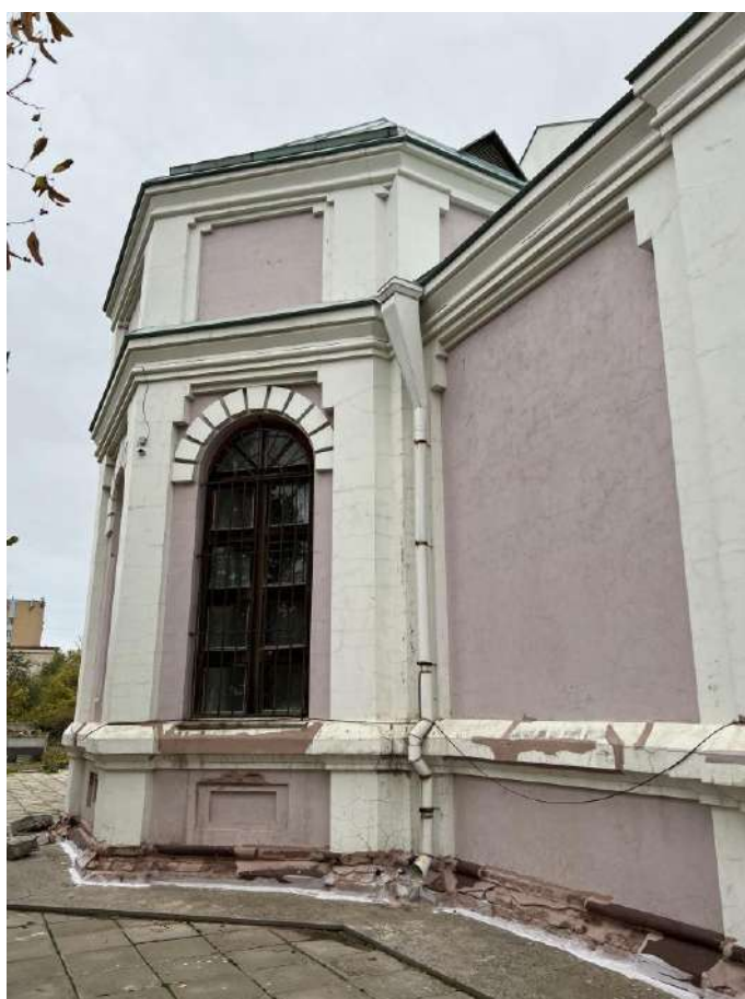
Фото №6. Фрагмент северо-западного фасада.
