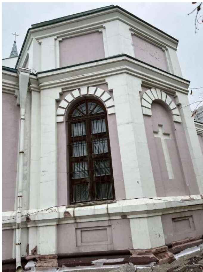
Фото №7. Фрагмент северо-западного фасада.
