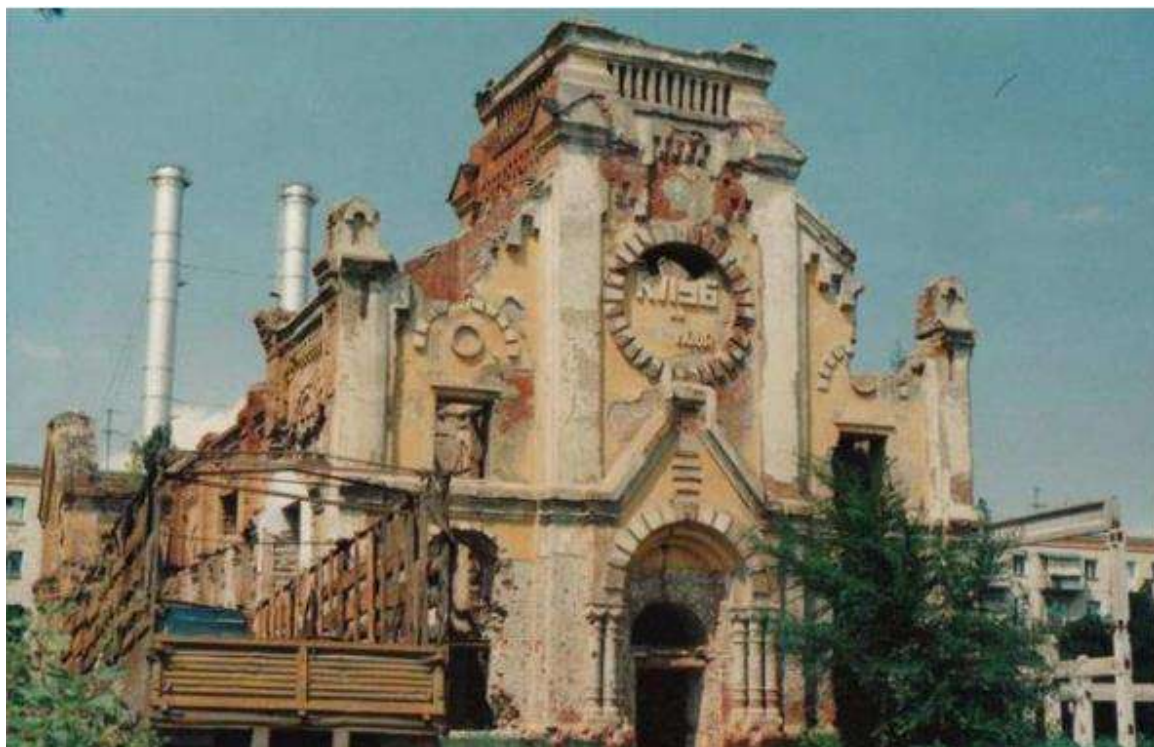
Илл.7. Архивное фото, 1990-е годы, начало реставрационных работ.
