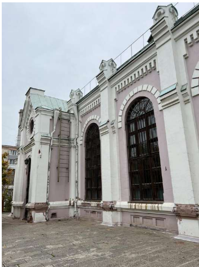
Фото №3. Юго-западный фасад, фрагмент.
