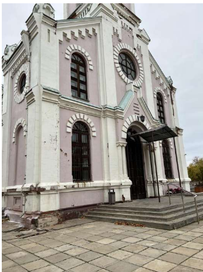
Фото №2. Юго-восточный фасад, входной портал.
