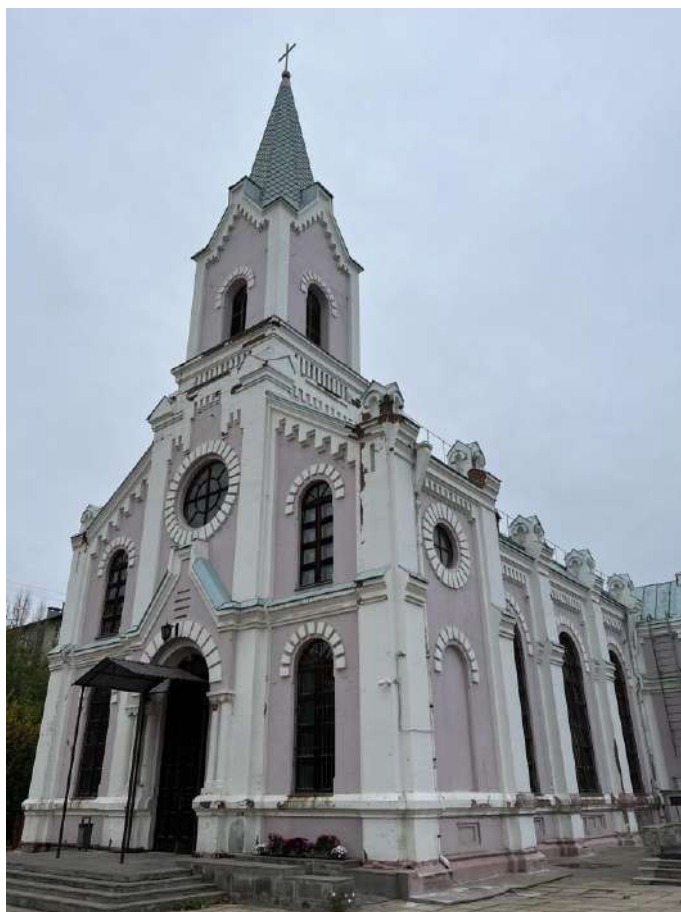
Фото №11. Вид на юго-восточный и северо-восточный фасады костела.
