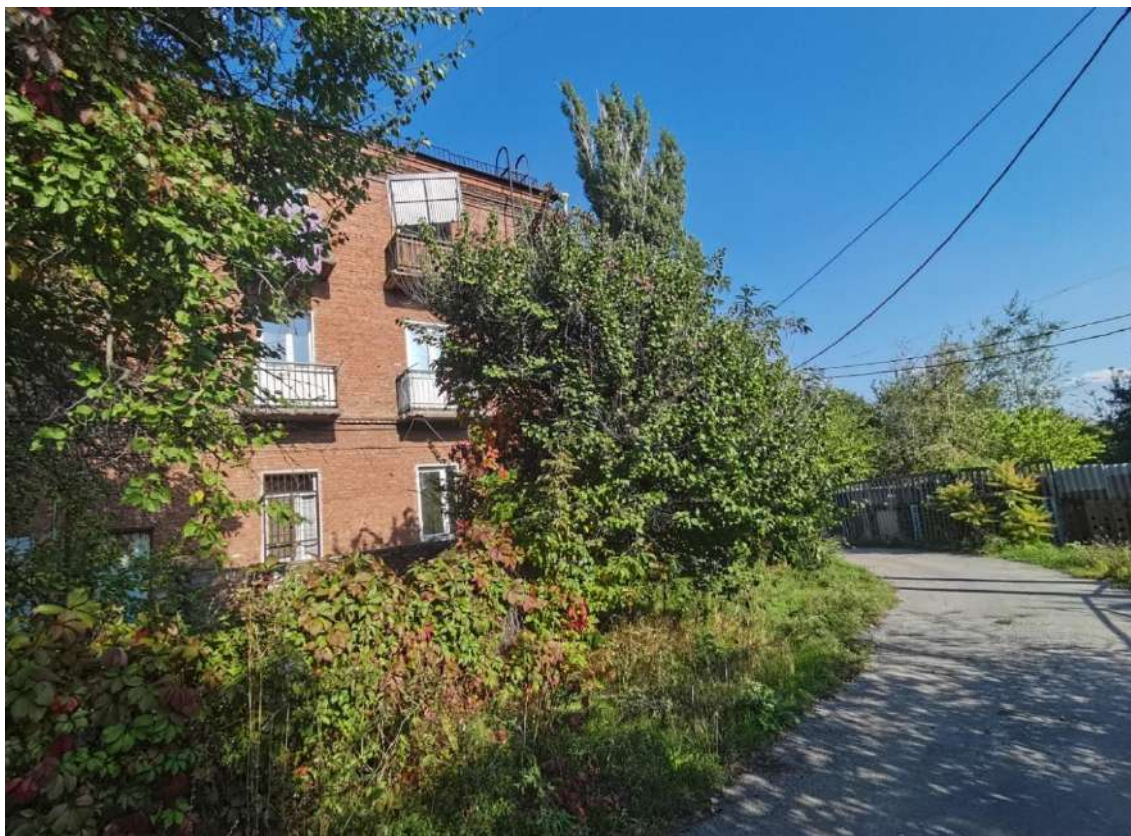
Ф.7. Вид с юго-западной стороны
