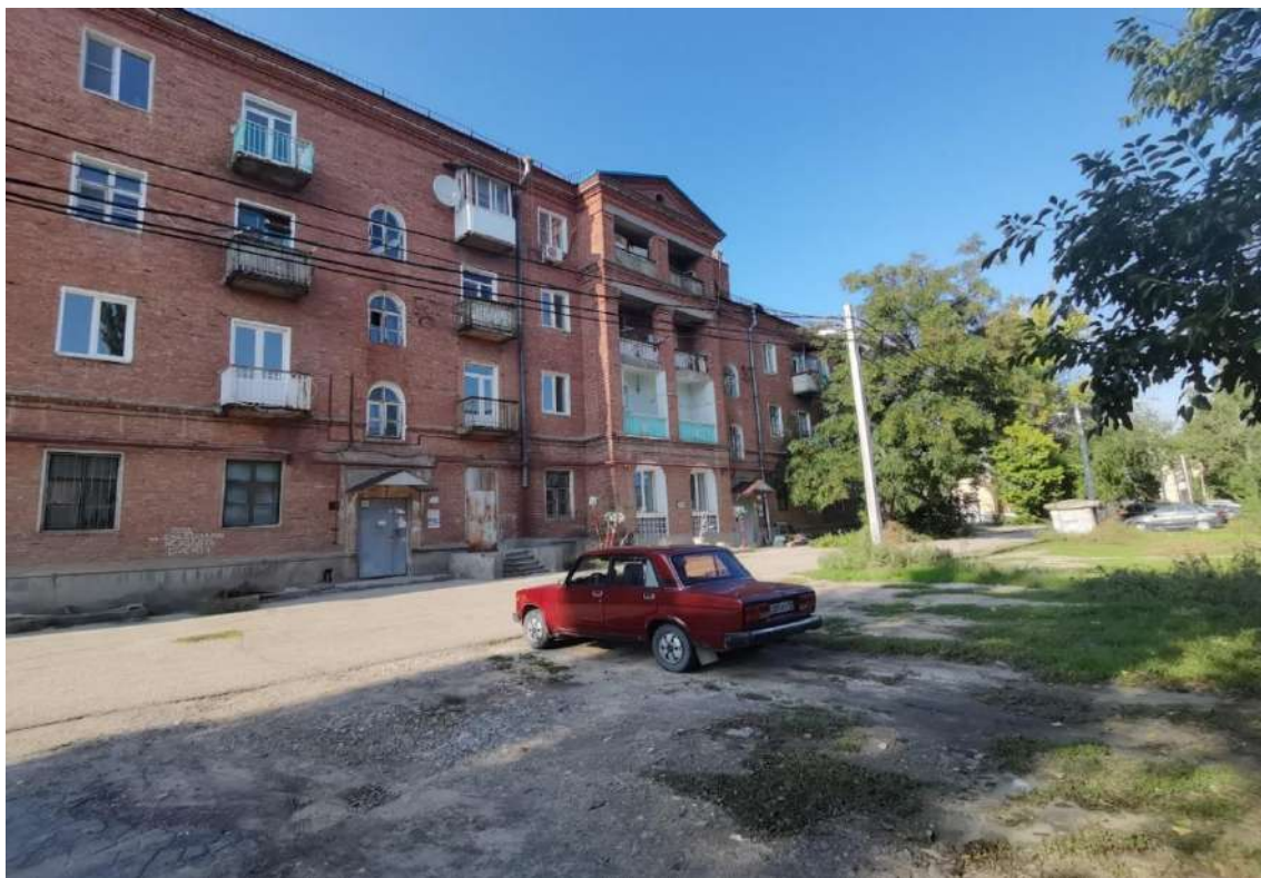
Рис. 5. Вид со стороны двора
