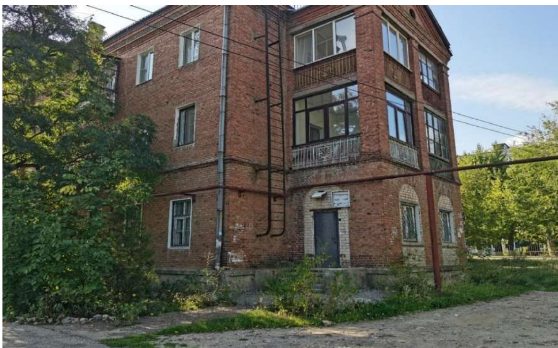
Ф.4. Вид на северо-восточный фасад
