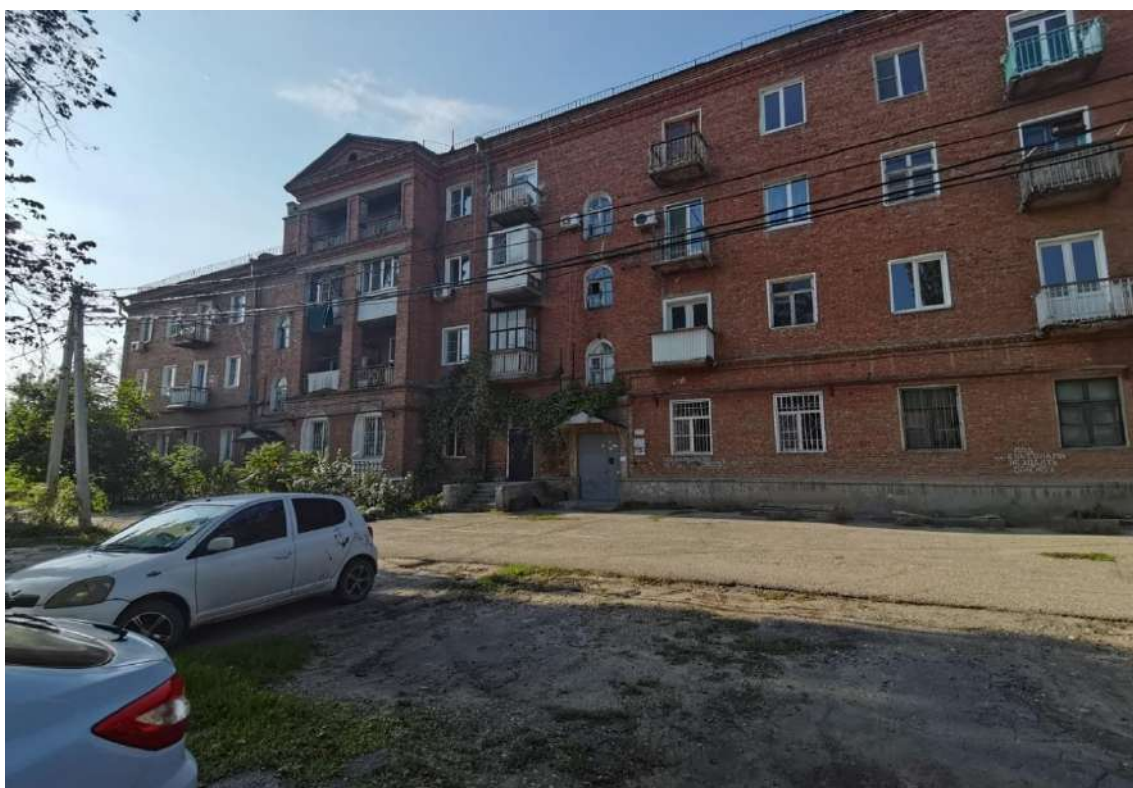
Рис. 6. Вид с южной стороны.
