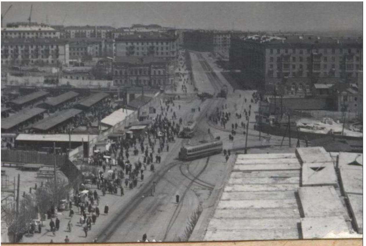
Илл. 2. Строительство жилых домов по ул. Советской. г. Сталинград, 1957-1958 гг. Автор съемки: А. Брянцев.
