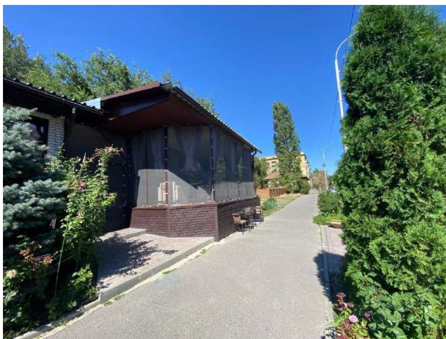
Фото №6. Вид на существующую террасу №2 ресторана «Сапери» в направлении с юга на север.
