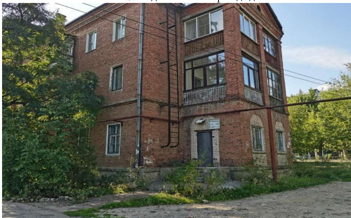
Ф.4. Вид на северо-восточный фасад
