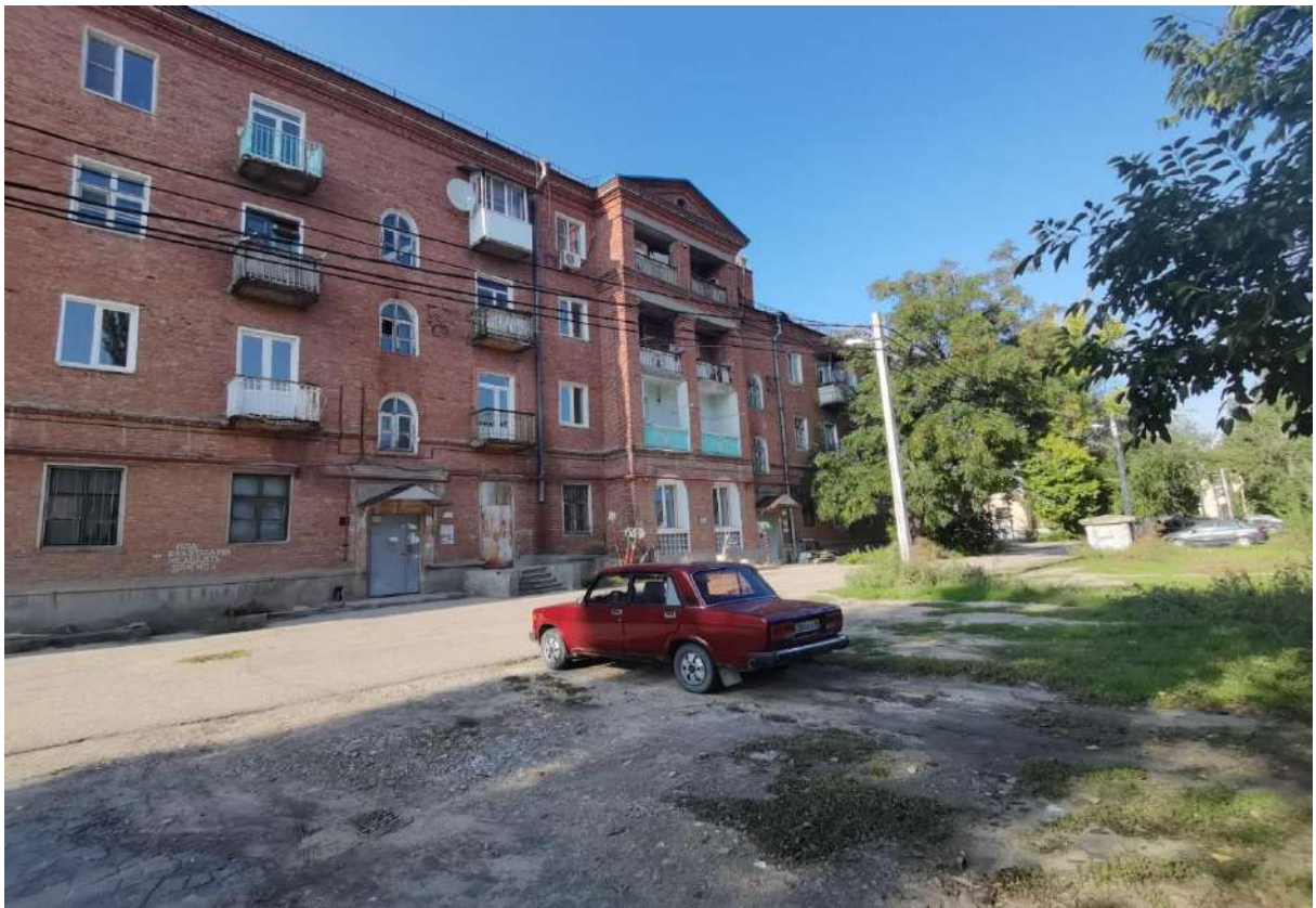
Рис. 5. Вид со стороны двора
