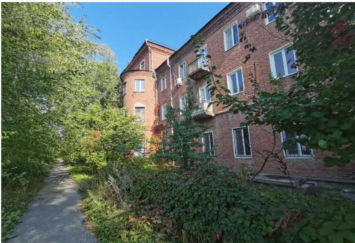
Ф.3. Вид на главный фасад здания
