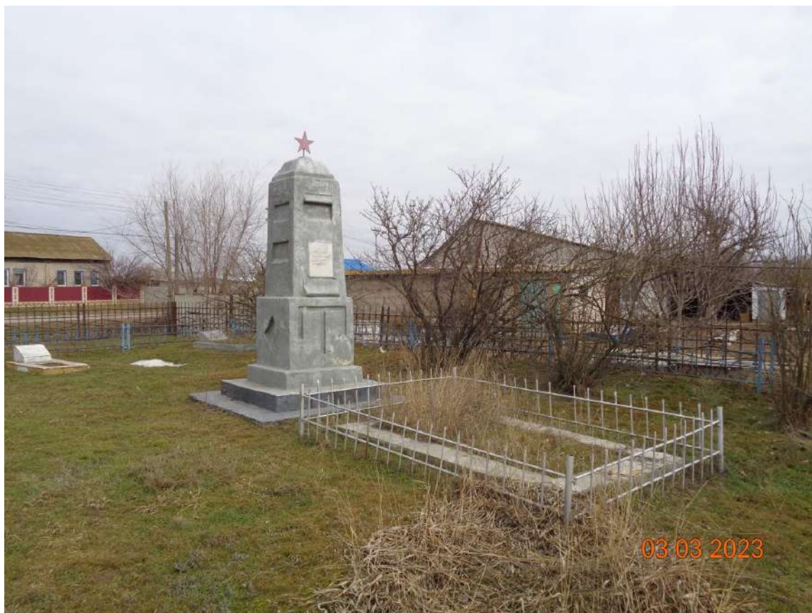
Общий вид Объекта с юго-восточной стороны. (март 2023 года)
