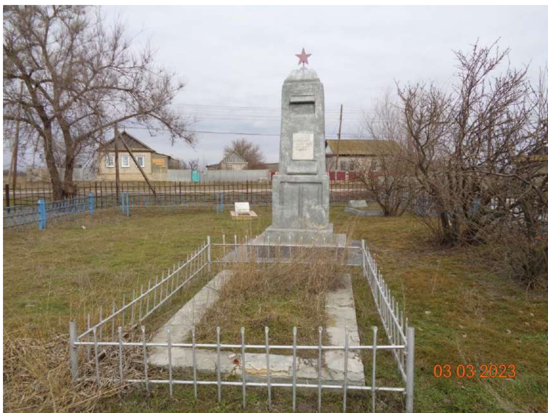
Общий вид Объекта с северо-востока.
