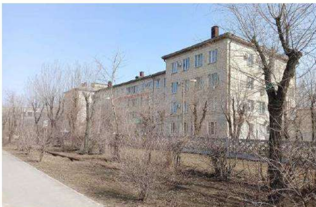
Фото 50. Вид на территорию объекта культурного наследия (ул. Коммунистическая) Дата съемки: март 2023 г.
