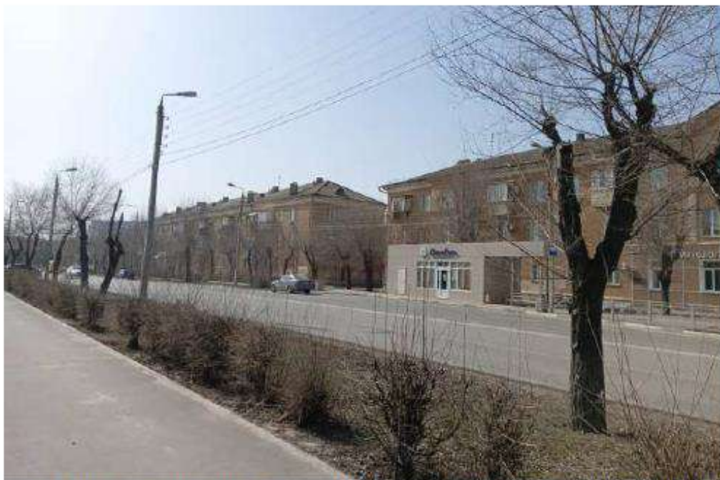
Фото 49. Вид на территорию объекта культурного наследия (ул. Коммунистическая) Дата съемки: март 2023 г.
