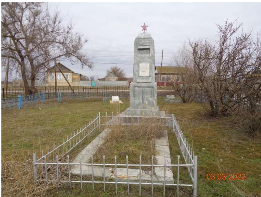
Общий вид Объекта с северо-востока.
