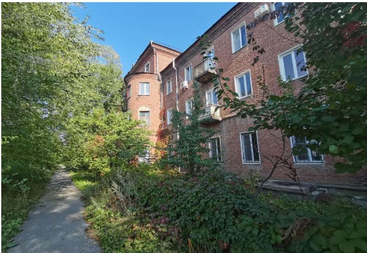
Ф.3. Вид на главный фасад здания
