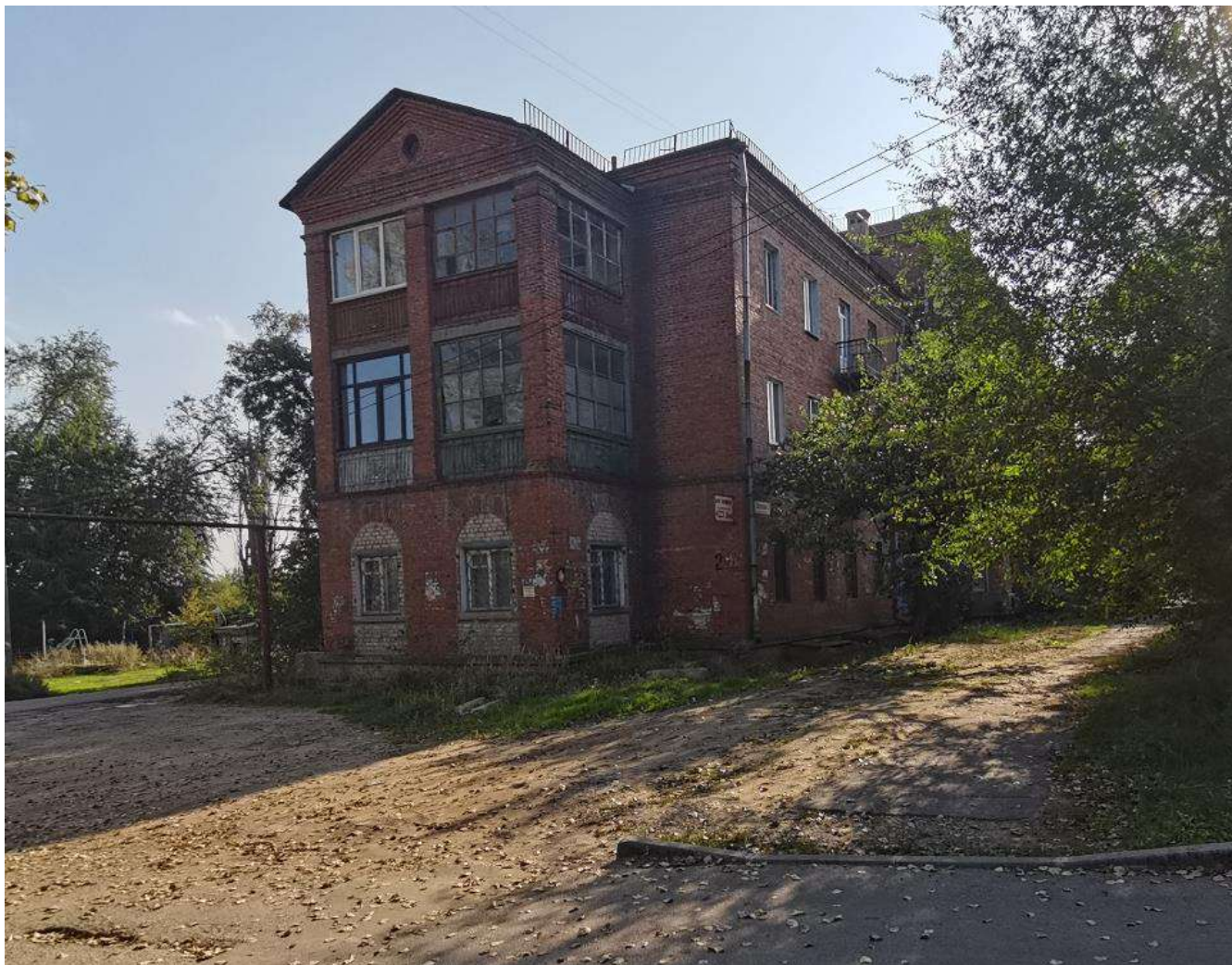
Рис. 1. Вид на здание с юго-западной стороны
