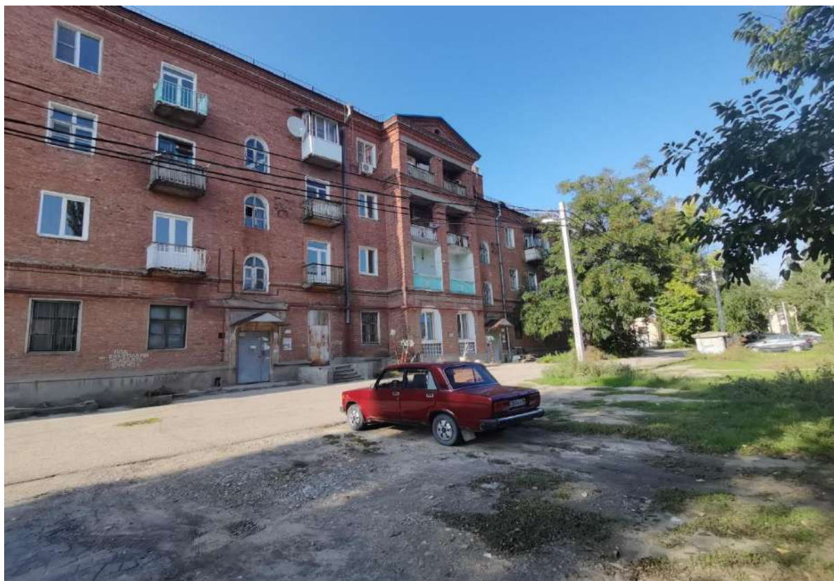
Рис. 5. Вид со стороны двора
