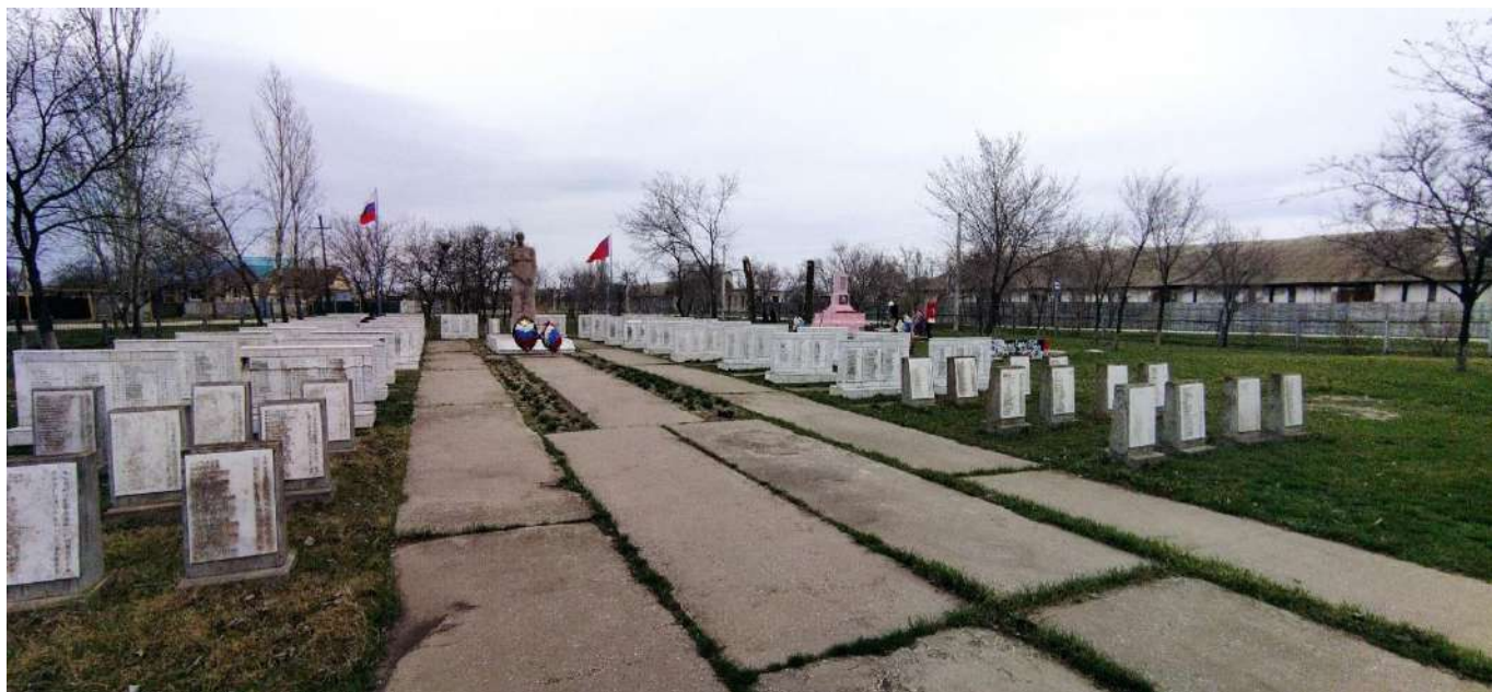
Фото №15. Бетонное мощение плитами. Скульптура «Скорбящая мать» 14.04.2023г.
