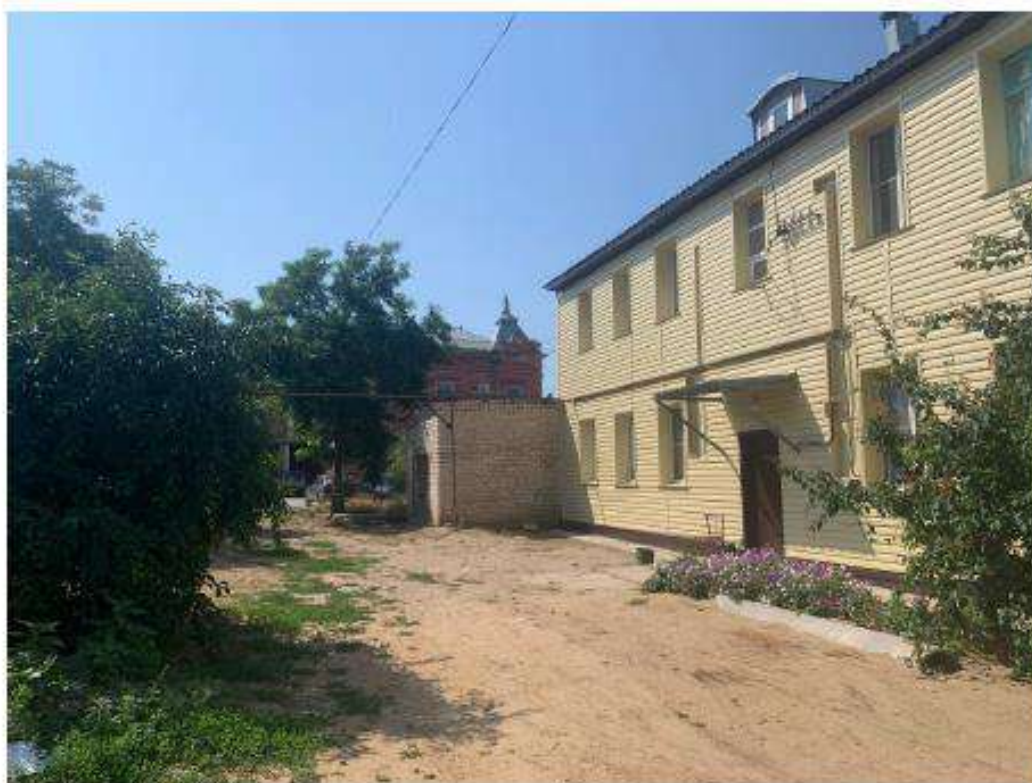
Ф.8. Вид на территорию элемента объекта культурного наследия "Административное здание (дом купца Конякина, 1912г.), ул. Ленина, 233
