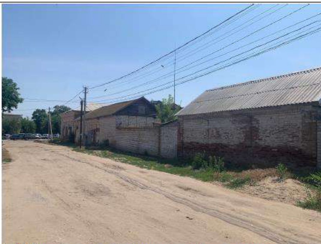
Ф.19. Вид на территорию "Хозяйственная постройка административного здания (дом купца Конякина, нач. XX в.), ул. Ленина, 188", пер. Красноармейский, 1А
