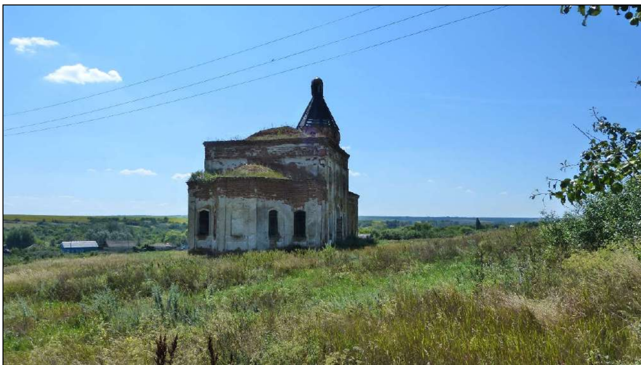
Вид Объекта в юго-западном направлении. Автор фото Котельников В.В. 21.07.2023 г.
