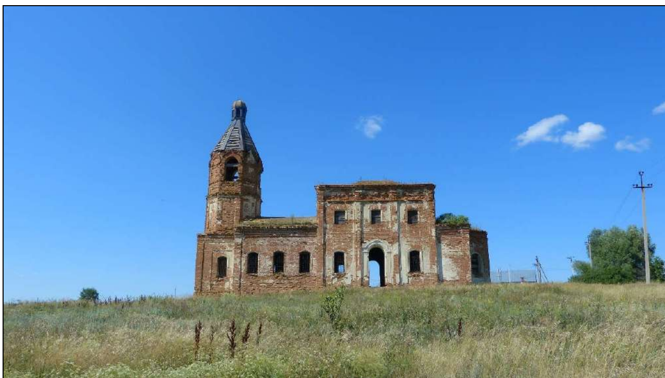
Вид Объекта в северном направлении. Автор фото Котельников В.В. 21.05.2023 г.
