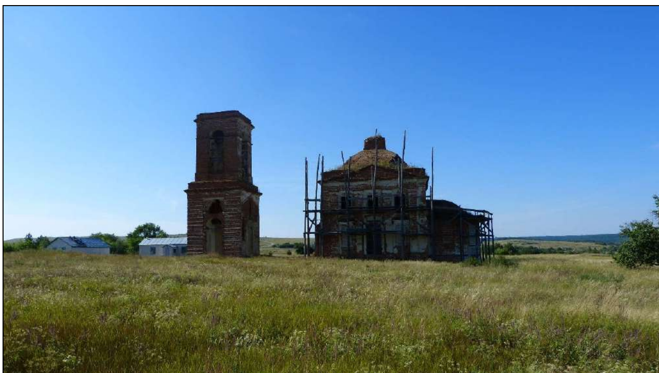
Общий вид Объекта в северо-западном направлении. Автор фото Котельников В.В. 22.07.2023 г.
