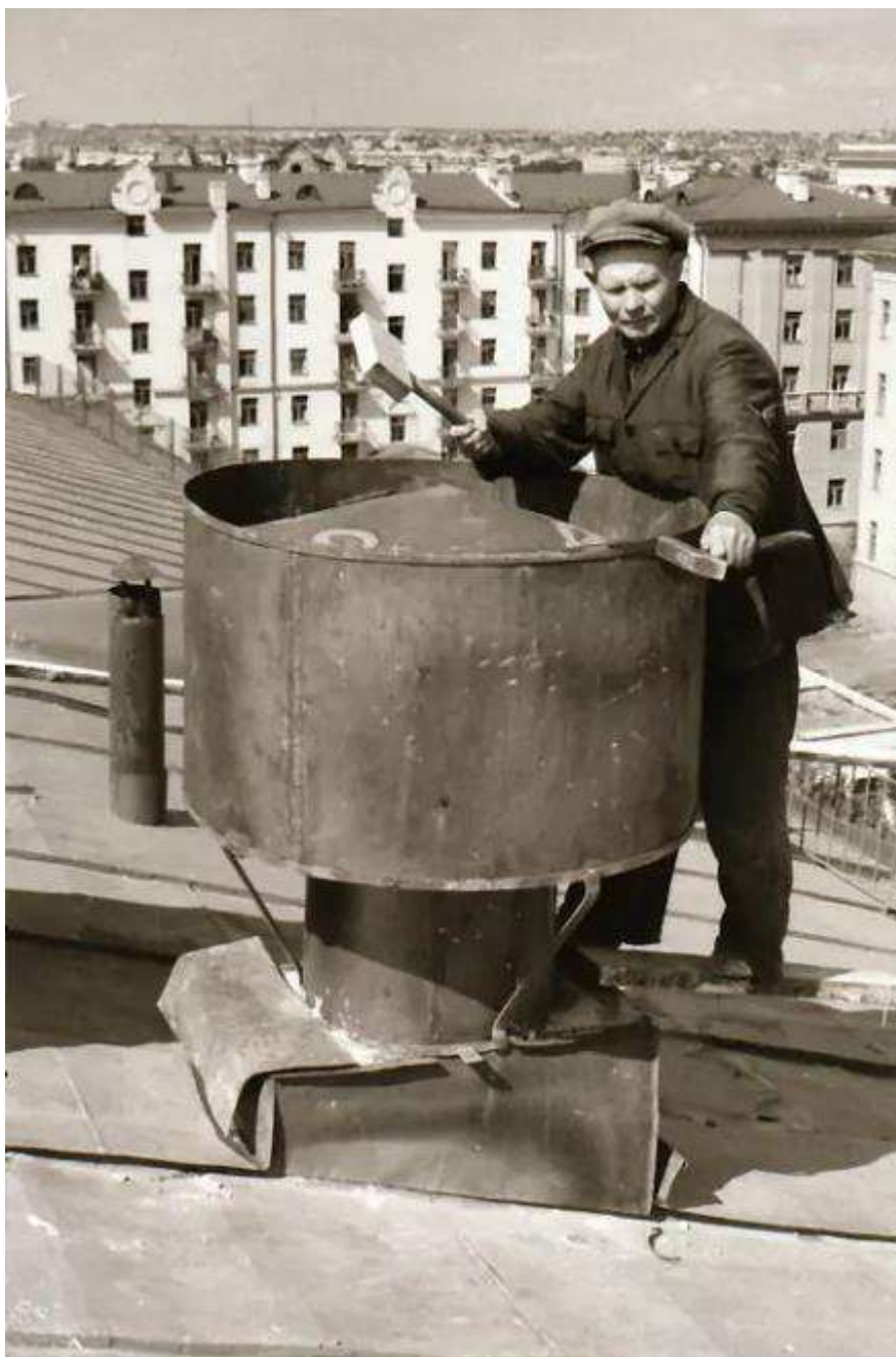
Илл. 19. Кровельщик на крыше дома. Позади него – дворовой фасад уже перестроенного 6-ти этажного дома на месте Дворца Пионеров. 1957 г.
