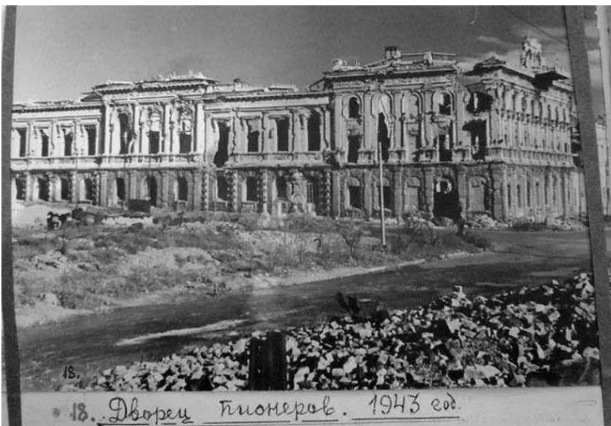
Илл. 16. Разрушенный Дворец Пионеров. 1943 г.
