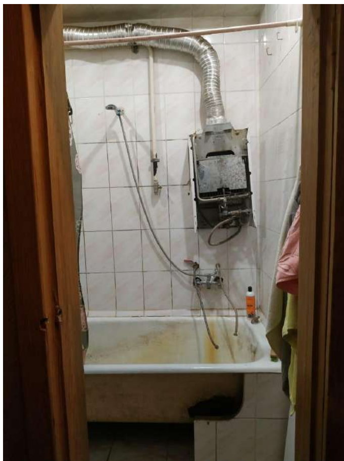
Фото №17. Квартира №76, помещение 8.
