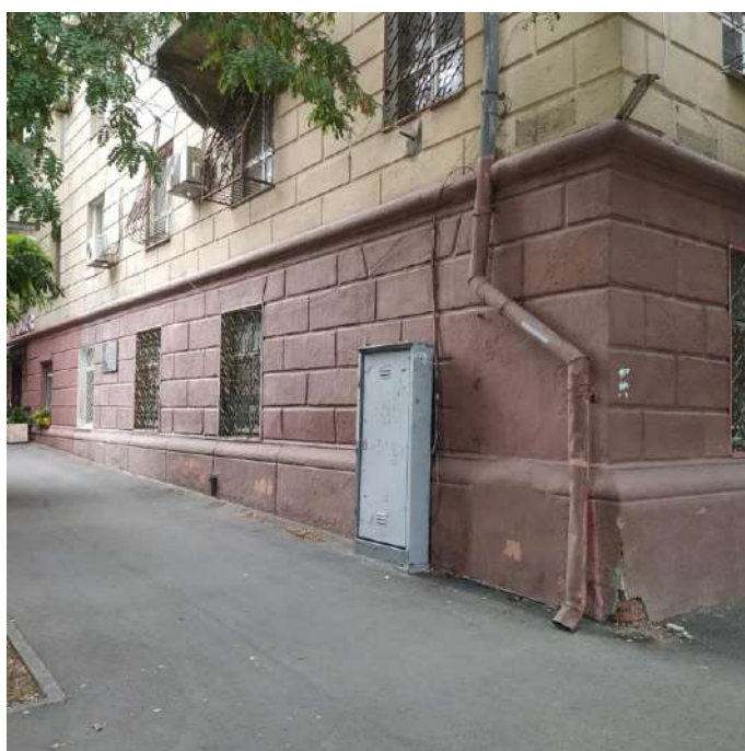
Фото №2. Угол дома на пересечении ул. Ленина и ул. Маршала Чуйкова.
