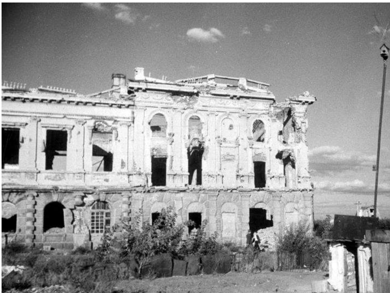
Илл. 11. Здание после окончания Сталинградской битвы. Вид со стороны ул. Ленина.
