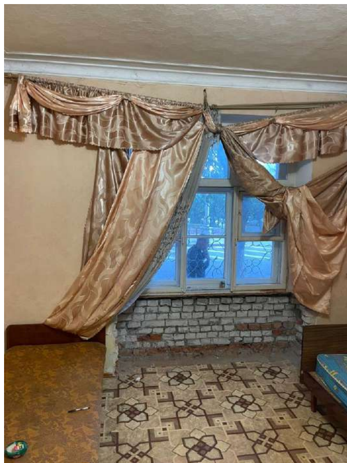
Фото №14. Квартира №76, помещение 2.
