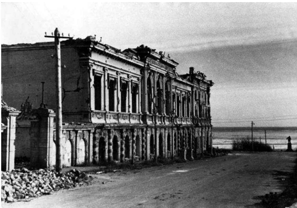
Илл. 12. Здание после окончания Сталинградской битвы. Вид со стороны ул. Ленина.
