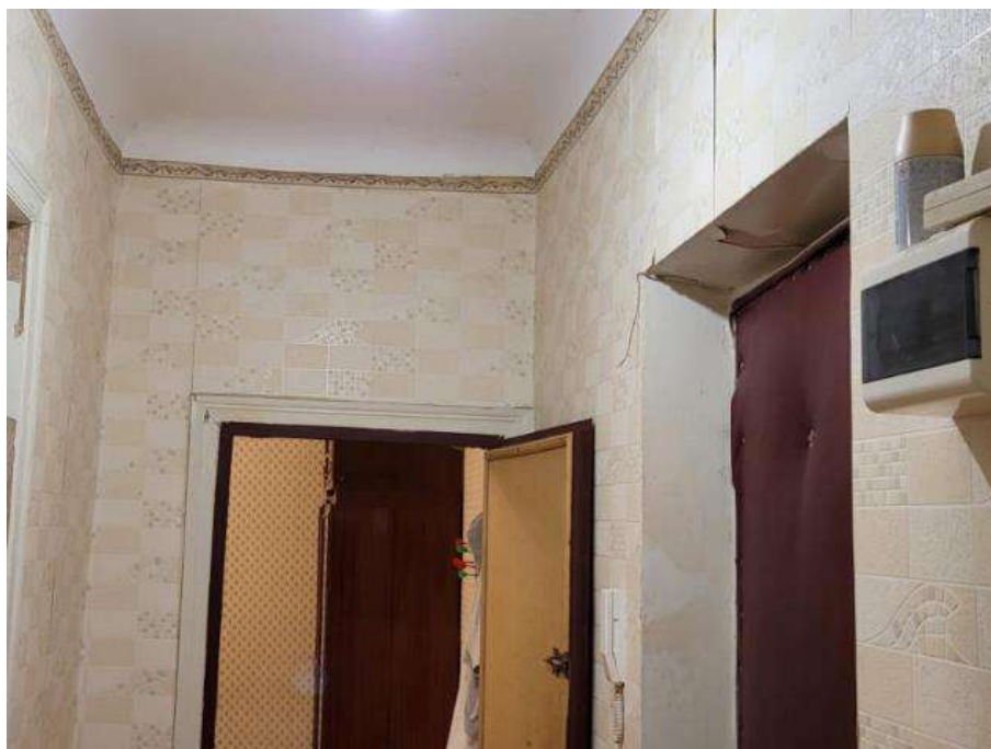
Фото №19. Квартира №75, помещение 1.
