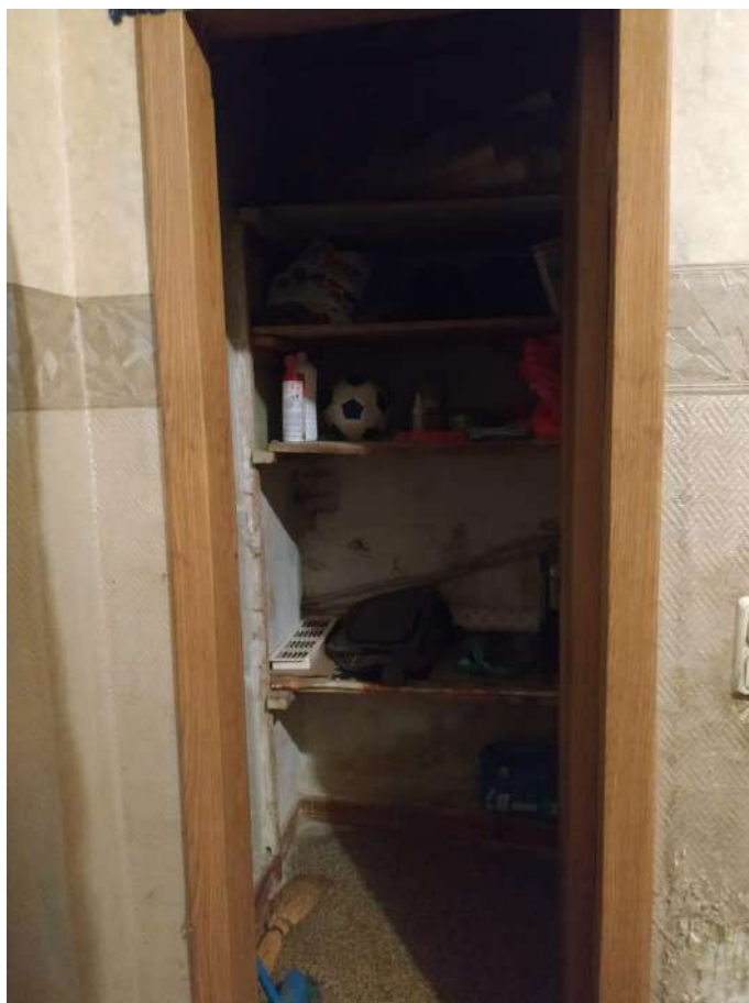
Фото №15. Квартира №76, помещение 6.
