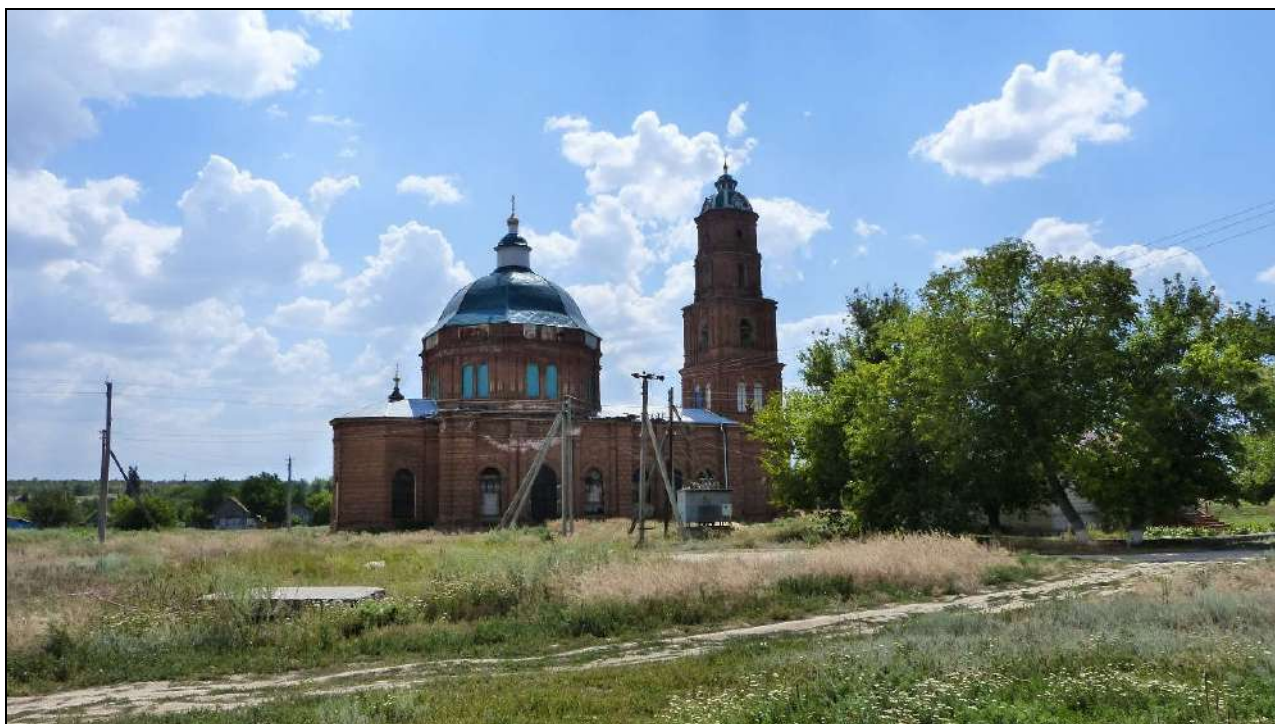
Вид Объекта в юго-западном направлении. Автор фото Котельников В.В. 23.07.2023 г.
