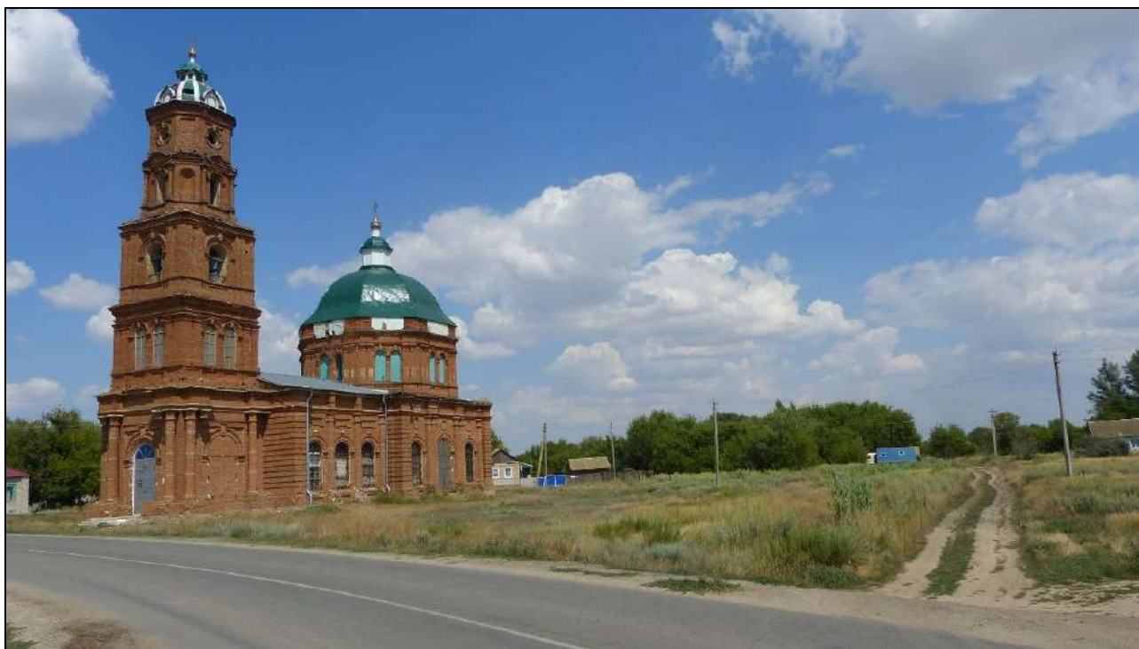
Вид Объекта в северо-восточном направлении. Автор фото Котельников В.В. 23.07.2023 г.
