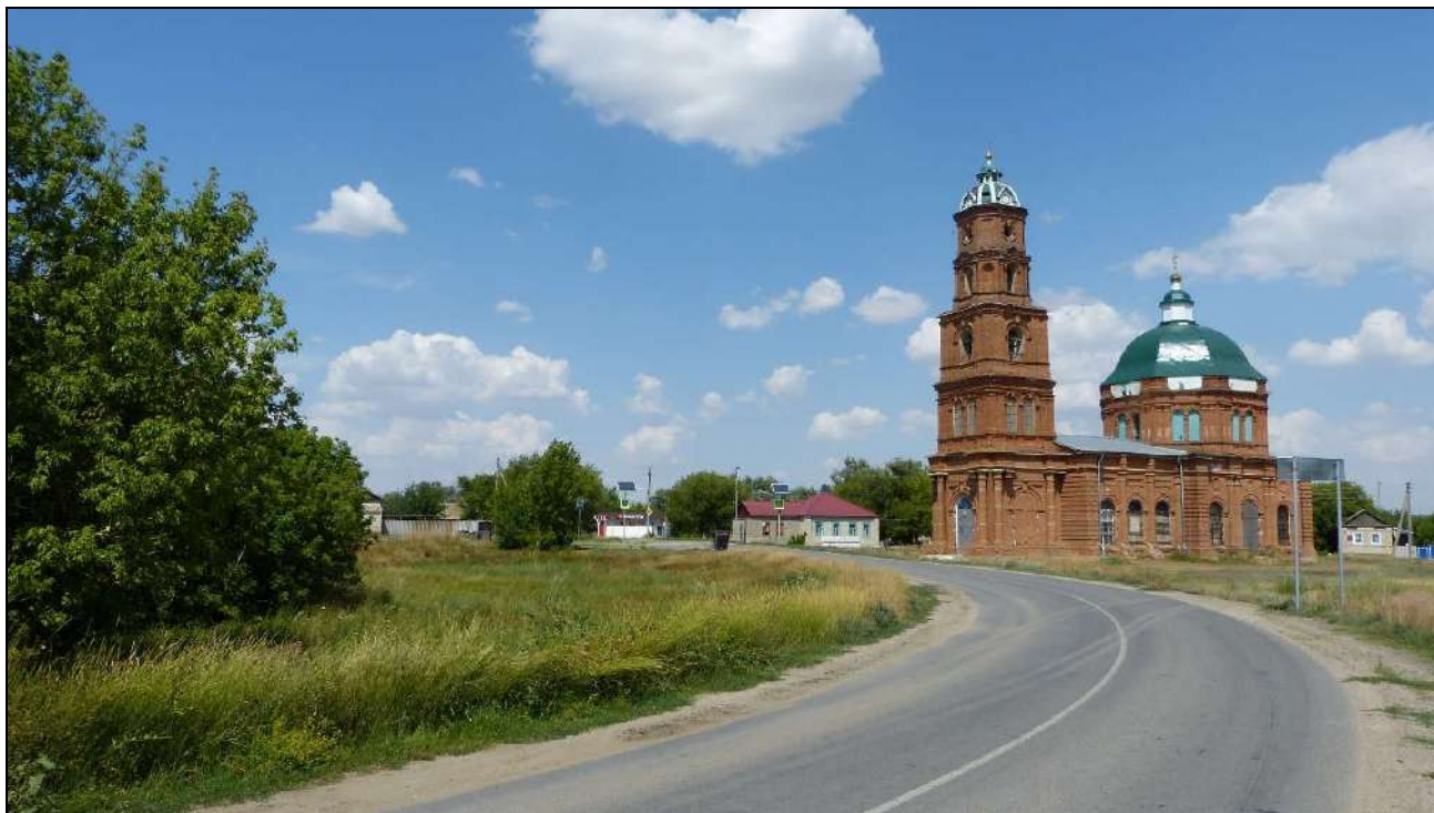
Общий вид Объекта в северо-восточном направлении. Автор фото Котельников В.В. 23.07.2023 г.
