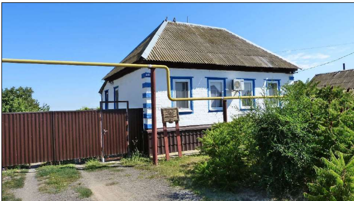
Общий вид Объекта с ул. Советская в северо-восточном направлении. Автор Котельников В.В. 20.08.2023 г.
