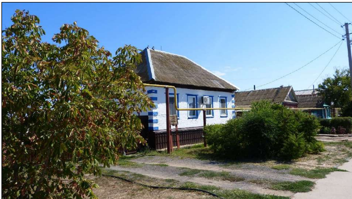
Вид Объекта с ул. Советская в северо-восточном направлении. Автор Котельников В.В. 20.08.2023 г.
