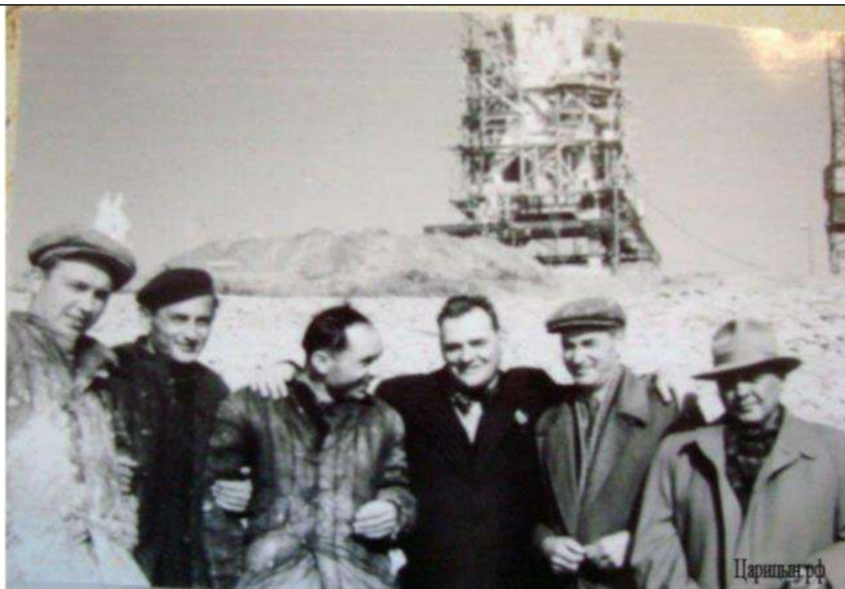
Дата съемки ориентировочно 1954 год, Вучетич на фоне строящегося памятника. Автор неизвестен.
