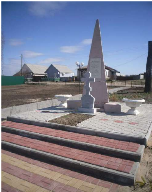
Вид на лицевой (западный) фасад Объекта. Современное фото. Автор фото Сена С.Л.
