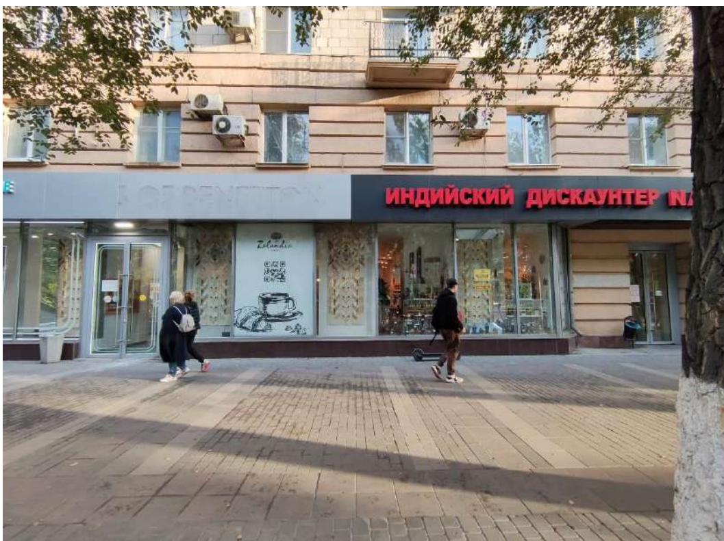
Фото 1. «Комплекс застройки пр. Ленина». Фрагмент фасада в границах занимаемых помещений.
