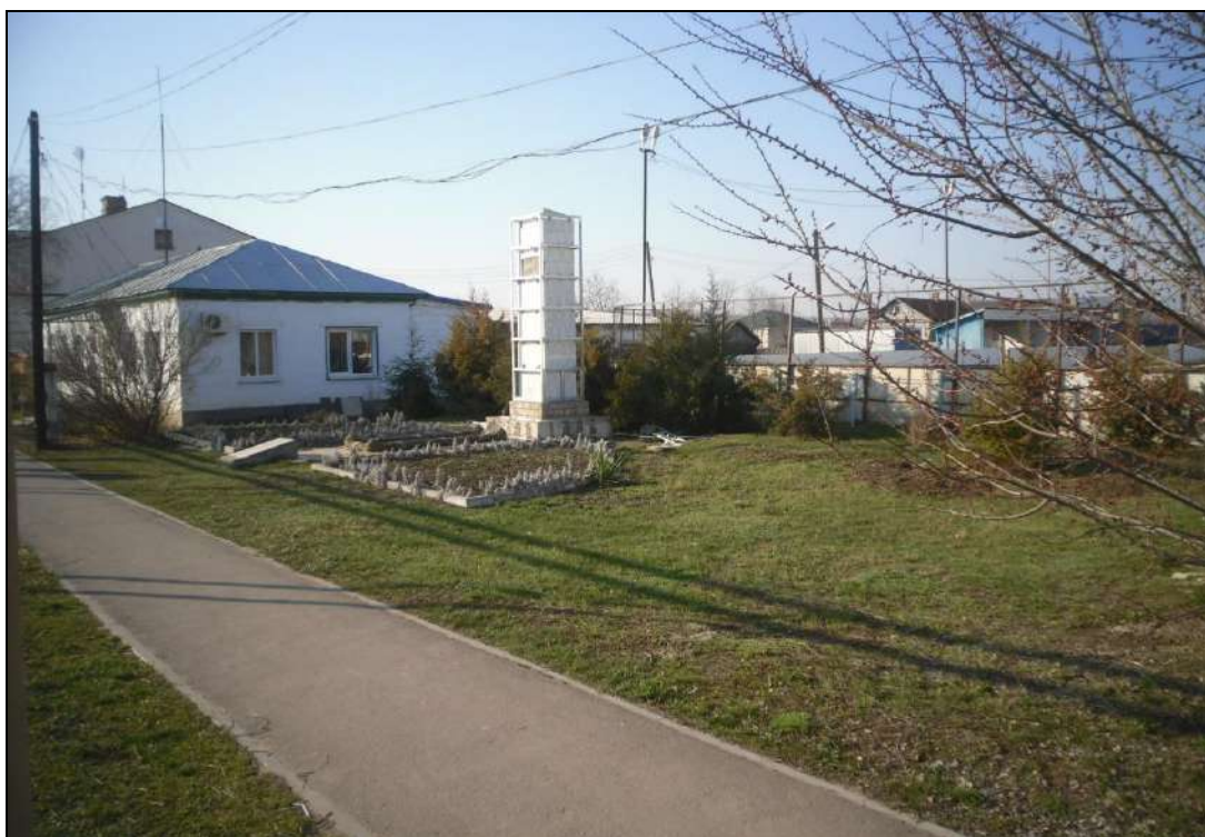
Общий вид Объекта и окружающей его территории. За Объектом – здание Администрации Добринского сельского поселения. Фото 2021 г.
