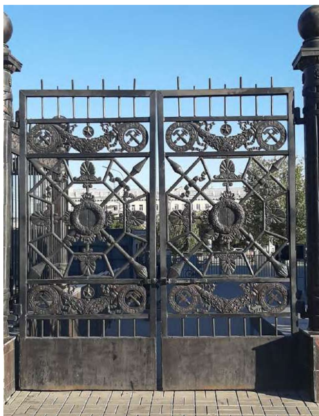
Фото 2. Фрагмент ограждения. Ворота.
