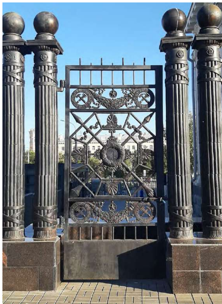
Фото 3. Фрагмент ограждения. Калитка.
