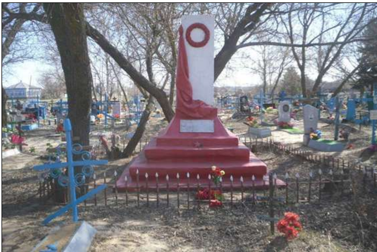
Общий вид Объекта. Главный (западный) декорированный фасад памятника. Современное фото. Автор Сена С.Л.
