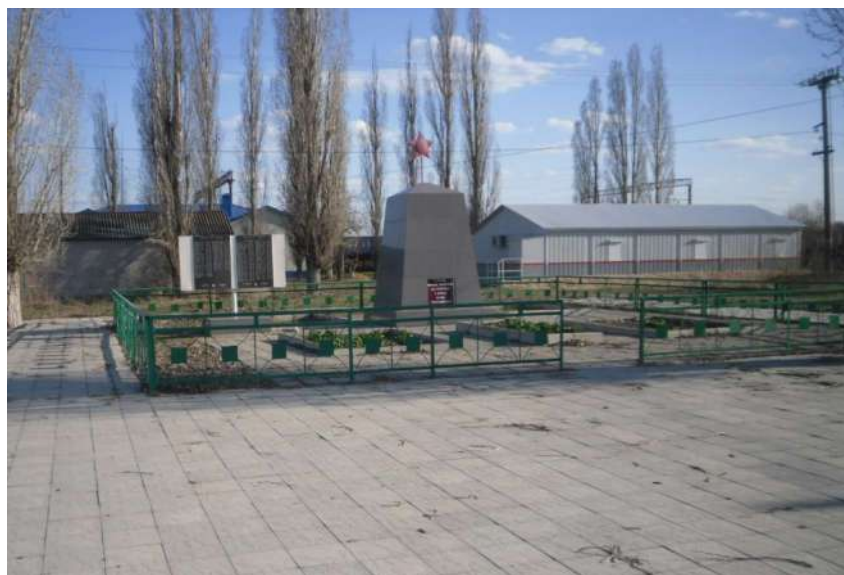
Общий вид Объекта с северо-запада (до проведения реставрационных работ). Фото 2020 г.
