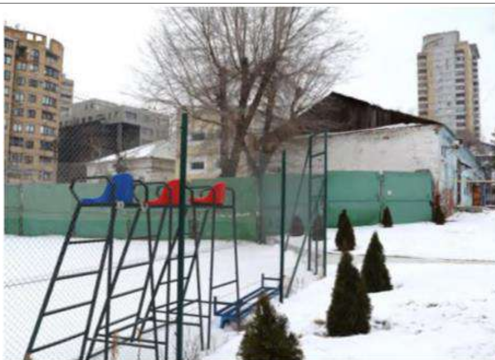
Фото 23. Общий вид на объект с юга.
