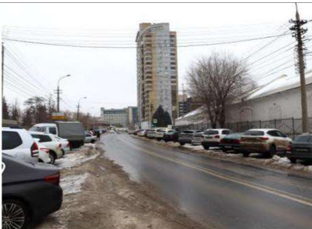
Фото 17. Общий вид на объект с юго-запада.
