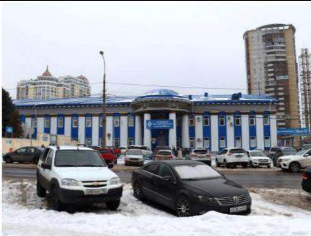
Фото 15. Общий вид на объект с северо-запада.
