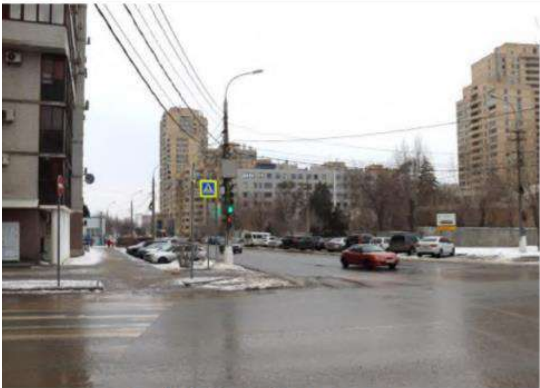
Фото 9. Общий вид на объект с северо-востока.
