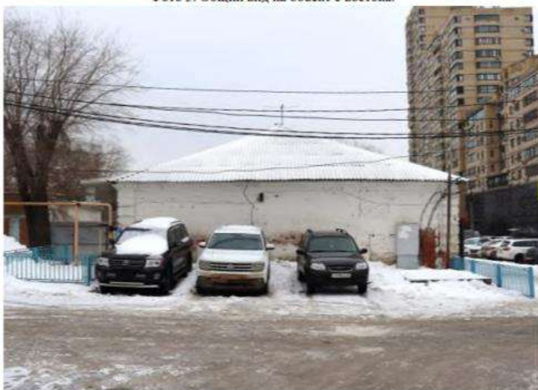
Фото 6. Общий вид на объект с северо-востока.
