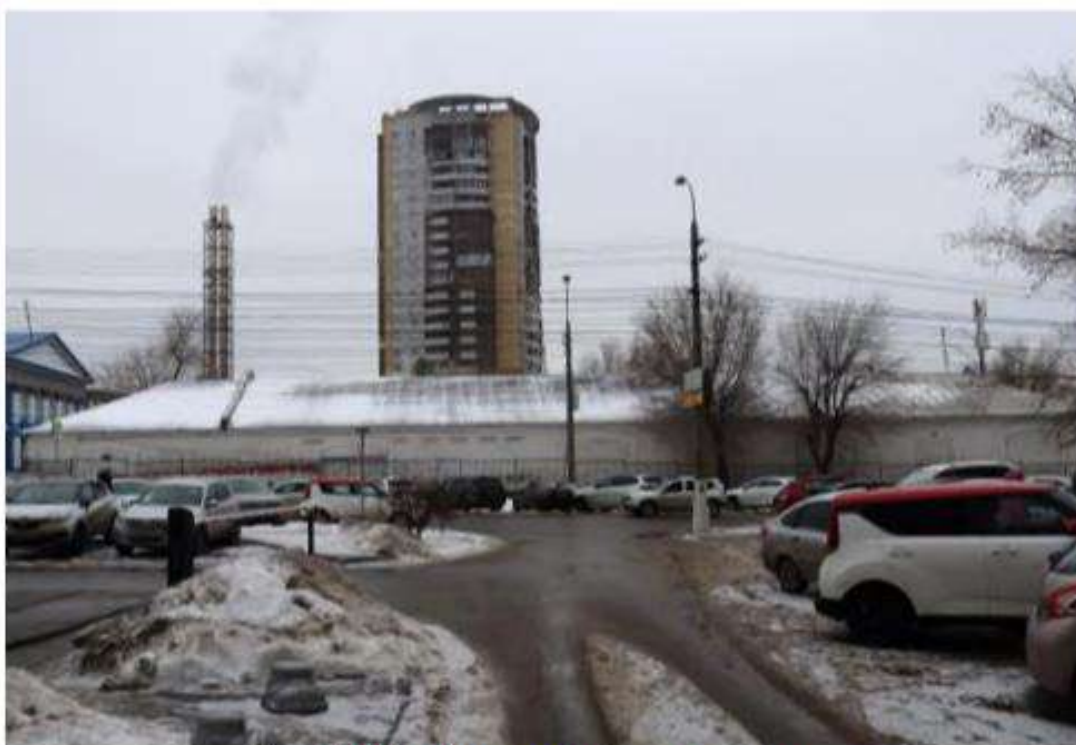
Фото 3. Общий вид на объект с северо-запада.
