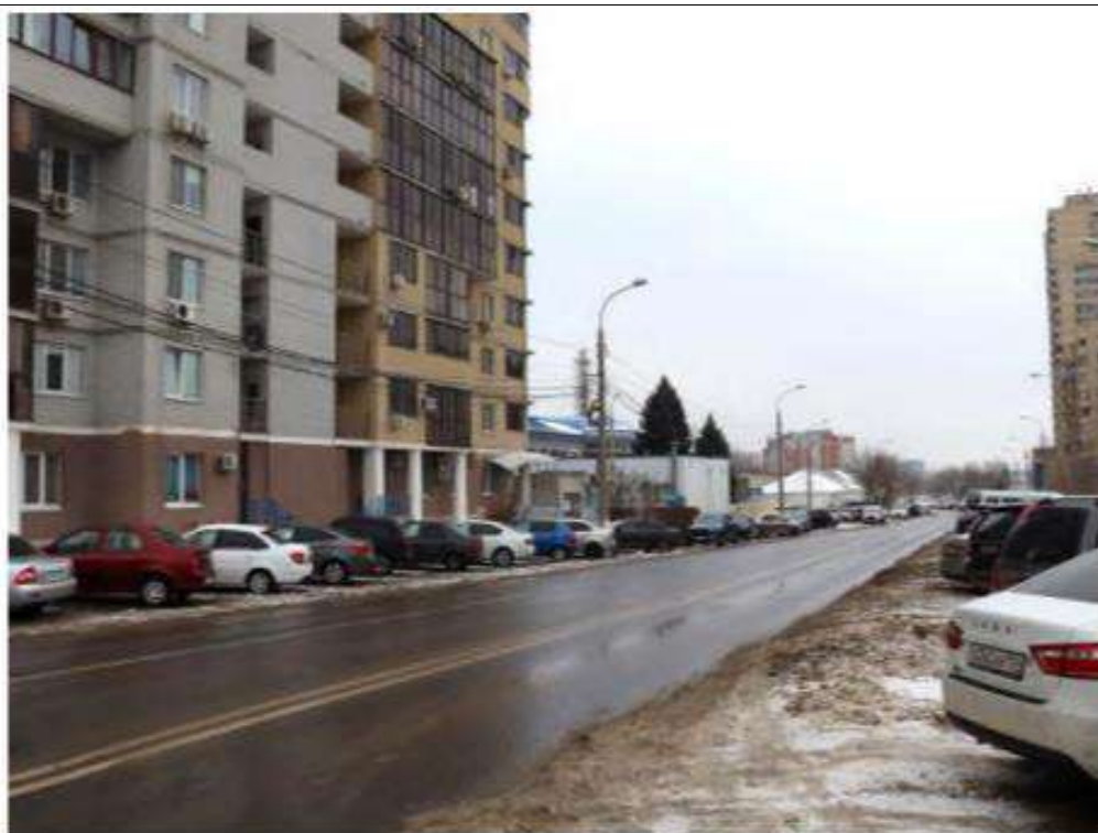
Фото 11. Общий вид на объект с северо-востока.
