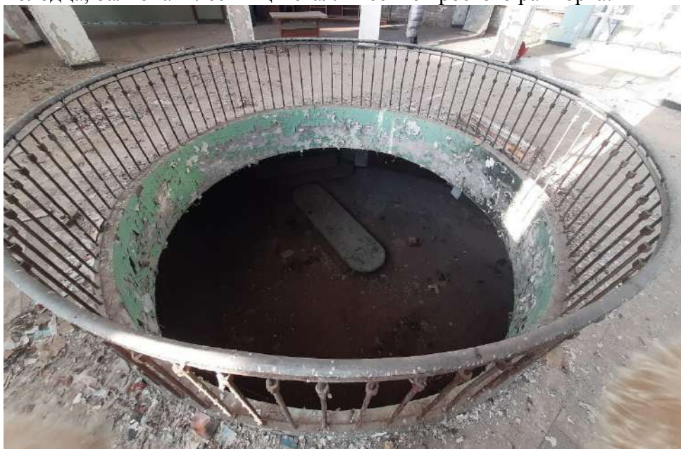
Рис. 51. Выявленный объект культурного наследия «Речной вокзал» Волгоградская обл., г. Волжский, ул. Портовая, 20 Вестибюль. Фрагмент. Световой колодец. Фото Оболенской Н.С. Январь 2024 г.
