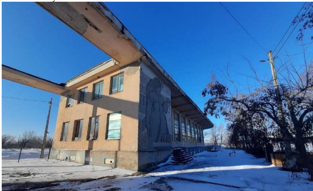
Рис. 41. Выявленный объект культурного наследия «Речной вокзал» Волгоградская обл., г. Волжский, ул. Портовая, 20 Рельеф «Волга» на северном фасаде. Вид с северо-востока. Фото Оболенской Н.С. Январь 2024 г.
