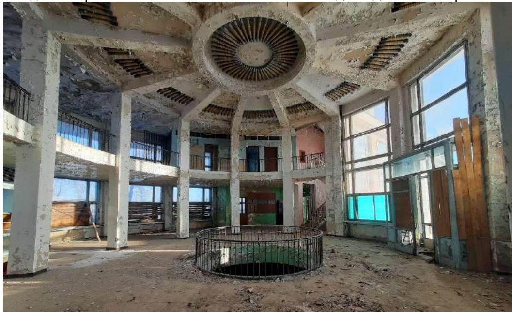
Рис. 47. Выявленный объект культурного наследия «Речной вокзал» Волгоградская обл., г. Волжский, ул. Портовая, 20 Вестибюль. Фрагмент. Первый этаж. Фото Оболенской Н.С. Январь 2024 г.
