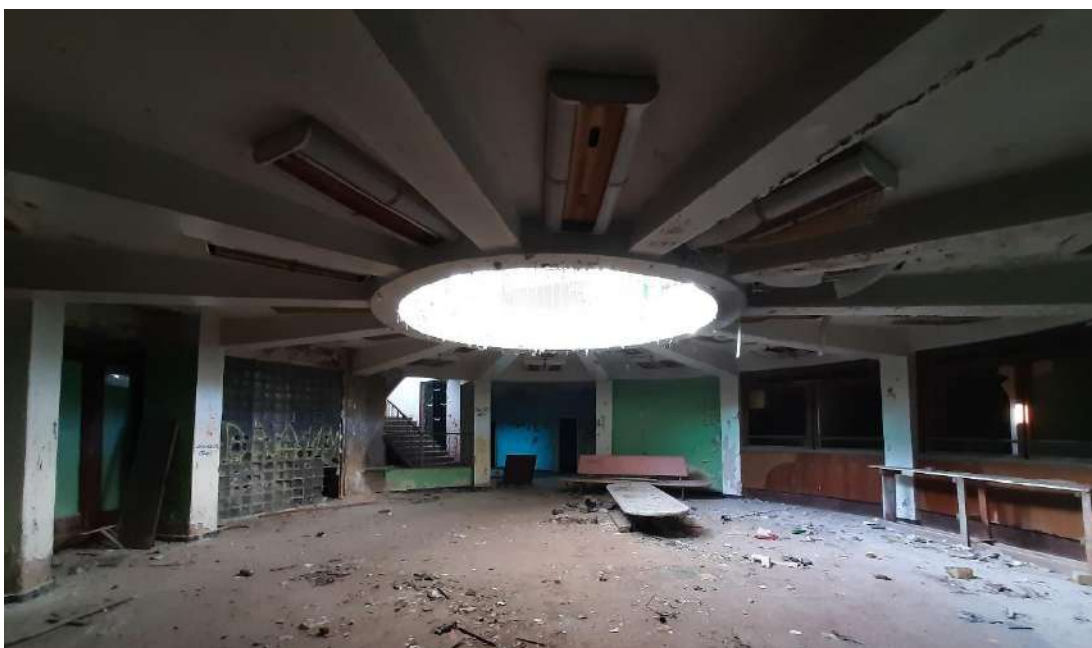
Рис. 52. Выявленный объект культурного наследия «Речной вокзал» Волгоградская обл., г. Волжский, ул. Портовая, 20 Цокольный этаж под вестибюлем. Фрагмент. Фото Оболенской Н.С. Январь 2024 г.
