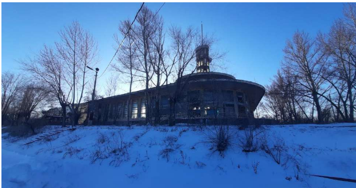
Рис. 39. Выявленный объект культурного наследия «Речной вокзал» Волгоградская обл., г. Волжский, ул. Портовая, 20 Общий вид с севера. Фото Оболенской Н.С. Январь 2024 г.
