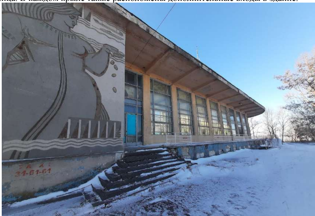
Рис. 43. Выявленный объект культурного наследия «Речной вокзал» Волгоградская обл., г. Волжский, ул. Портовая, 20 Северный фасад. Терраса. Вид с северо-востока. Фото Оболенской Н.С. Январь 2024 г.
