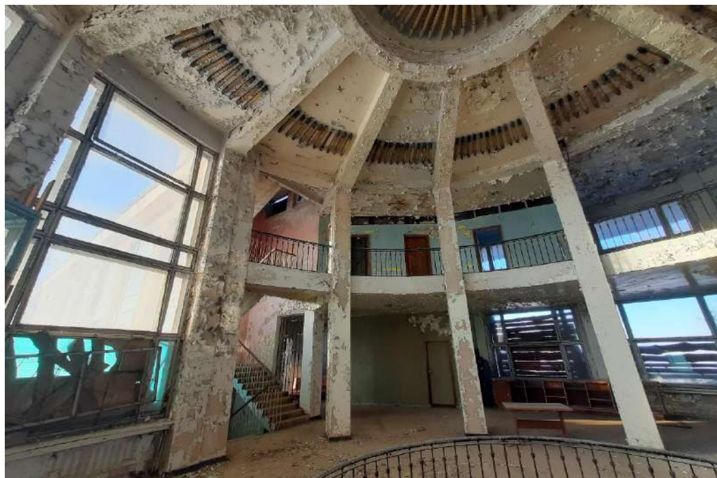
Рис. 48. Выявленный объект культурного наследия «Речной вокзал» Волгоградская обл., г. Волжский, ул. Портовая, 20 Вестибюль. Фрагмент. Первый этаж. Фото Оболенской Н.С. Январь 2024 г.
