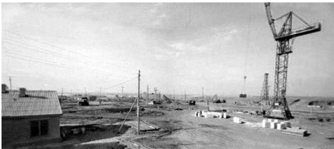
Рис. 21. Участок, на котором планировали строительство порта «Волжск». Архивное фото Сивакова Е.Ф., 1958 г. Фото с сайта https://dzen.ru/a/ZRbJQMctXxPFU9eL
