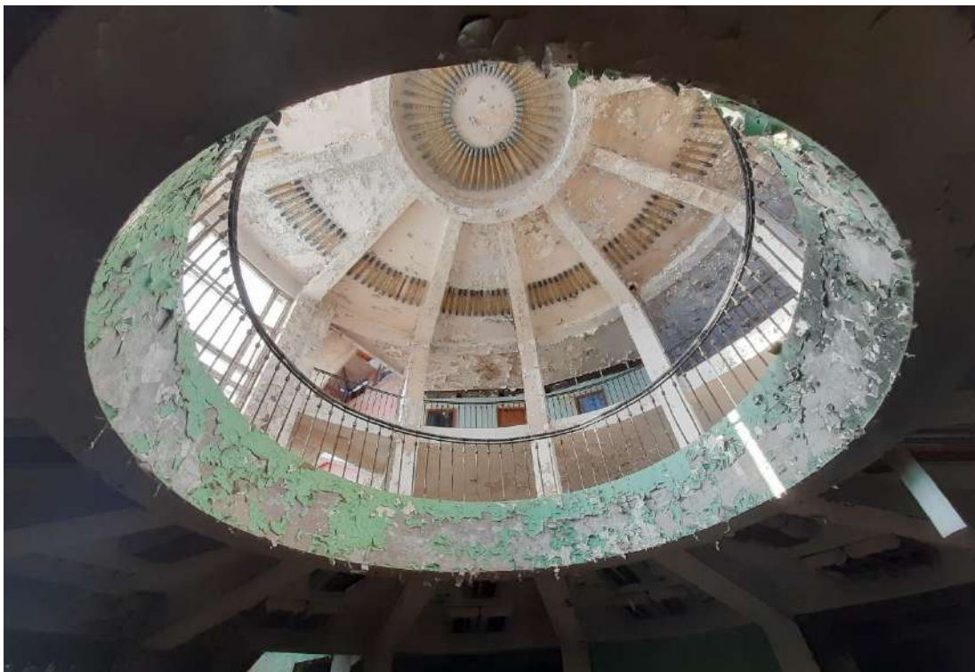
Рис. 53. Выявленный объект культурного наследия «Речной вокзал» Волгоградская обл., г. Волжский, ул. Портовая, 20 Световой колодец. Вид с цокольного этажа. Фото Оболенской Н.С. Январь 2024 г.
