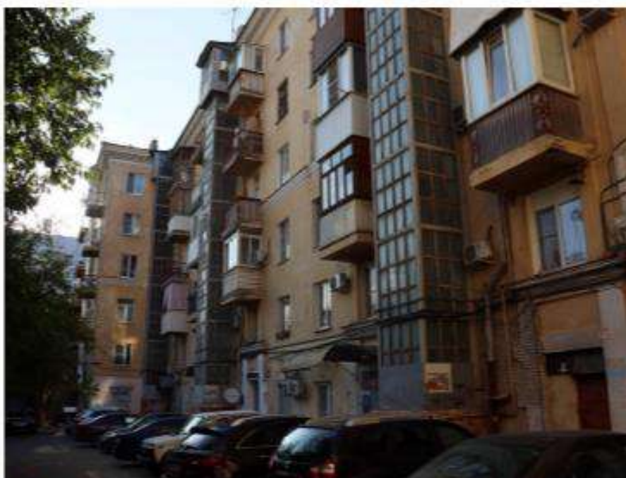
Фото 77. Вид на элемент объекта культурного наследия «Комплекс застройки ул. Мира» - жилой дом по ул. Мира, 18, со стороны двора. Дата съемки: октябрь 2023 г.
