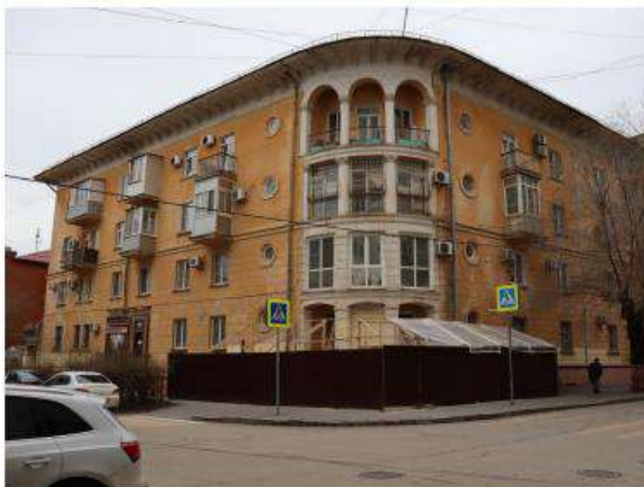
Фото 93. Вид на элемент объекта культурного наследия «Комплекс застройки ул. Мира» - жилой дом по ул. Мира, 10, со стороны ул. Володарского. Дата съемки: ноябрь 2023 г.
