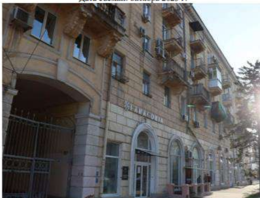
Фото 76. Вид на элемент объекта культурного наследия «Комплекс застройки ул. Мира» - жилой дом по ул. Мира, 18, со стороны ул. Мира. Дата съемки: октябрь 2023 г.
