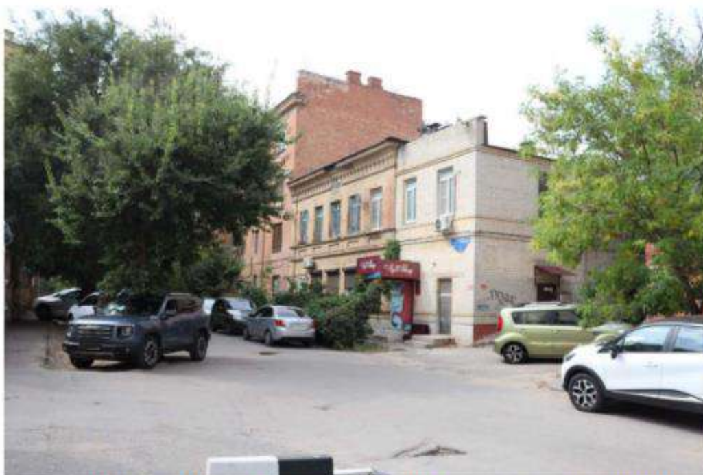
Фото 16. Вид на ОКН «Жилые дома (3) (Пункт вневедомственной охраны (ПЦН))» по ул. Пролеткультская. Дата съемки: июль 2023 г.
