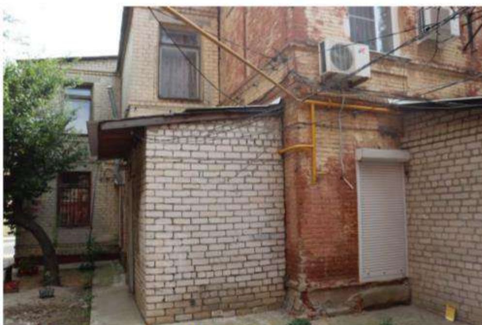
Фото 22. Вид на пристройки к ОКН «Жилые дома (3) (Пункт вневедомственной охраны (ПЦН))». Дата съемки: июль 2023 г.
