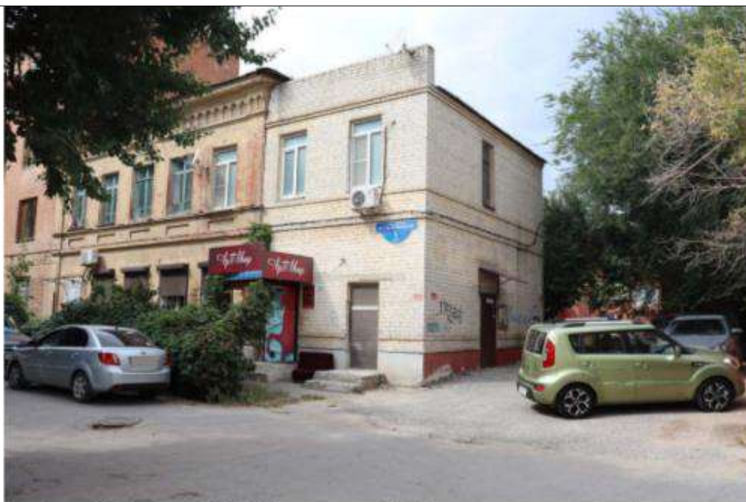
Фото 17. Вид на ОКН «Жилые дома (3) (Пункт вневедомственной охраны (ПЦН))» по ул. Пролеткультская. Дата съемки: июль 2023 г.
