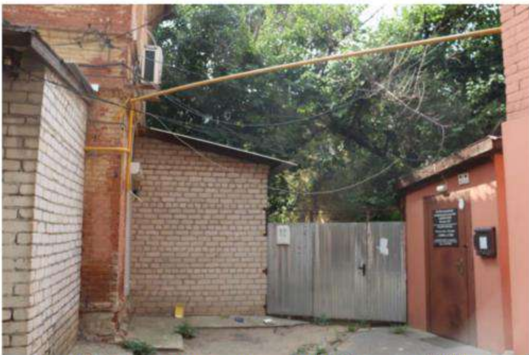
Фото 20. Вид на дворовое пространство ОКН «Жилые дома (3) (Пункт вневедомственной охраны (ПЦН)». Дата съемки: июль 2023 г.
