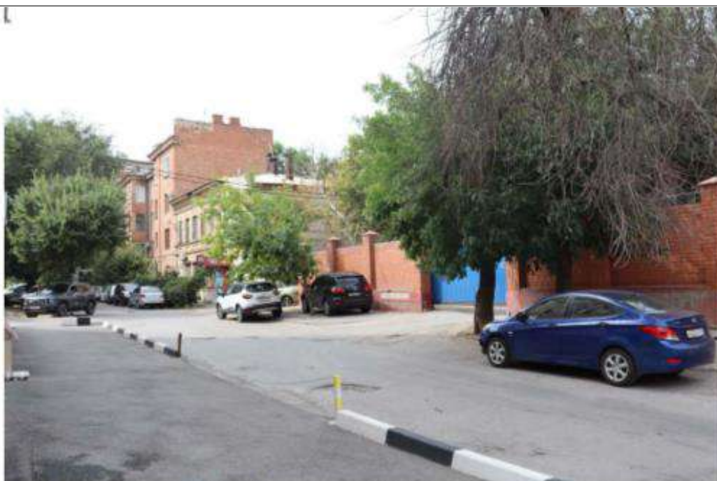
Фото 15. Вид на ОКН «Жилые дома (3) (Пункт вневедомственной охраны (ПЦН))» по ул. Пролеткультская. Дата съемки: июль 2023 г.
