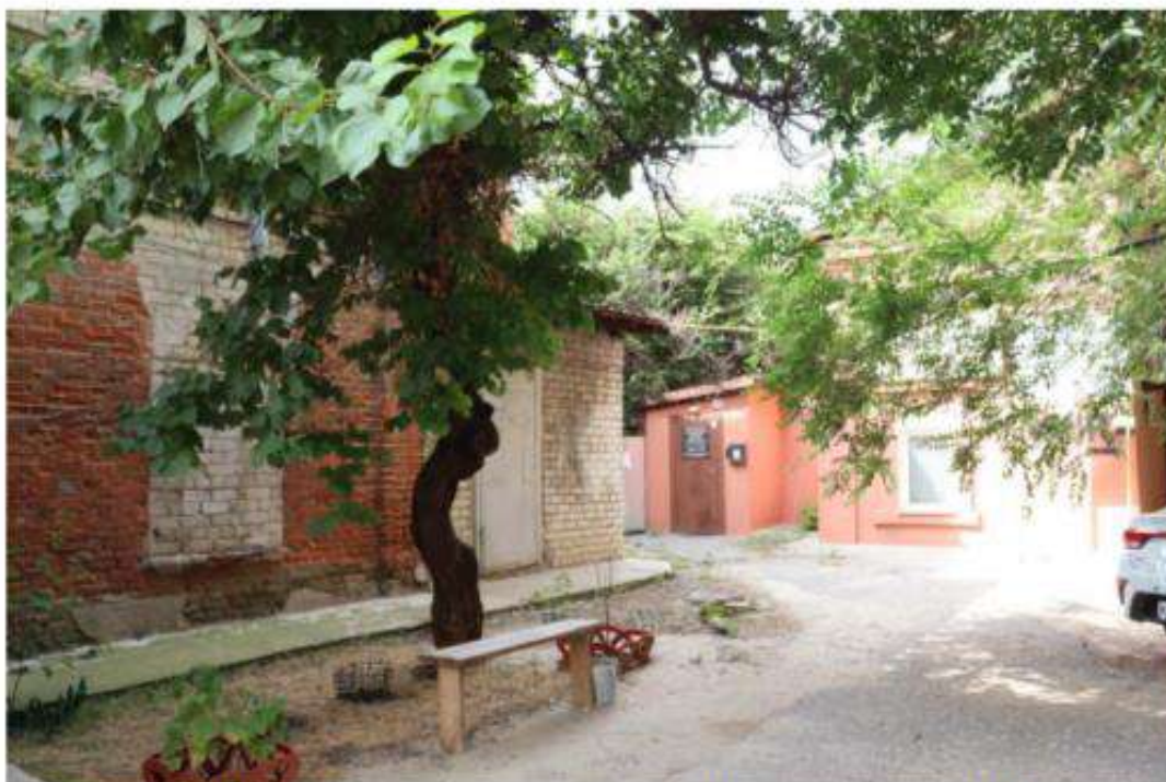
Фото 18. Вид на дворовое пространство ОКН «Жилые дома (3) (Пункт вневедомственной охраны (ПЦН))». Дата съемки: июль 2023 г.
