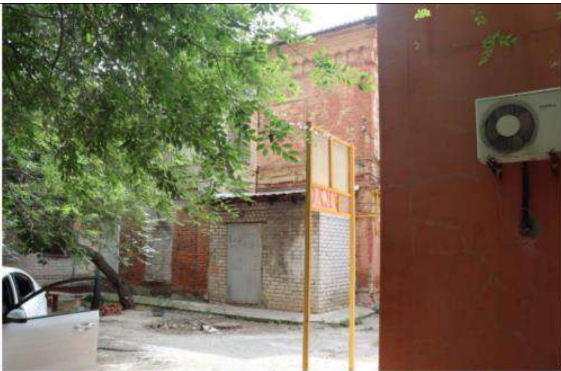
Фото 19. Вид на дворовое пространство ОКН «Жилые дома (3) (Пункт вневедомственной охраны (ПЦН)». Дата съемки: июль 2023 г.
