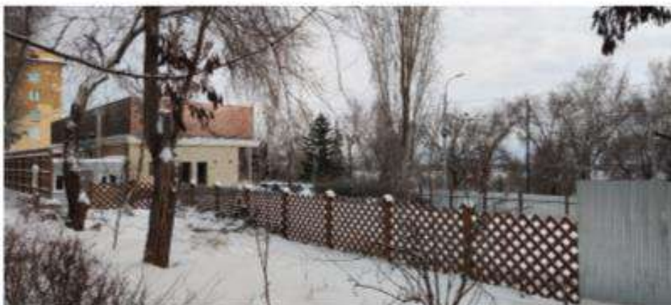
Фото 15. Вид на предполагаемое место возведения некапитального строения на территории объекта культурного наследия «Комплекс застройки ул. Советской».
