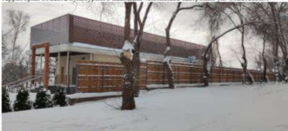
Фото 17. Вид на основное здание кафе на территории объекта культурного наследия «Комплекс застройки ул. Советской».
