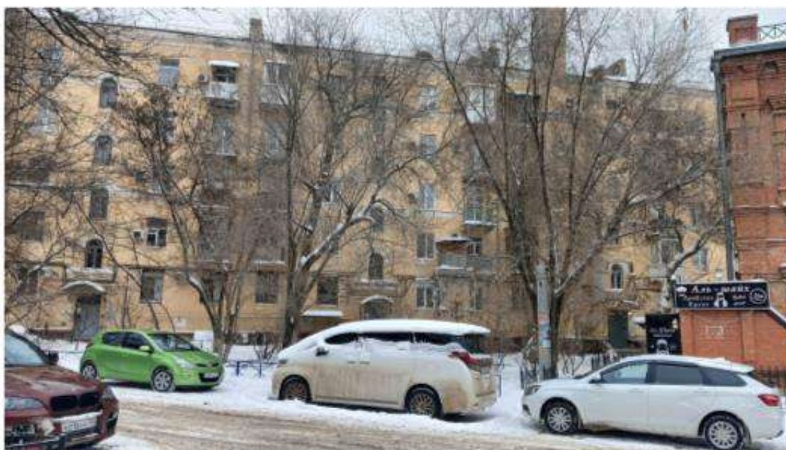
Фото 24. Вид с ул. Волгодонской на дворовой фасад жилого дома по 11, по ул. Комсомольской.
