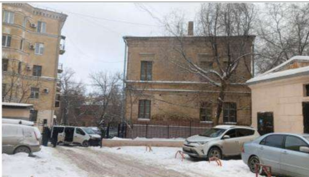
Фото 5. Вид с дворового пространства дома 16 по ул. Коммунистической на ОКН Дом купца Мишина (Вечерняя школа № 5, ул. Волгодонская, 13)
