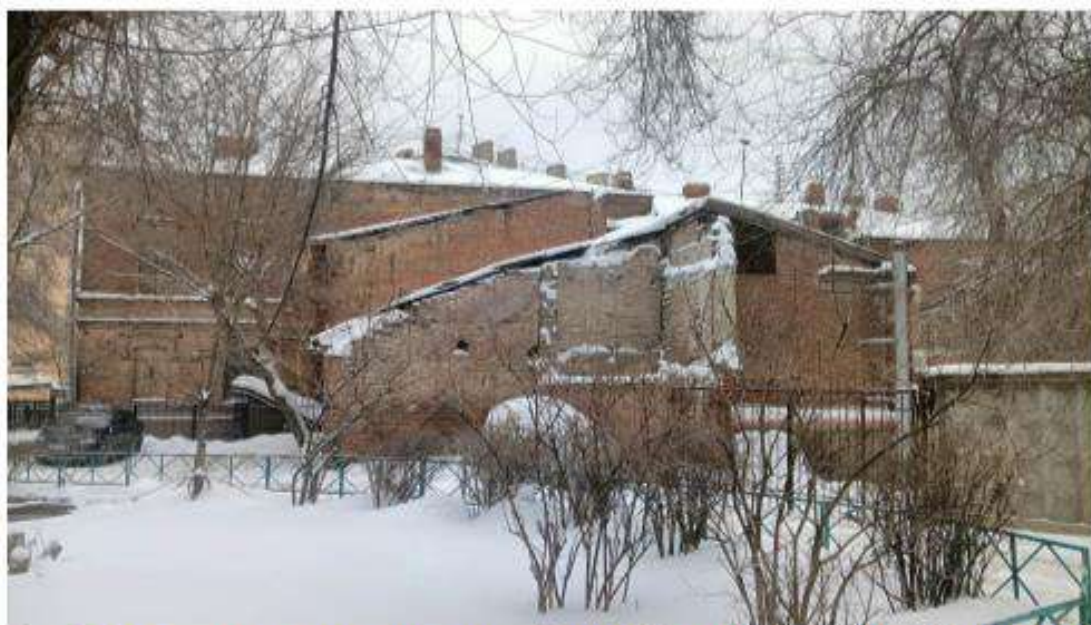
Фото 8. Вид с дворового пространства дома 16 по ул. Коммунистической на ОКН Дом купца Мишина (Вечерняя школа № 5, ул. Волгодонская, 13)
