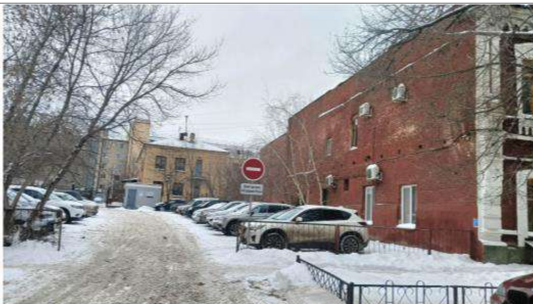
Фото 21. Вид с ул. Волгодонской на боковой фасад ОКН Дом купца Мишина (Волгоградский филиал Московского коммерческого университета), ул. Волгодонская, 11 и на здание детского сада по ул. Волгодонской 9а
