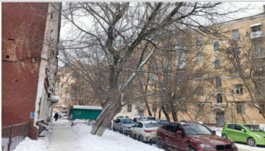
Фото 23. Вид с ул. Волгодонской на дворовой фасад жилого дома по 11, по ул. Комсомольской.
