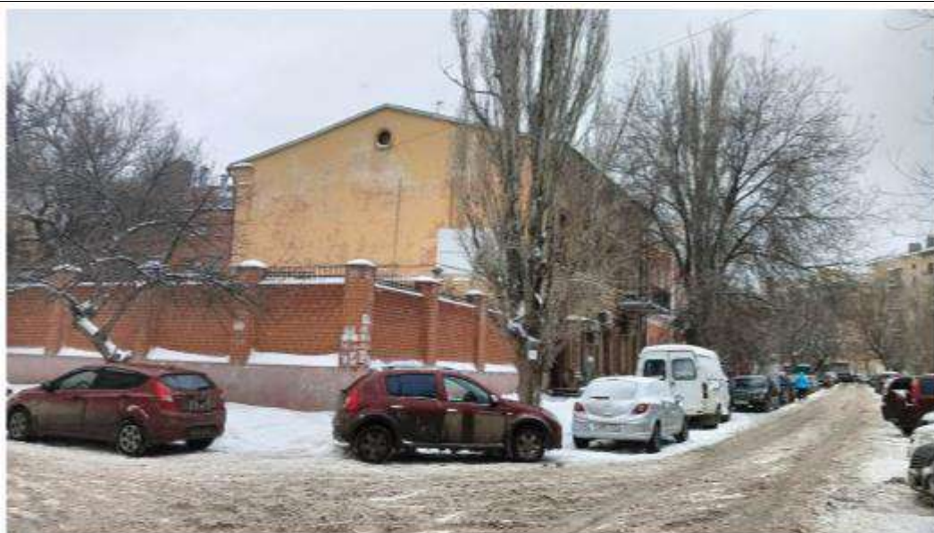
Фото 39. Вид с перекрестка ул. Волгодонской и ул. Пролеткультской на ОКН Дом купца Алексева, ул. Волгодонская, 5
