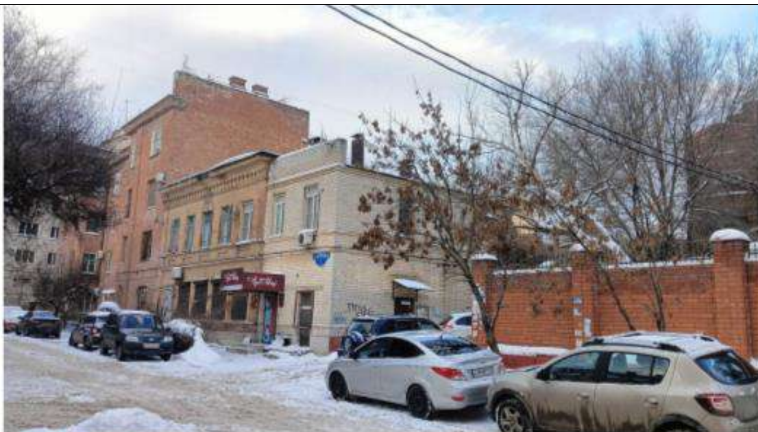
Фото 45. Вид с ул. Пролеткультской на застройку (ОКН Жилые дома (3) (Пункт вневедомственной охраны (ПЦН) ул. Пролеткультская, 5 и ОКН Жилой дом медиков ул. Пролеткультская, 3).
