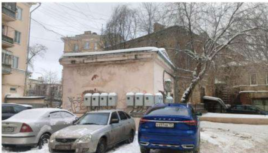
Фото 6. Вид с дворового пространства дома 16 по ул. Коммунистической на ОКН Дом купца Мишина (Вечерняя школа № 5, ул. Волгодонская, 13)
