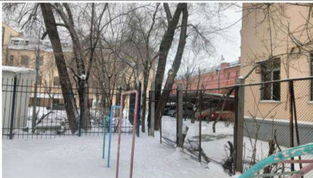
Фото 11. Вид с дворового пространства дома 16а по ул. Коммунистической на внутриквартальные ОКН Дом купца Мишина (Волгоградский филиал Московского коммерческого университета, ул. Волгодонская, 11)
