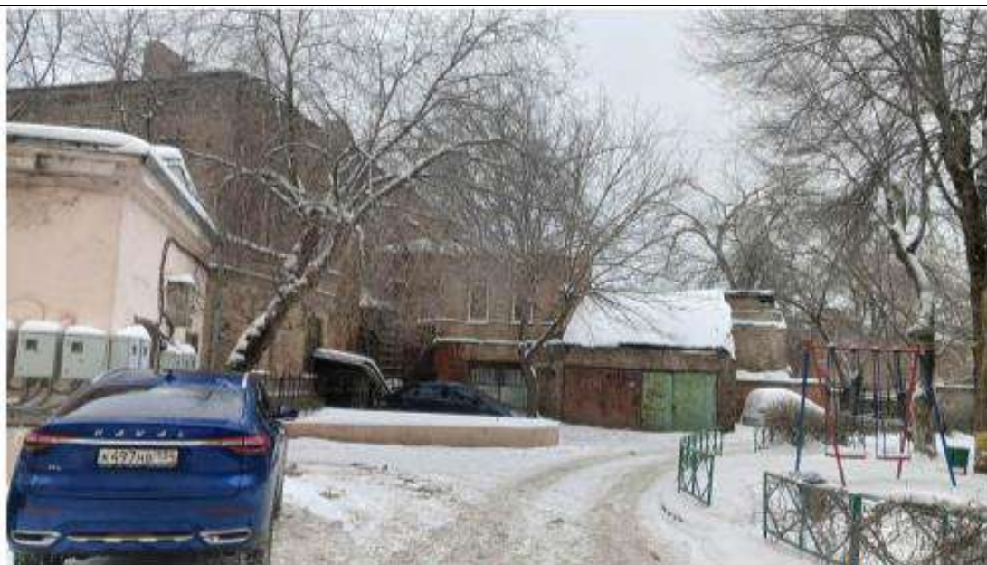
Фото 7. Вид с дворового пространства дома 16 по ул. Коммунистической на ОКН Дом купца Мишина (Вечерняя школа № 5, ул. Волгодонская, 13)
