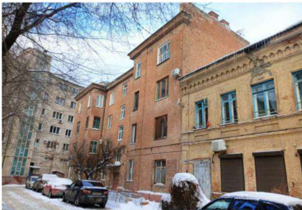
Фото 54. Вид с ул. Пролеткульской на застройку (ОКН Жилые дома (3) (Пункт вневедомственной охраны (ПЩН) ул. Пролеткульская, 5 и ОКН Жилой дом медиков ул. Пролеткульская, 3).
