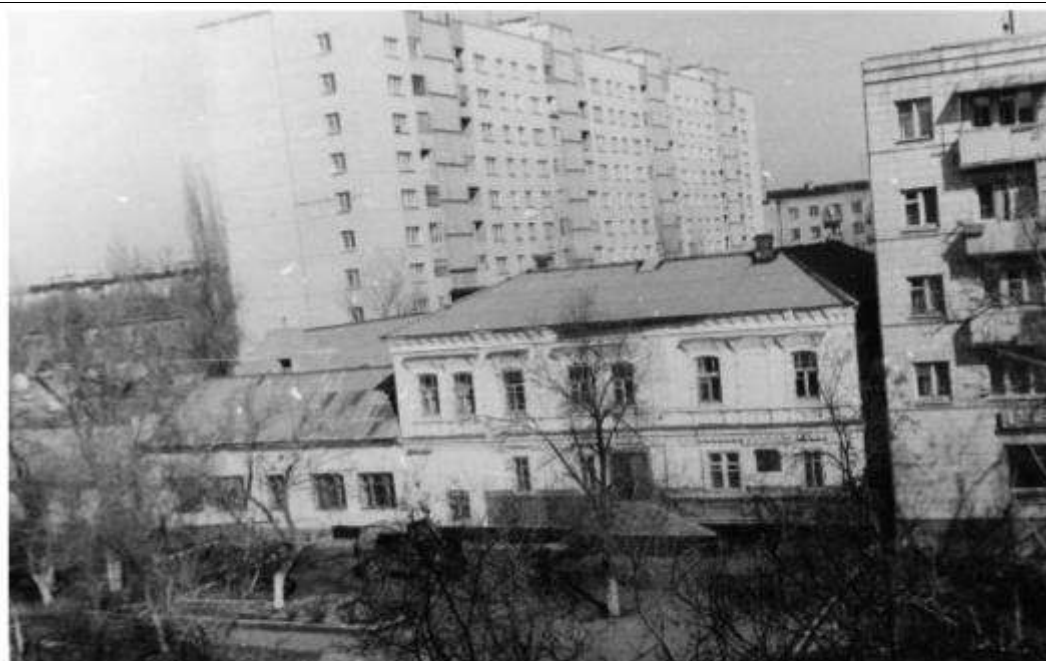
Исследуемый объект культурного наследия «Дом жилой купеческий (Военная комендатура)», кон. XIX в. 1990 г.
