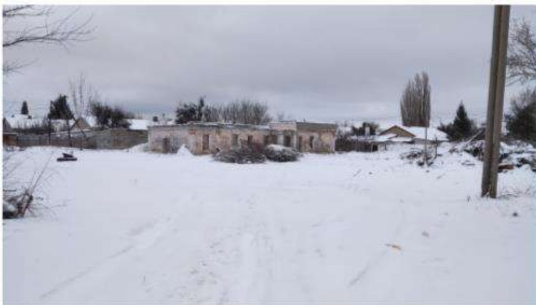
Фото 3. Вид на здание по ул. Пос. Metallургов, 20, являющееся элементом ОКН. Дата съемки: январь 2024 г.
