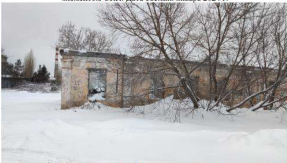
Фото 12. Вид на здание по ул. Пос. Metallургов, 20, являющееся элементом ОКН. Дата съемки: январь 2024 г.
