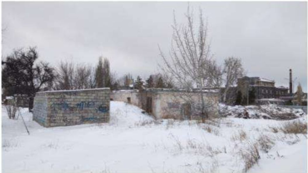
Фото 5. Вид на здание по ул. Пос. Metallургов, 20, являющееся элементом ОКН. Дата съемки: январь 2024 г.
