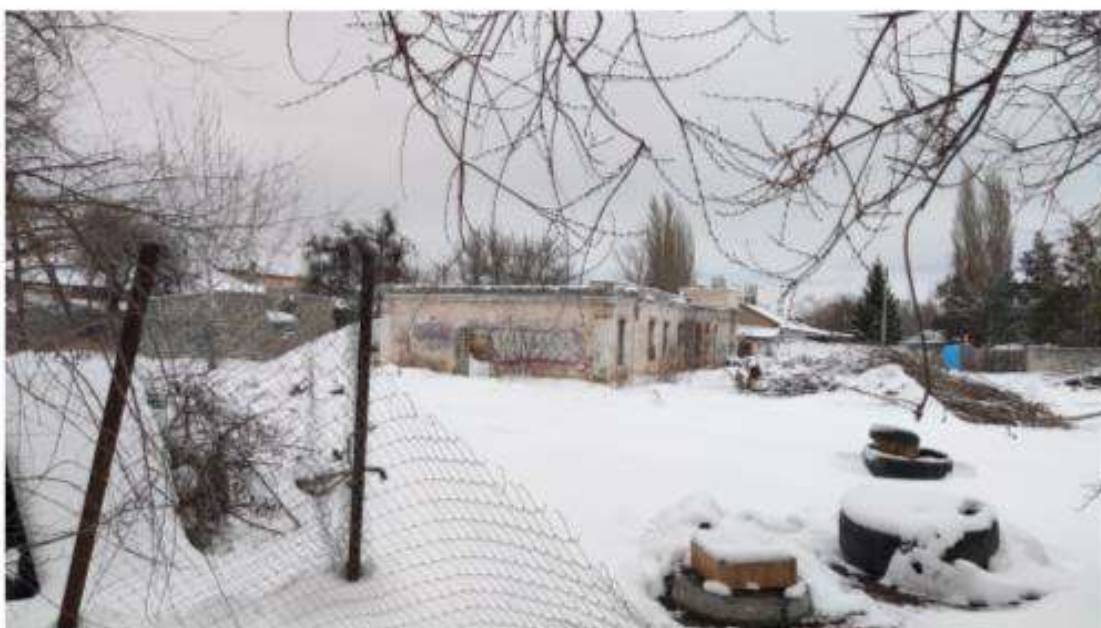
Фото 4. Вид на здание по ул. Пос. Metallургов, 20, являющееся элементом ОКН. Дата съемки: январь 2024 г.
