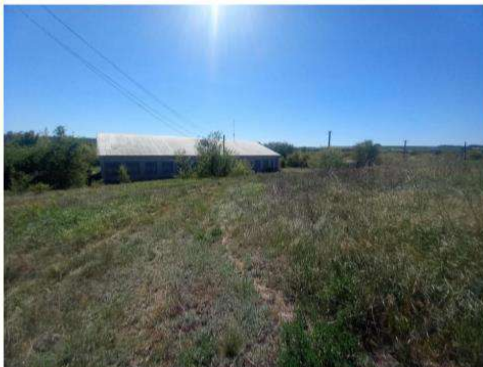
Фото 21. Вид на окружающую территорию. Дата съемки: Май 2024.
