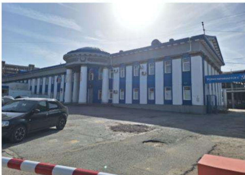
Фото №8. Вид на территорию объекта культурного наследия с северо-запада «Ансамбль спорткомплекса стадиона «Динамо» расположенного по адресу: г. Волгоград, Центральный район, ул. Новороссийская, 2.
