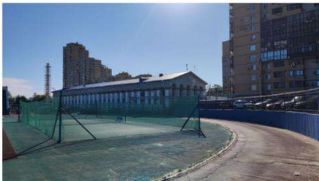
Фото №1. Вид на территорию объекта культурного наследия с востока «Ансамбль спорткомплекса стадиона «Динамо» расположенного по адресу: г. Волгоград, Центральный район, ул. Новороссийская, 2.
