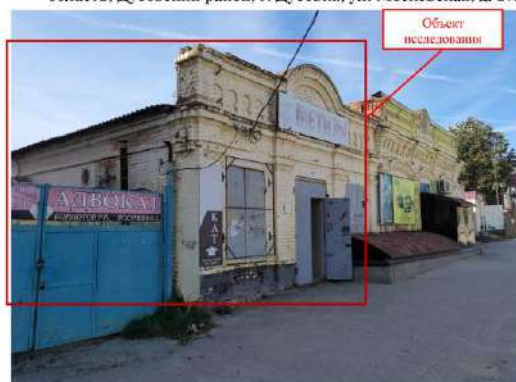
Ф.1. Главный северо-восточный фасад.
