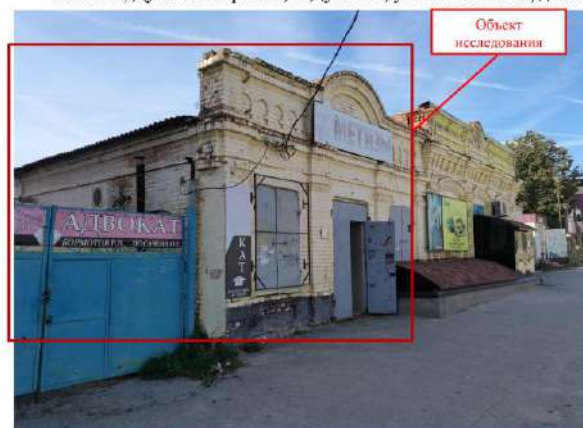
Ф.1. Главный северо-восточный фасад.
