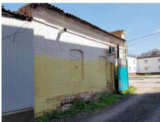
Ф. 18. Юго-восточный фасад (вид на дверной и оконный проемы)
