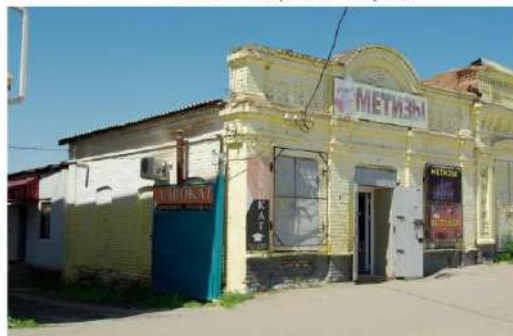
Ф.2. Северо-восточный и юго-восточный фасады.
