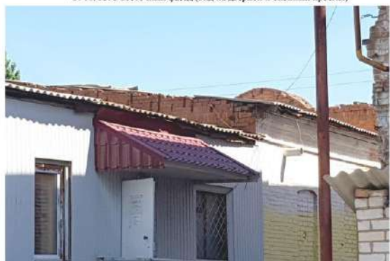
Ф. 19. Вид на современную пристройку.
