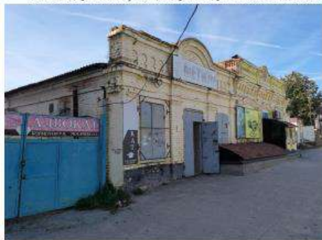
Ф.1. Главный северо-восточный фасад
