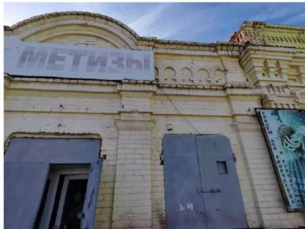
Ф.3. Фрагмент северо-восточного фасада. Аттиковая стенка, карниз, фриз.
