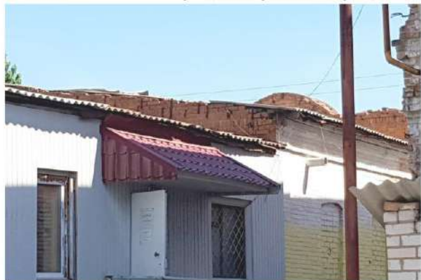
Ф. 19. Вид на современную пристройку.
