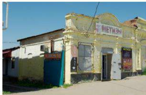
Ф.2. Северо-восточный и юго-восточный фасады.
