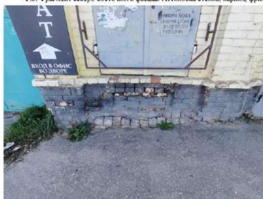
Ф. 4. Вид на цокольный карниз.
