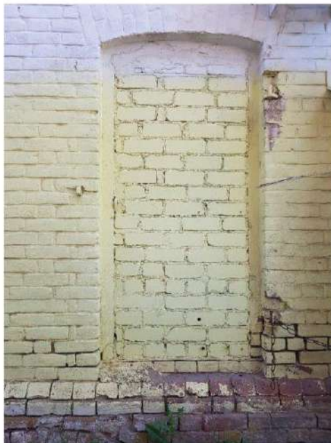
Ф. 17. Фрагмент юго-восточного фасада, заложенный дверной проем.
