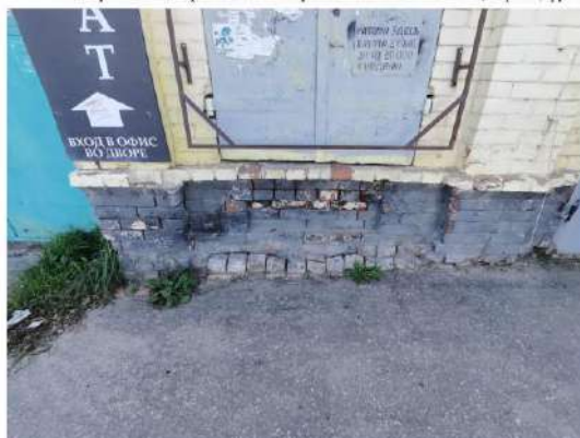
Ф. 4. Вид на поковый карниз.
