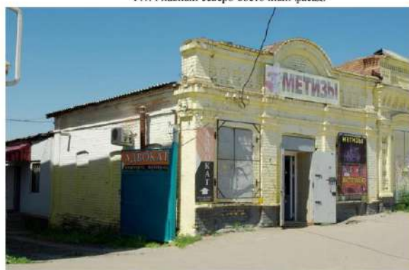
Ф.2. Северо-восточный и юго-восточный фасады.
