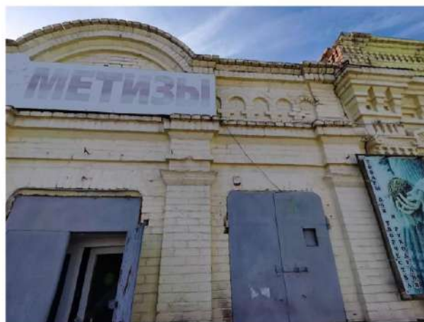
Ф.3. Фрагмент северо-восточного фасада. Аттиковая стенка, карниз, фриз.
