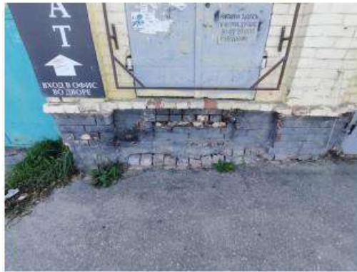
Ф. 4. Вид на цокольный карниз.
