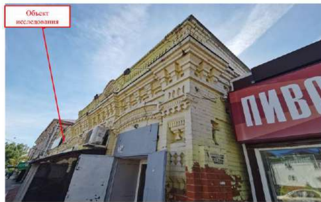
Ф. 7. Вид на детали фасада с северо-восточной стороны
