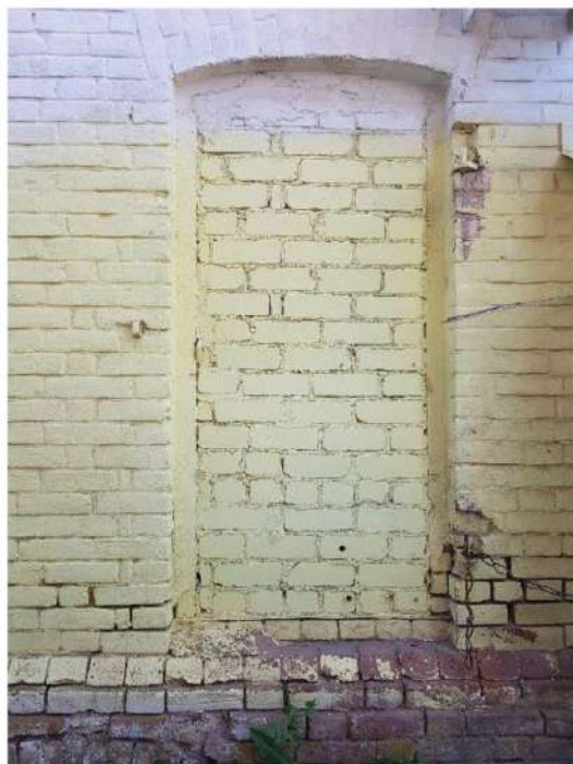
Ф. 17. Фрагмент юго-восточного фасада, заложенный дверной проем.
