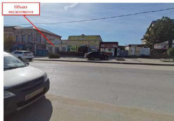
Ф. 11. Вид на объект и прилегающую территорию с противоположной стороны ул. Московская
