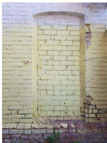
Ф. 17. Фрагмент юго-восточного фасада, заложенный дверной проем.
