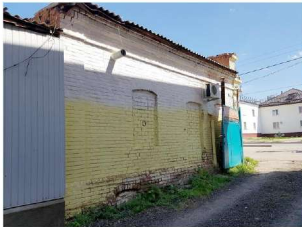
Ф. 18. Юго-восточный фасад (вид на дверной и оконный проемы)
