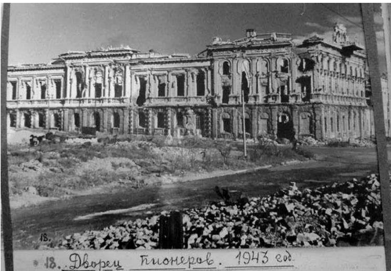
Илл. 16. Разрушенный Дворец Пионеров. 1943 г.
