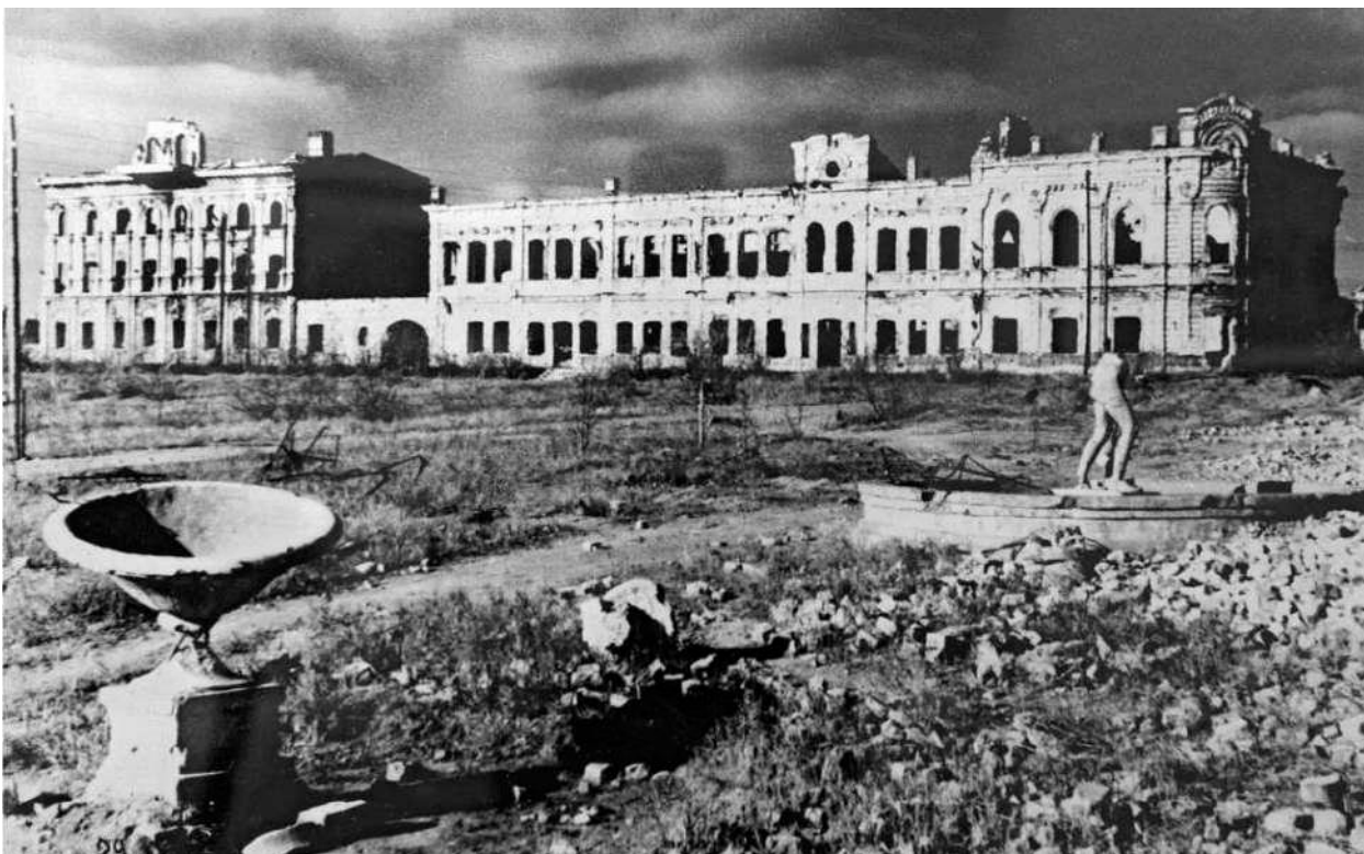
Илл. 15. Разрушенные здания Дома пионеров и городской статистики Сталинграда. 1942-1945 гг.
