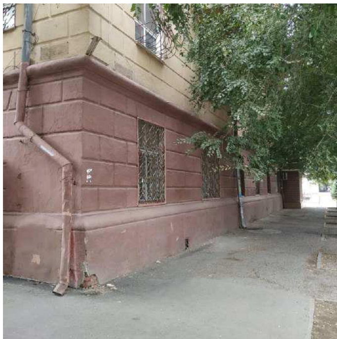
Фото №1. Фасад дома по ул. Маршала Чуйкова.
