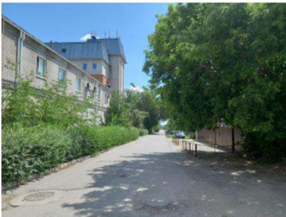
Фото 13. Вид на окружающую территорию. Дата съемки: 23 июня 2024 г.
