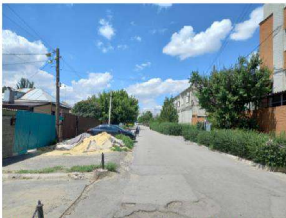
Фото 12. Вид на окружающую территорию. Дата съемки: 23 июня 2024 г.
