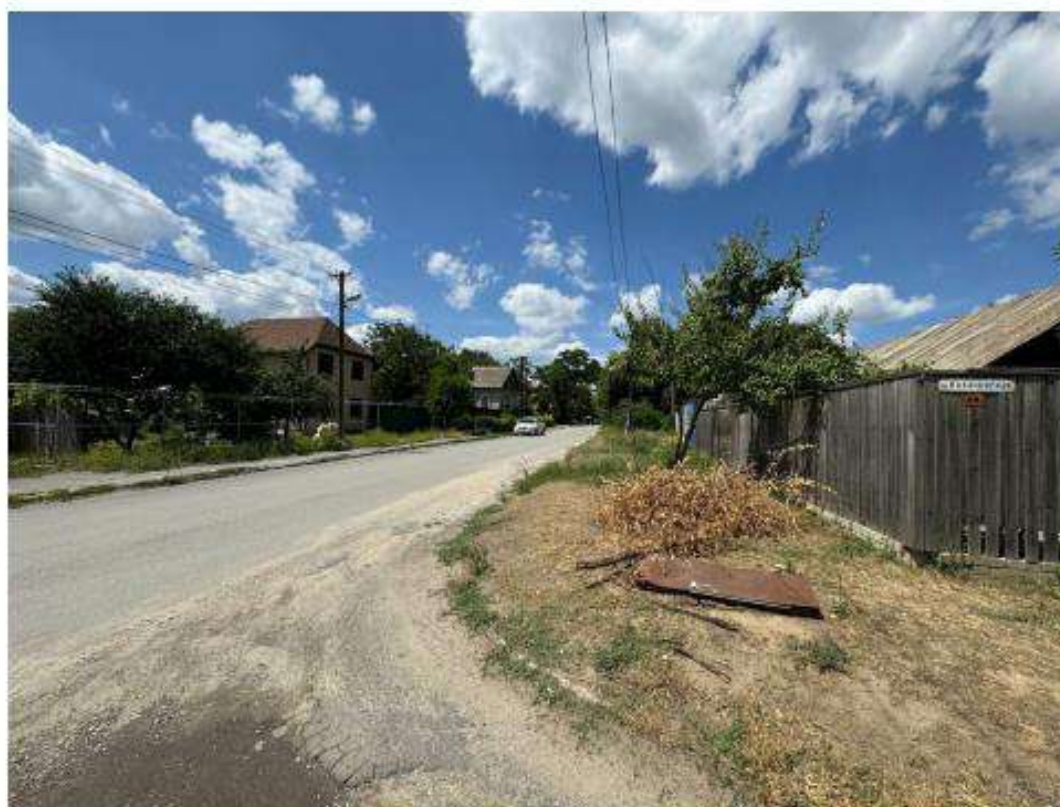
Фото 22. Вид на окружающую территорию. Дата съемки: 23 июня 2024 г.
