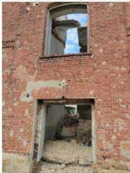
Ф. 16. Фрагмент южного фасада с дверным проемом входа с клинкерными перемычками
