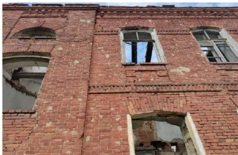
Ф. 15. Фрагмент южного фасада оконных проемов с подлинными рамами
