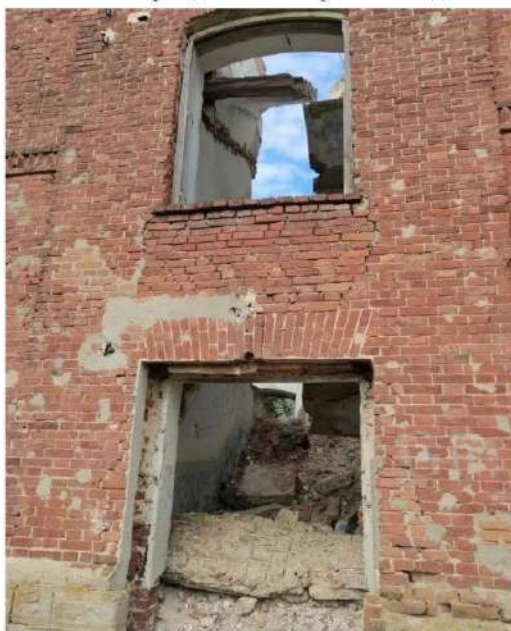
Ф. 16. Фрагмент южного фасада с дверным проем входа с клинчатыми перемычками
