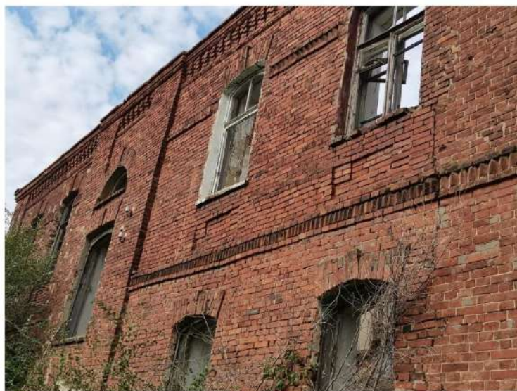
Ф. 17. Фрагмент южного фасада с ризалитом
