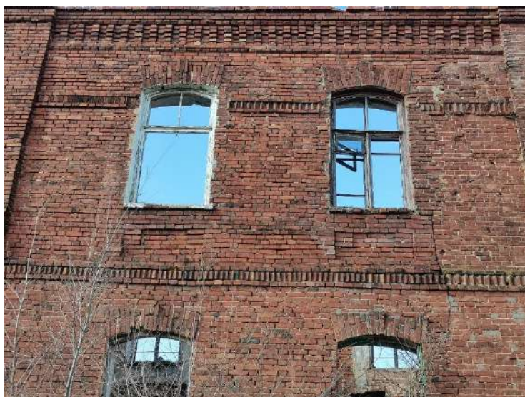
Фрагмент южного фасада оконных проемов с подлинными рамами.
