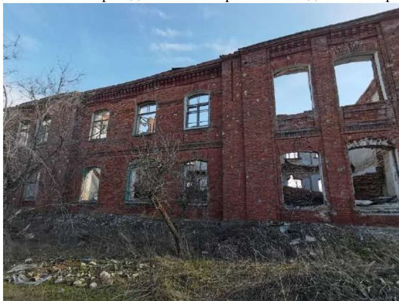
Фрагмент северного фасада с боковыми ризалитами.
