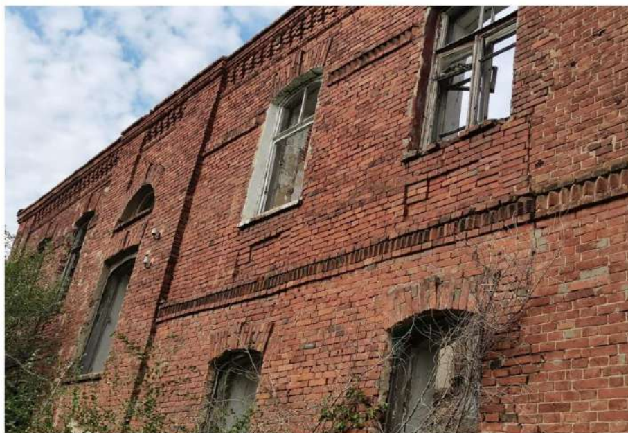
Ф. 17. Фрагмент южного фасада с ризалитом
