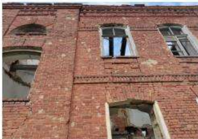
Ф.15. Фрагмент южного фасада оконных проемов с подлинными рамами
