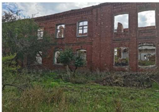
Ф. 7. Фрагмент северного фасада
