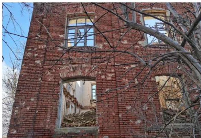
Т.8. Фрагмент северного фасада оконные проемы с выступающими лучковыми перемычками
