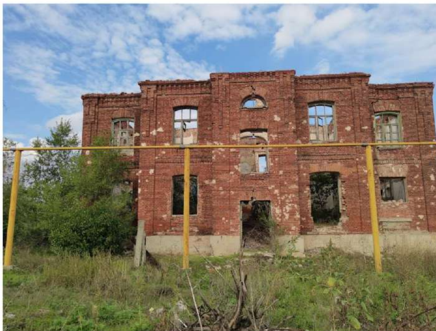
Ф.1. Вид на южный фасад с ул. Станционная
