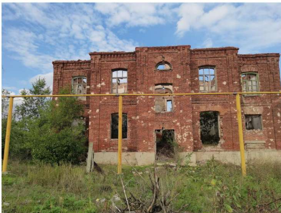
Ф.1. Вид на южный фасад с ул. Станционная
