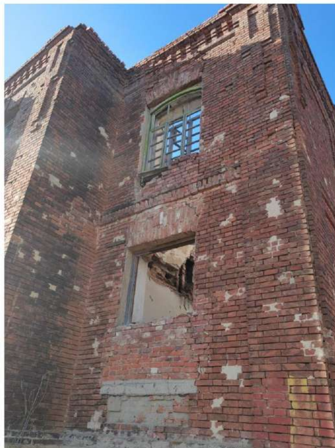
Ф.3. Фрагмент южного фасада оконных проемов с подлинными рамами
