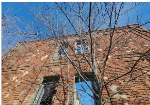
Т.15 Фрагмент западного фасада оконных проемов с подлинными рамами.
