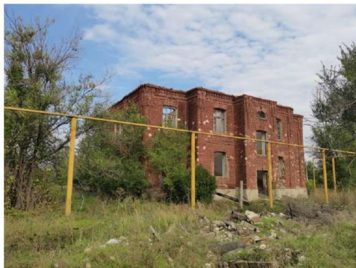
Ф.18. Вид с юго-запада с ул. Станционная
