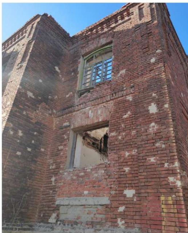
Ф.3. Фрагмент южного фасада оконных проемов с подлинными рамами
