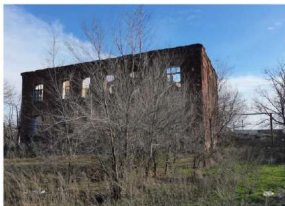
Т.11. Вид на главный северный фасад и прилегающую территорию с территории железнодорожной дороги
