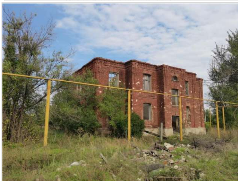
Ф.18. Вид с юго-запада с ул. Станционная
