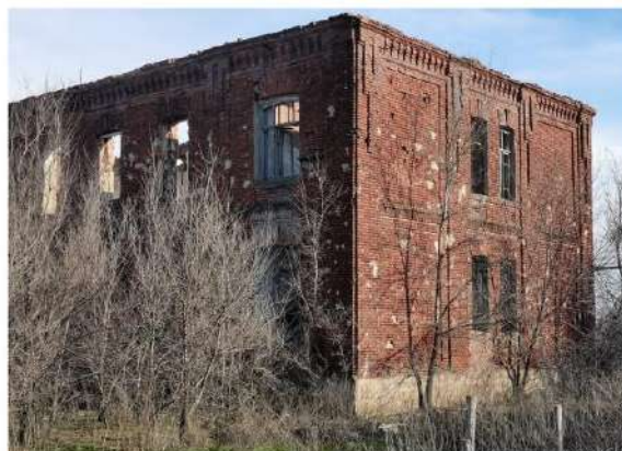
Т. 12 Фрагмент северного фасада и западного фасада
