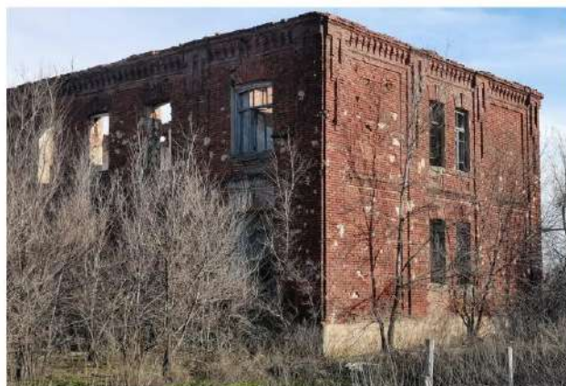
Т. 12 Фрагмент северного фасада и западного фасада
