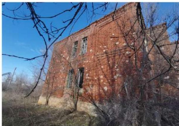
Т. 14 Западный фасад с юго-запада
