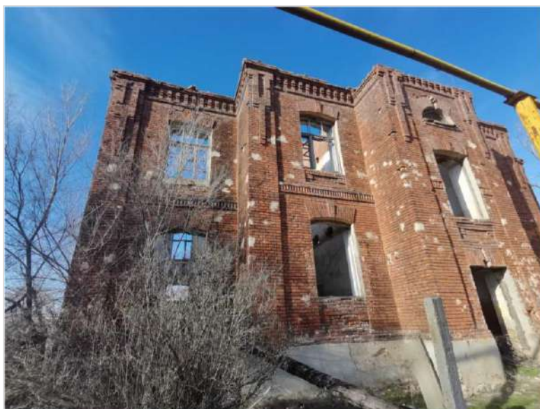
Т.16 Фрагмент южного фасада с юго-запада
