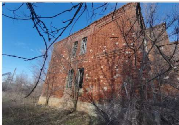
Т. 14 Западный фасад с юго-запада
