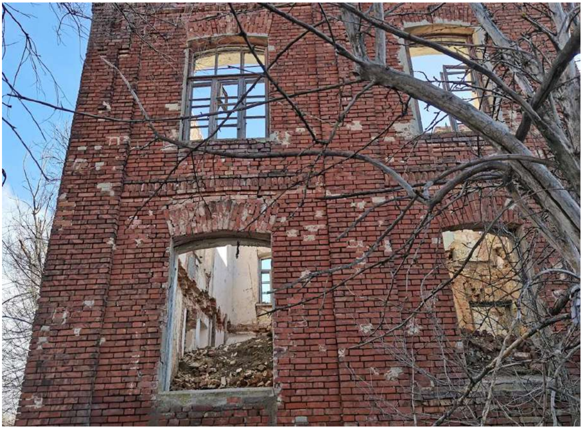
Фрагмент главного северного фасада оконных проемов с подлинными рамами.
