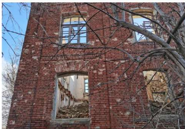
Г.8. Фрагмент северного фасада оконные проемы с выступающими дучковыми перемычками
