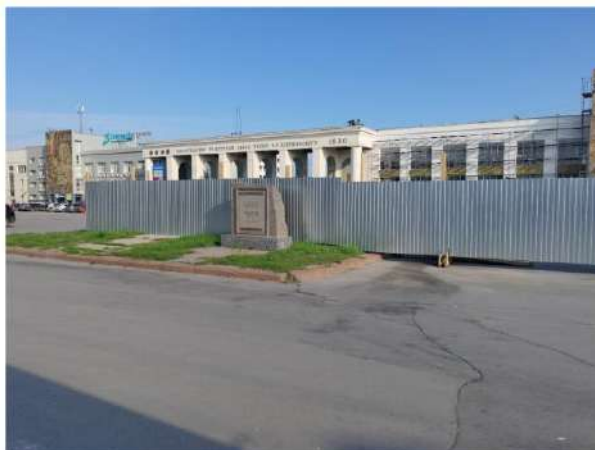
Ф. 14. Вид с юго-западной стороны
