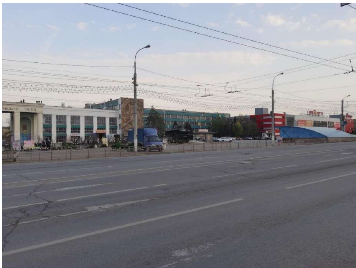
Вид на объект и территорию исследования с северо-запада.
