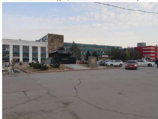
Ф.10. Вид на объект и территорию исследования с западной стороны
