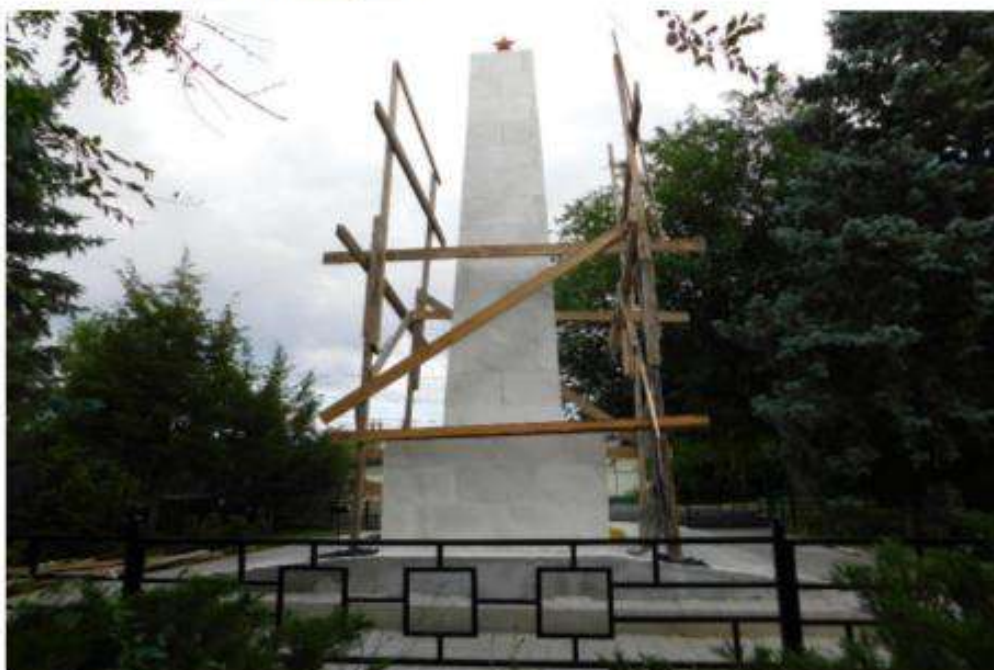
Съемочная точка №13 (10.07.2024 г. автор Макарычева Е.Г.) Вид с юго-восточной стороны.
