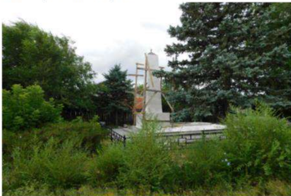
Съемочная точка №7 (10.07.2024 г. автор Макарычева Е.Г.) Вид с северо-восточной стороны.
