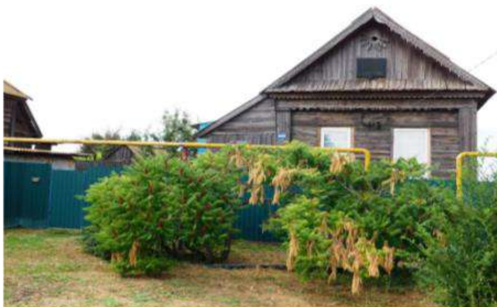
Съемочная точка №24 Вид на объект культурного наследия регионального значения (достопримечательное место) «Жилой дом, в котором находился Военный Совет и штаб Сталинградского фронта», расположенный по адресу: Волгоградская область, Светлоярский район, с. Райгород, ул. Советская, д.243 (08.07.2024г. автор Запорожская Л.М.)
